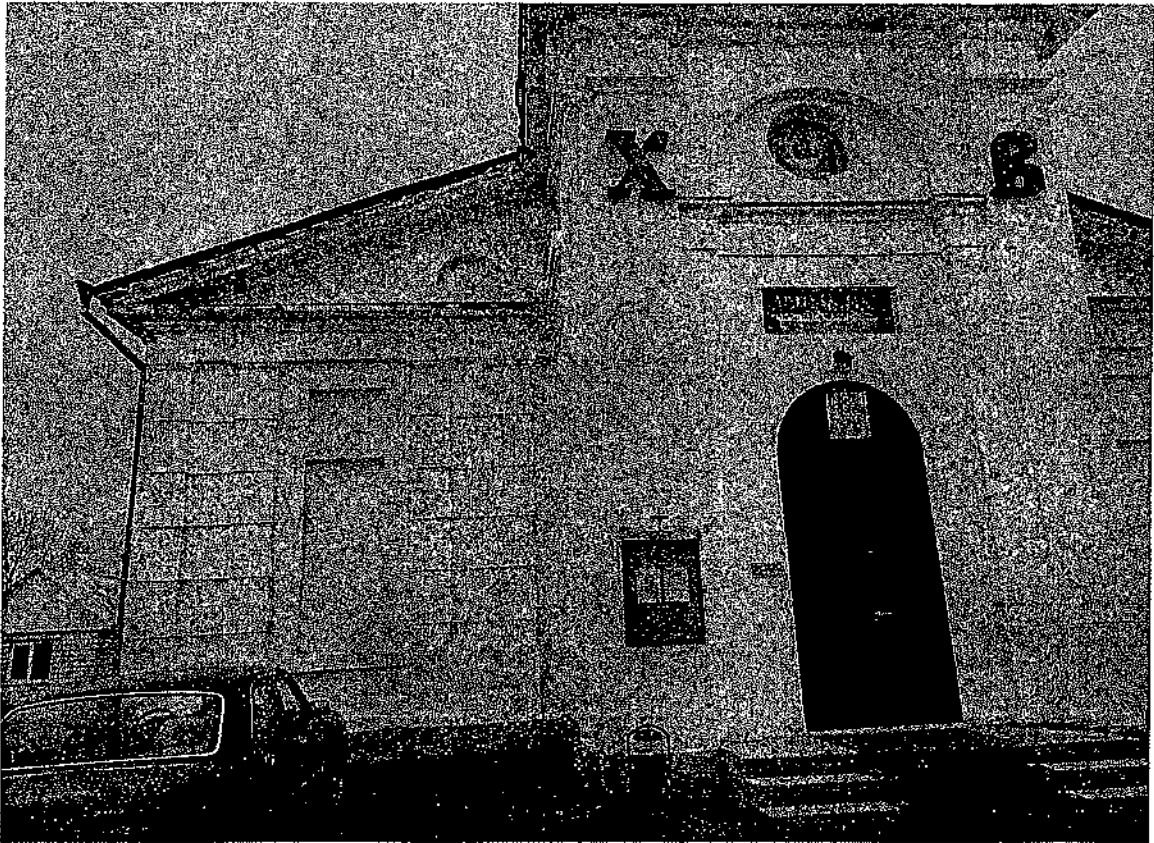
Фото 9. Фрагмент западного фасада
