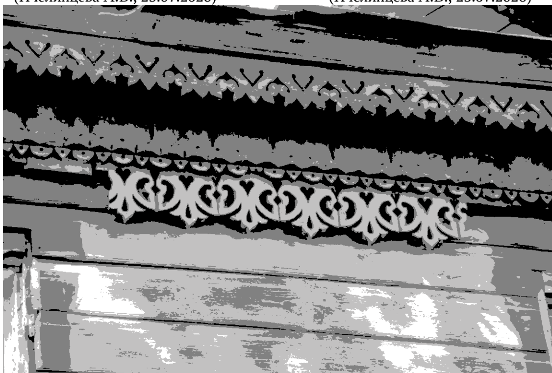
Видовая точка № 6. Фрагмент декора карниза мезонина восточного фасада (Пчелинцева А.В., 23.07.2026)
