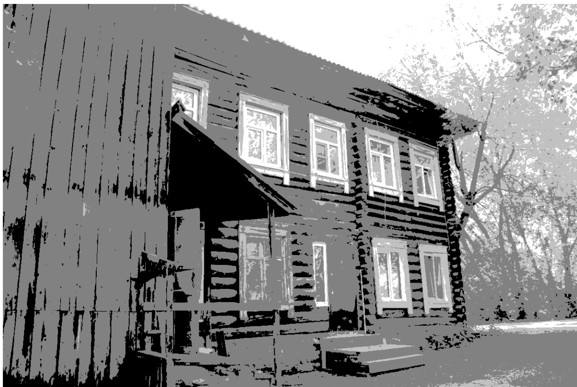
Видовая точка № 5. Фрагмент восточного фасада здания
