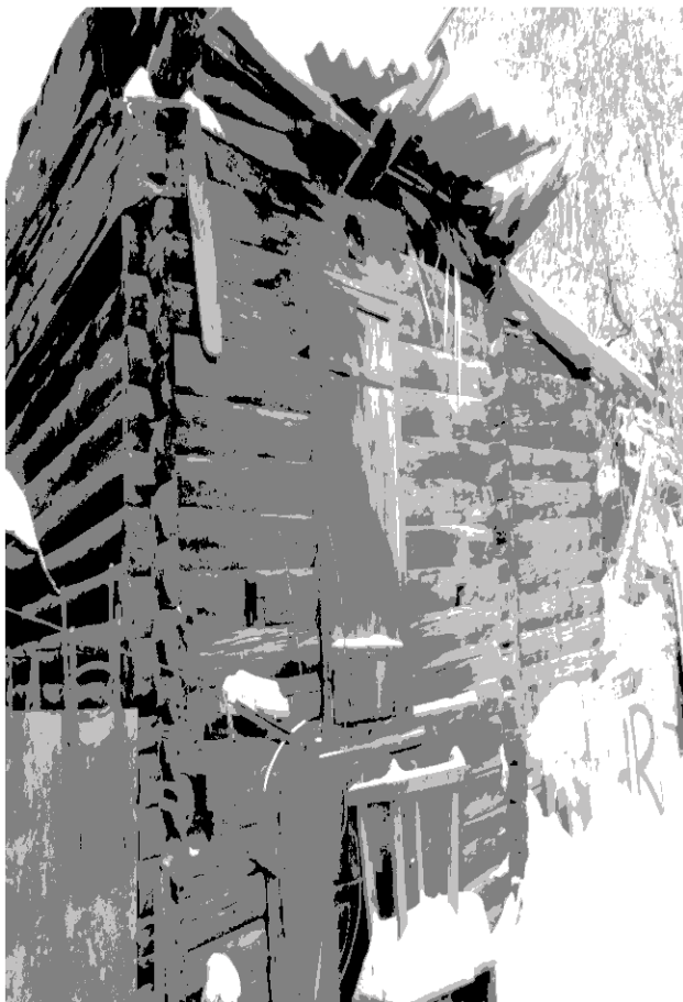
Видовая точка № 23. Амбары. Нижние венцы из брёвен, верхние из полу брёвен
