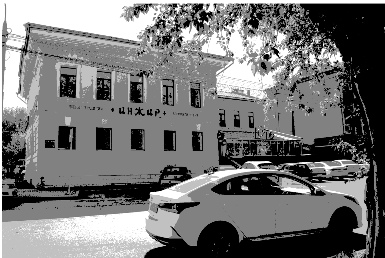
Видовая точка № 4. Западный фасад здания, вид с ул. Гагарина
