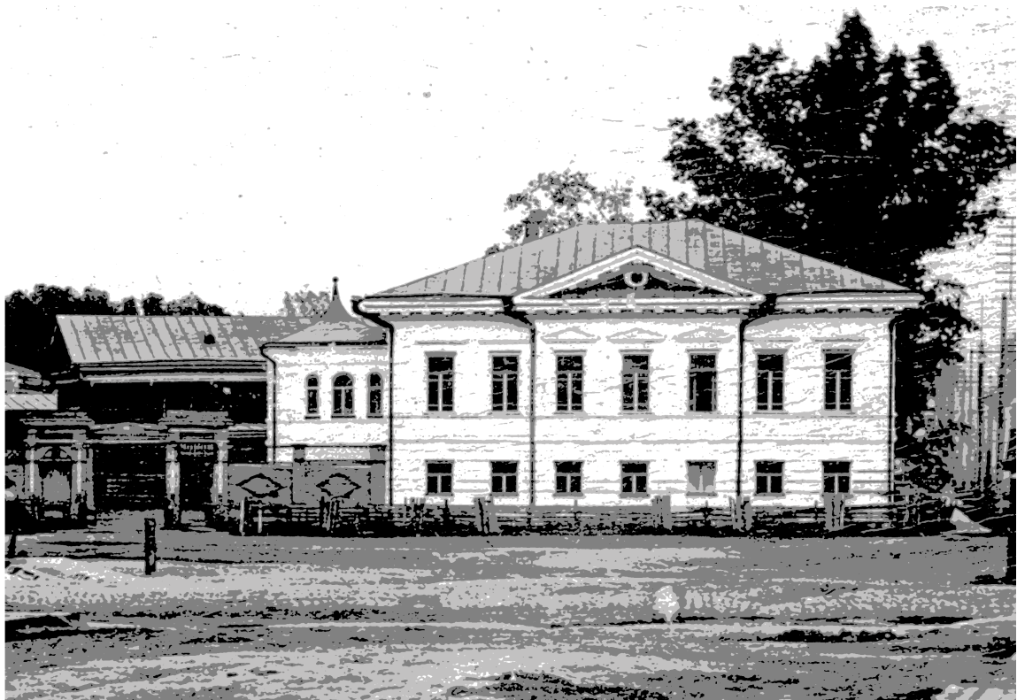
Видовая точка № 10. Общий вид здания с северной стороны (кон. XIX в.), ТОКМ
