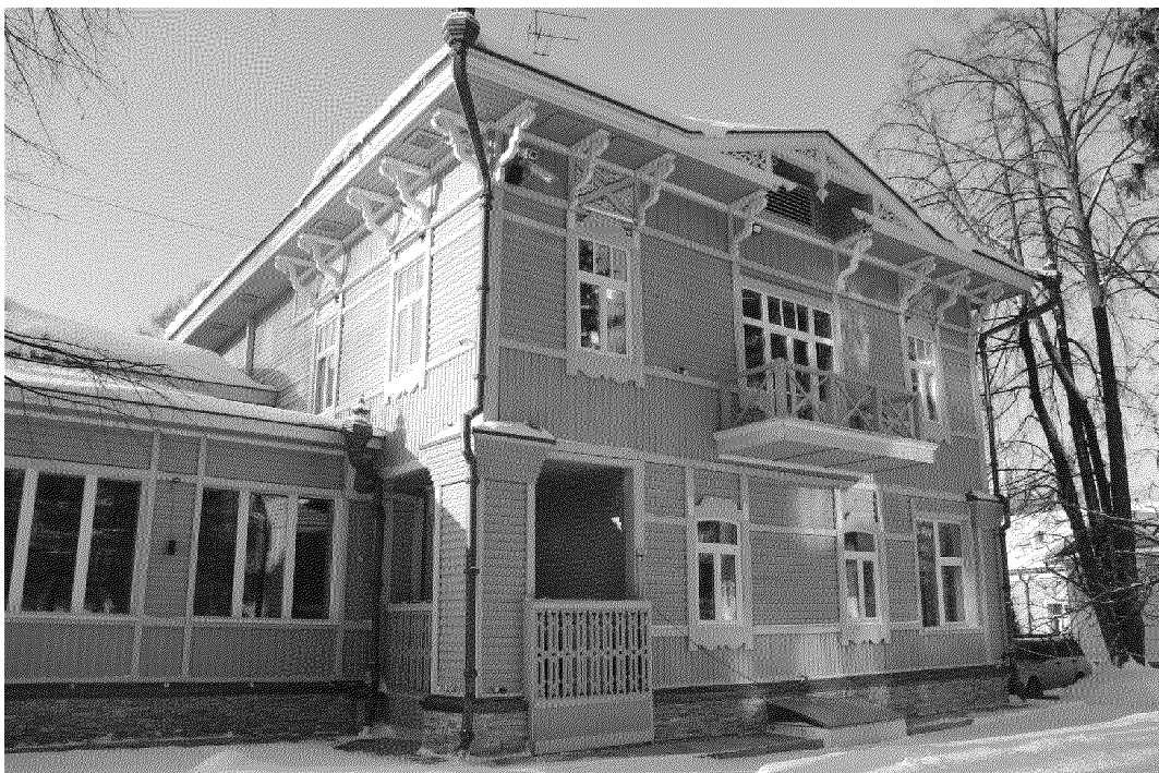
Видовая точка № 2. Фрагмент восточного фасада здания
