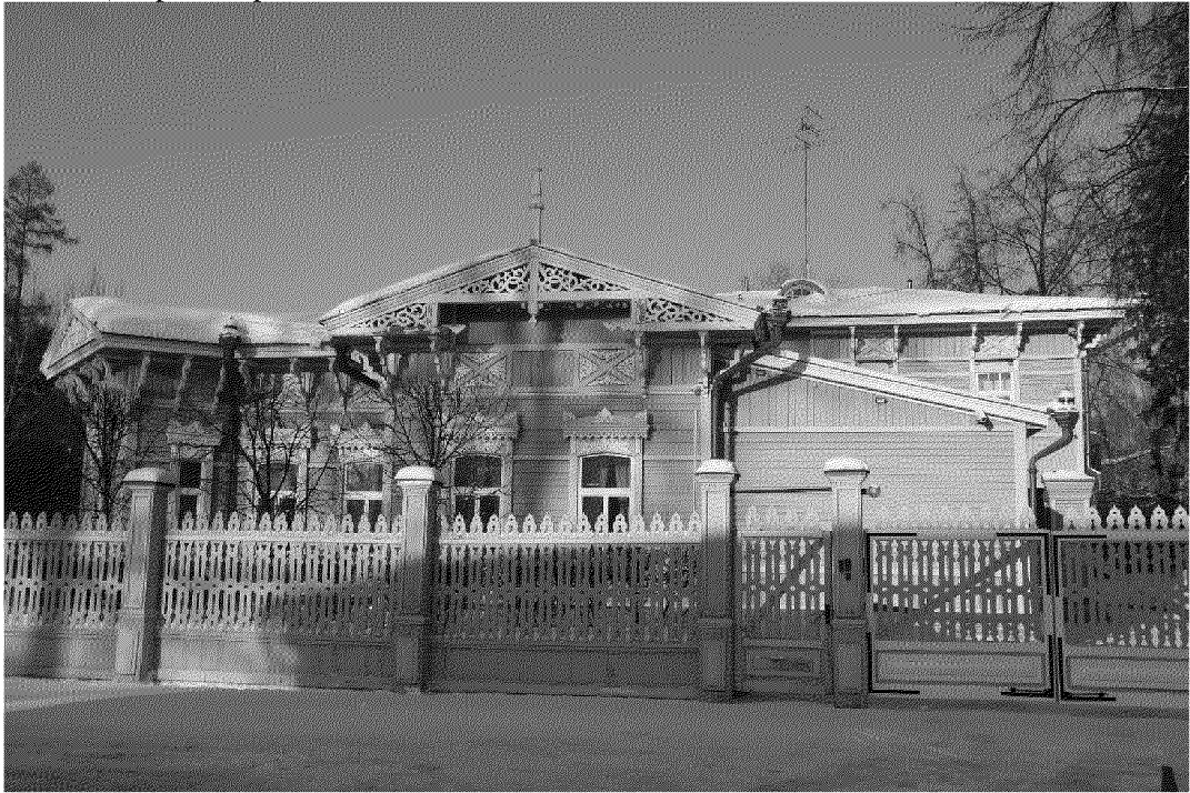
Видовая точка № 1. Южный фасад здания
