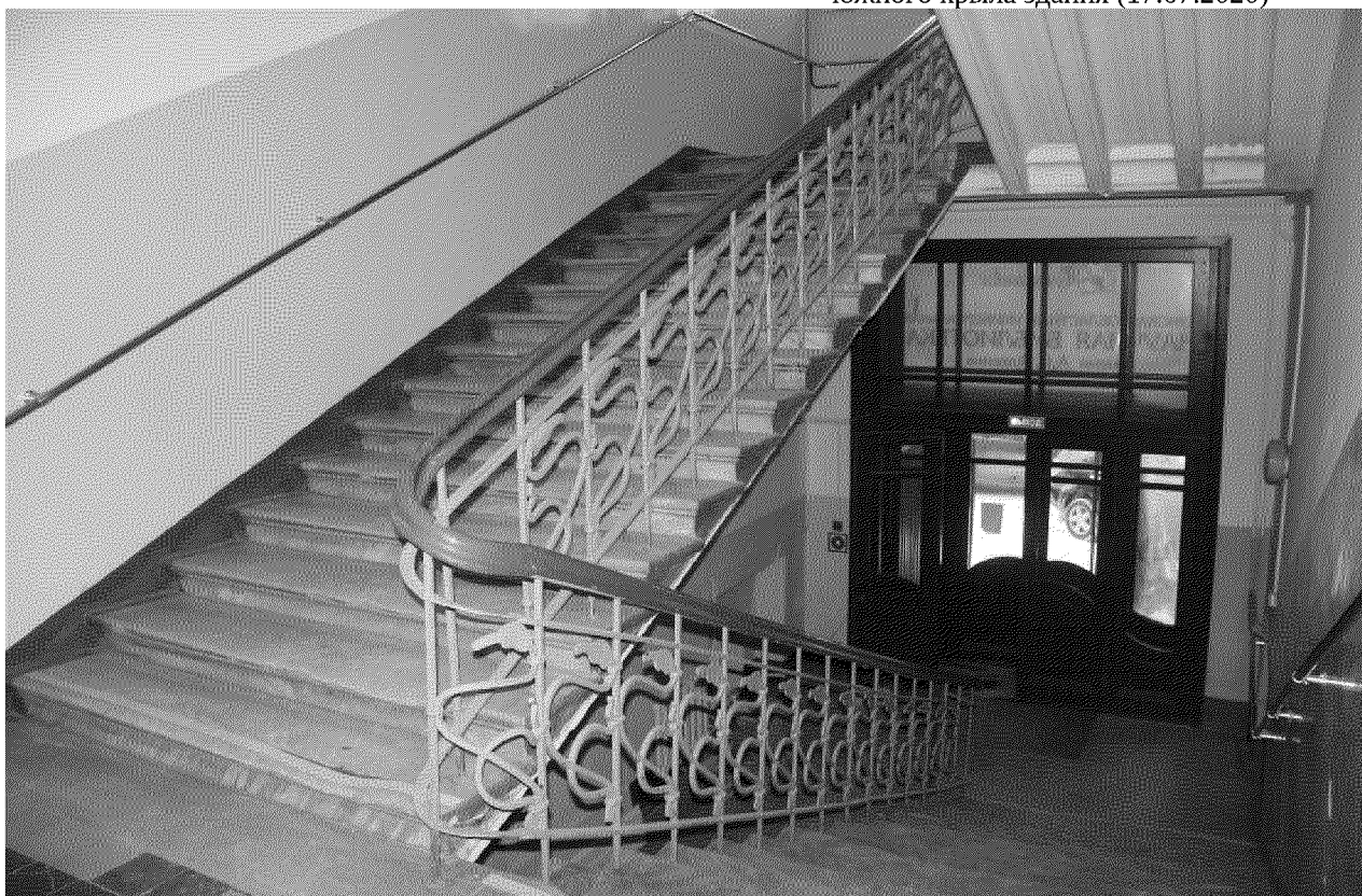
Видовая точка № 34. Лестница восточного крыла здания, двухмаршевая со ступенями из мрамора и кованым ограждением (17.07.2020)
