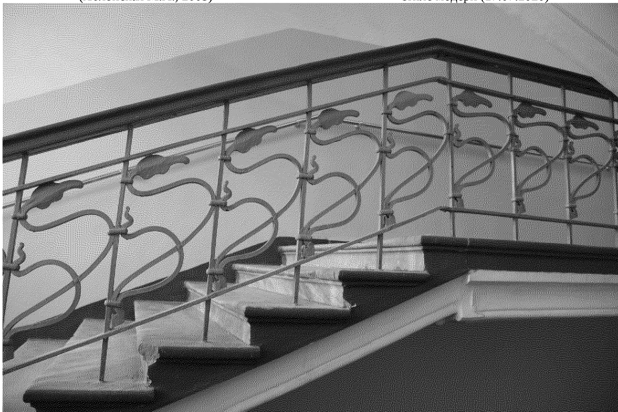
Видовая точка № 40. Лестница восточного крыла с мраморными ступенями. Кованое ограждение в стиле модерн (26.11.2020)
