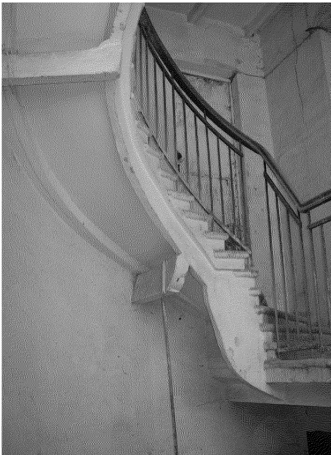
Видовая точка № 38. Фрагмент лестницы юго-восточной части здания (Яблонская М.А., 2005)
