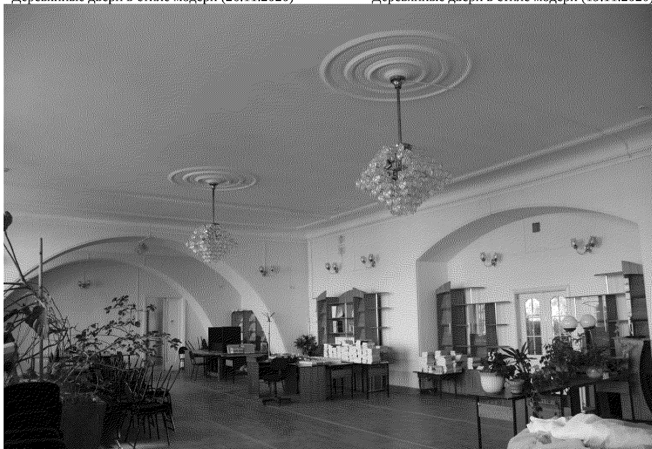
Видовая точка № 43. Интерьер зального помещения восточного крыла (библиотека). Полуциркульные и лучковые арки. Профильный штукатурный декор потолка и потолочные розетки (26.11.2020)
