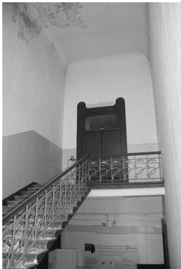
Видовая точка № 39. Лестничная площадка 3-го этажа. Деревянная дверь в стиле модерн (17.07.2020)
