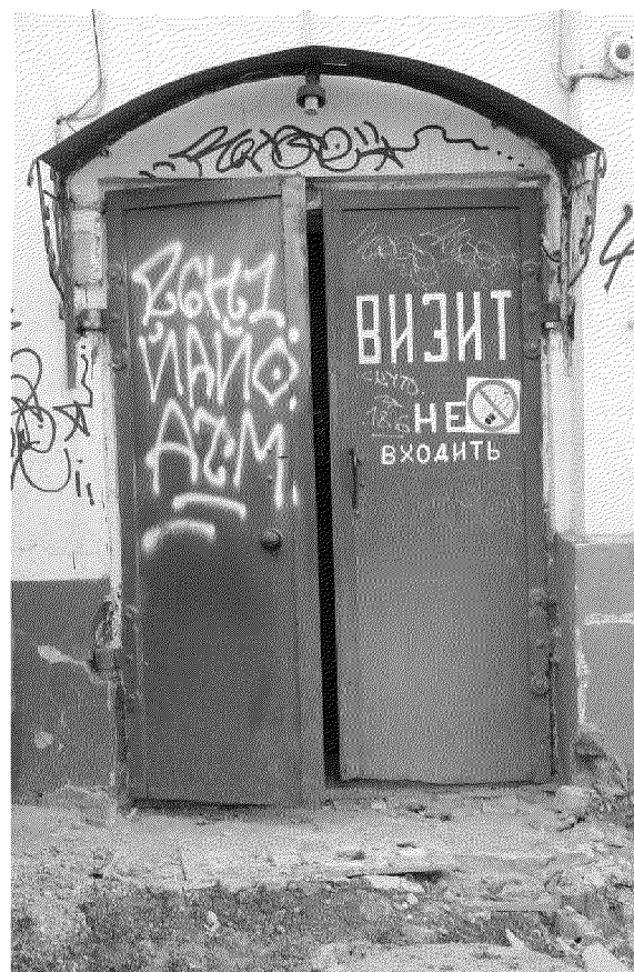
Видовая точка № 58. Металлические двери дворового входа на 1 этаж (14.05.2020)
