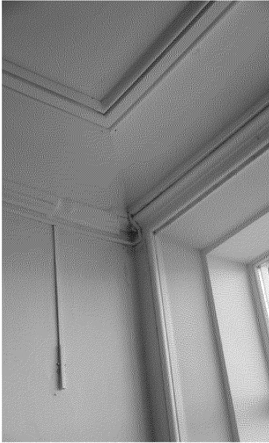
Видовая точка № 46. Профильный штукатурный декор потолка и откоса оконного проема (26.11.2020)
