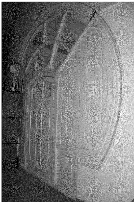
Видовая точка № 53. Деревянная перегородка углового помещения с дверью, остекленной фрамугой и профильным обрамлением проема (19.11.2020)
