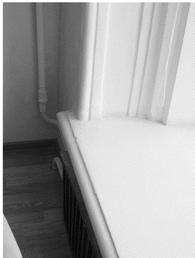
Видовая точка № 26. Фрагмент профильного обрамления откоса оконного проема, профильный подоконник (19.10.2012)
