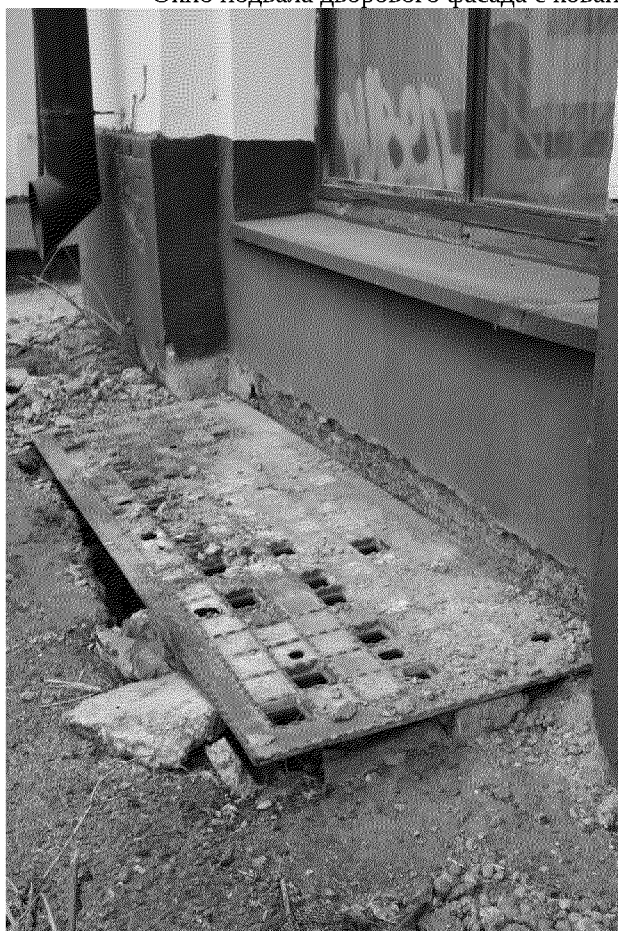
Видовая точка № 62. Металлическая решетка приемка подвального окна (14.05.2020 г.)
