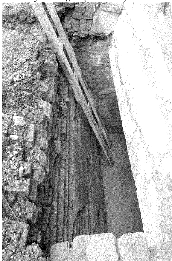
Видовая точка № 59. Прямо́к окна подвала южного дворового фасада (14.05.2020)
