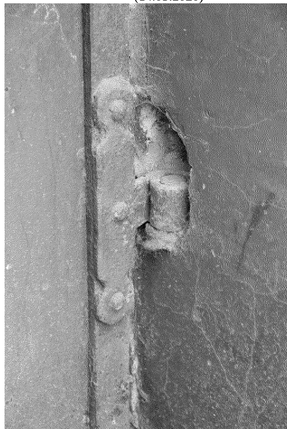
Видовая точка № 60. Фрагмент крепления металлической двери, кованый подстав и навес (14.05.2020)
