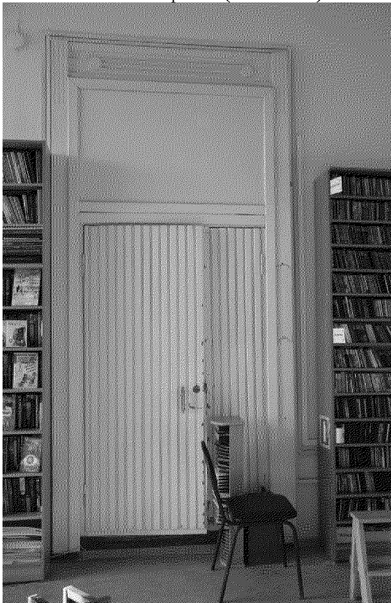
Видовая точка № 48. Обрамление дверного проема с современным декором (26.11.2020)
