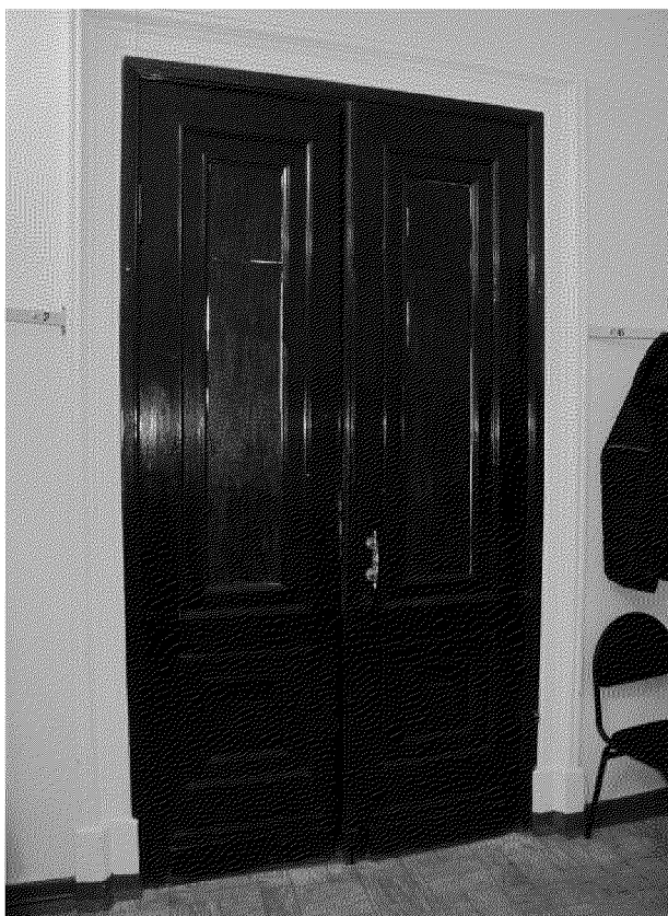
Видовая точка № 25. Деревянная филенчатая дверь, профильное обрамление проема (19.10.2012)
