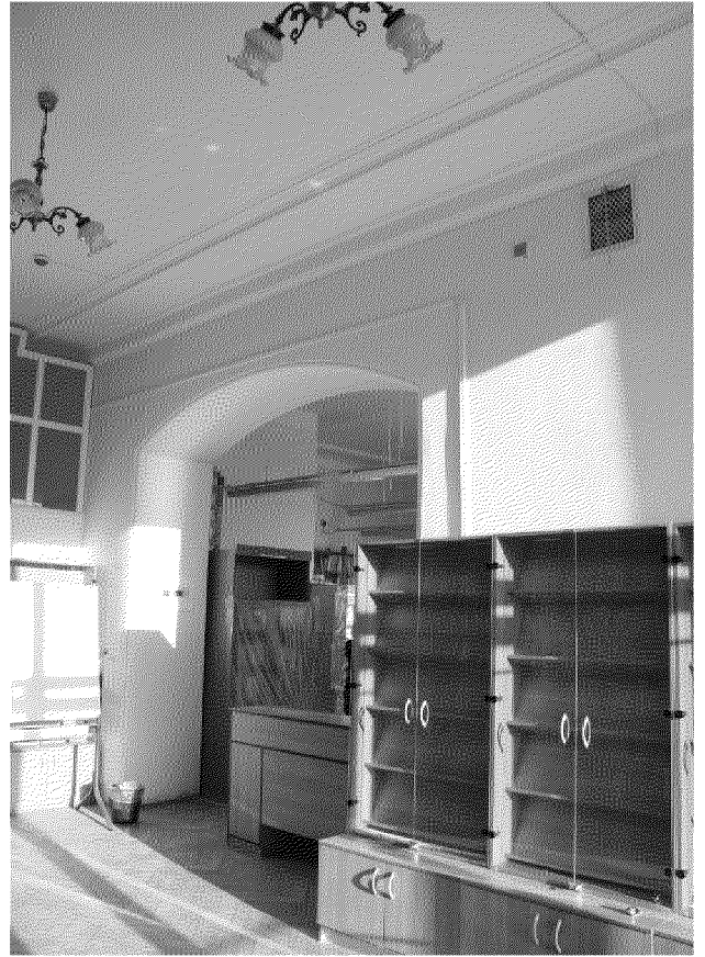
Видовая точка № 47. Общий вид помещения библиотеки, лучковая арка (26.11.2020)
