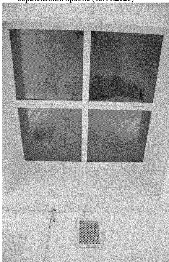
Видовая точка № 55. Восточное крыло здания. Световой фонарь коридора 3-го этажа (19.11.2020)
