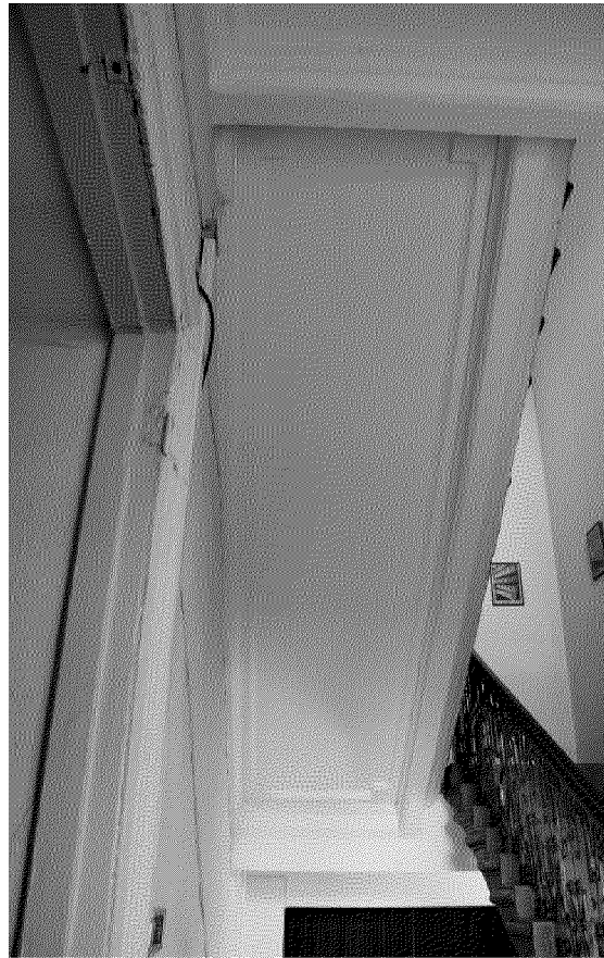
Видовая точка № 15. Штукатурные тяги в отделке лестничных маршей и площадки парадной лестницы
