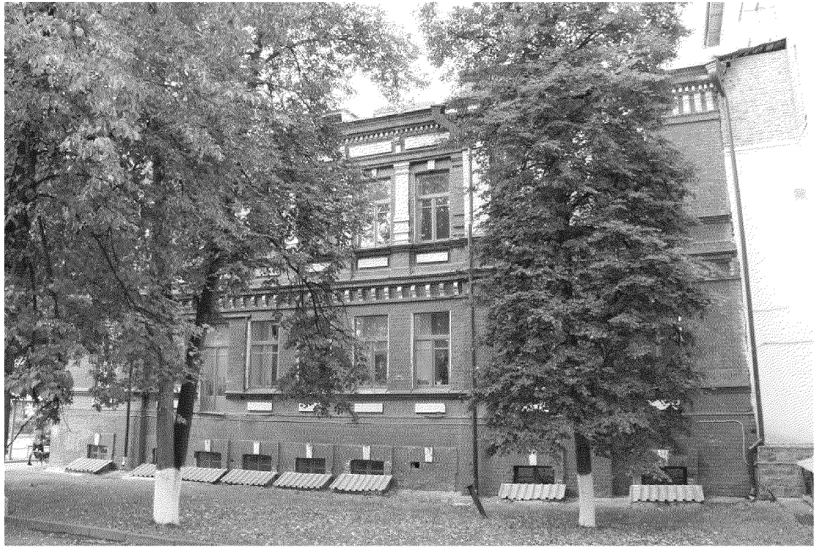
Видовая точка № 3. Восточный фасад. Общий вид здания
