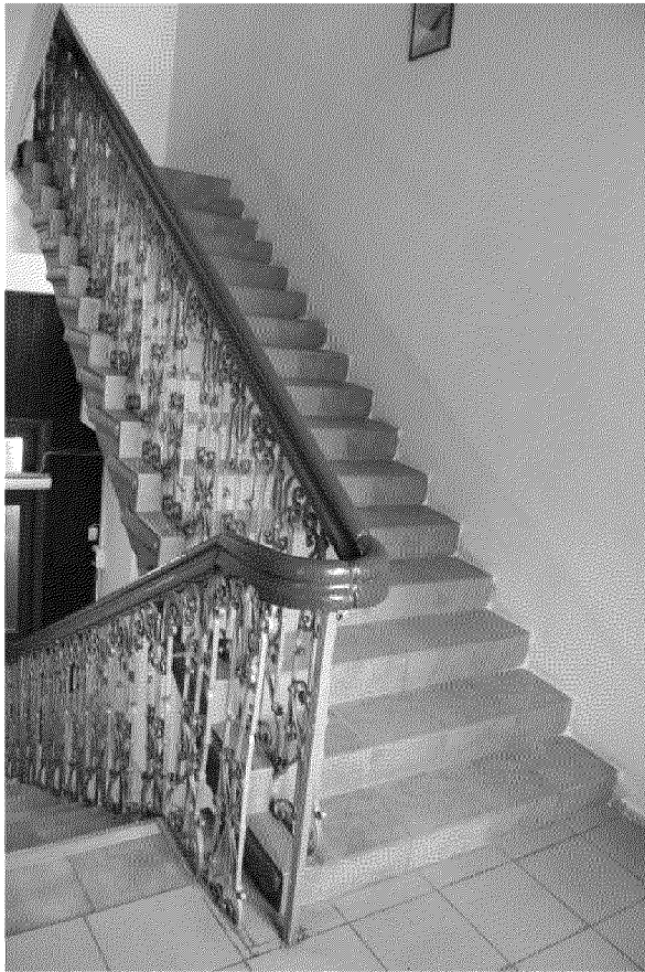
Видовая точка № 14. Парадная лестница с металлическим кованым ограждением
