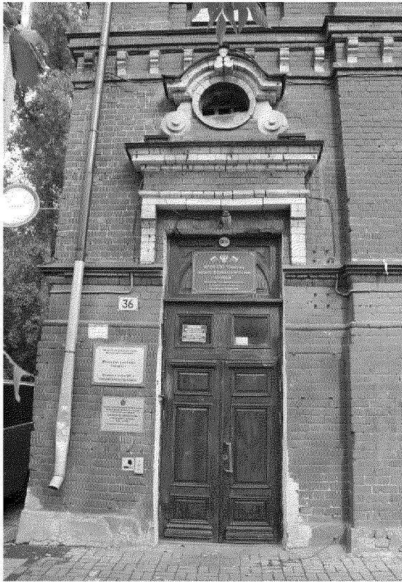
Видовая точка № 10. Фрагмент южного фасада. Декор парадного входа
