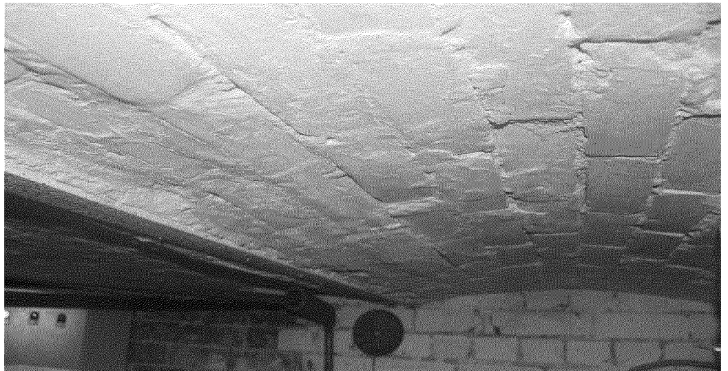
Видовая точка № 29. Кирпичные своды помещения подвала (тепловой узел)
