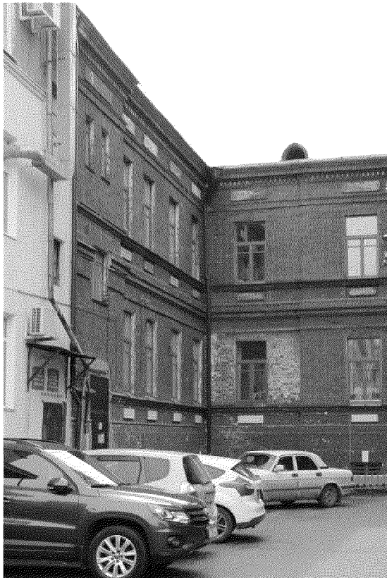
Видовая точка № 6. Общий вид здания с территории двора
