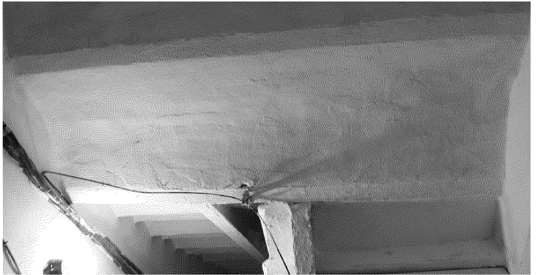
Видовая точка № 28. Кирпичные своды лестничной площадки (подвал)
