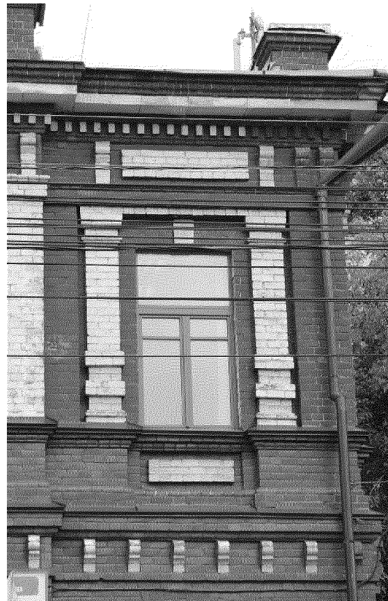
Видовая точка № 13. Фрагмент южного фасада. Декор окна 2-го этажа
