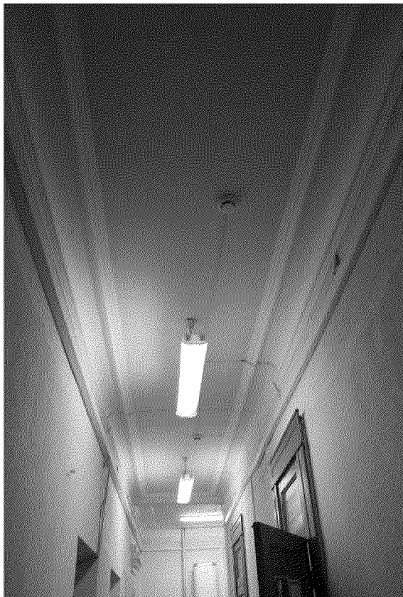
Видовая точка № 24. Профилированные штукатурные тяги в отделке потолка коридора 1-го этажа
