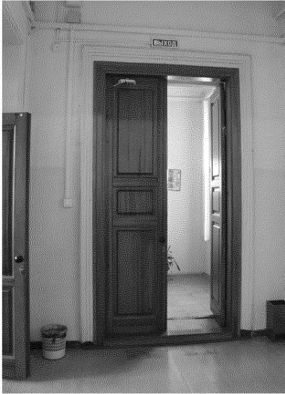
Видовая точка № 18. Профилированный деревянный наличник дверного проема (2 этаж)
