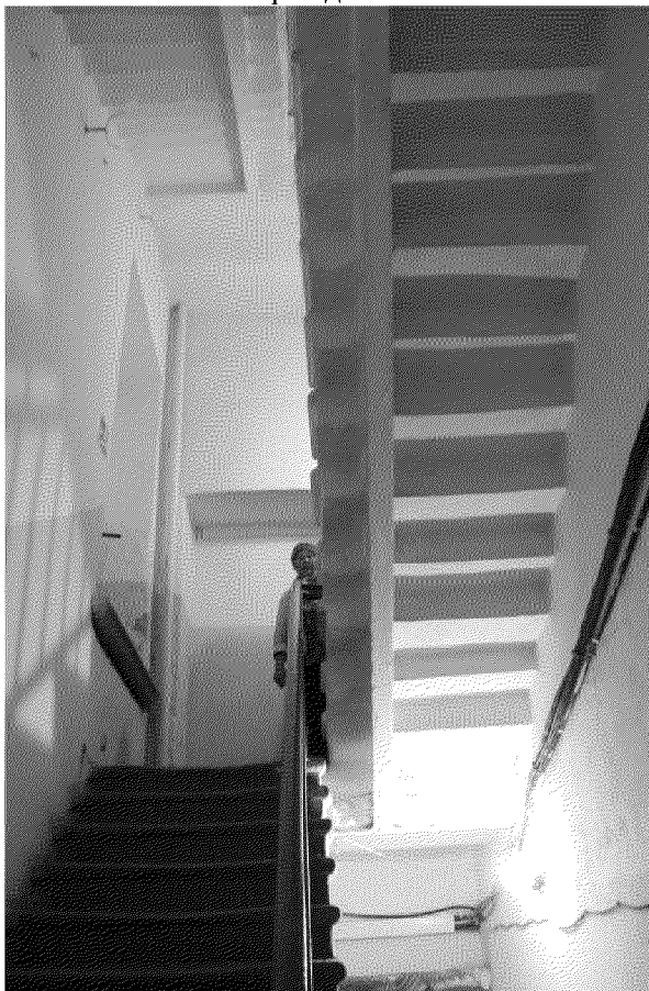
Видовая точка № 16. Служебная лестница (песчаник)
