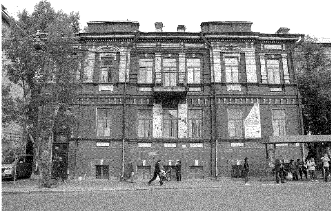
Видовая точка № 2. Главный (южный) фасад. Общий вид здания с пр. Кирова
