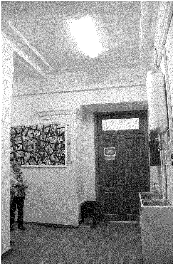
Видовая точка № 22. Профилированные штукатурные тяги в помещении 1-го этажа. Печь
