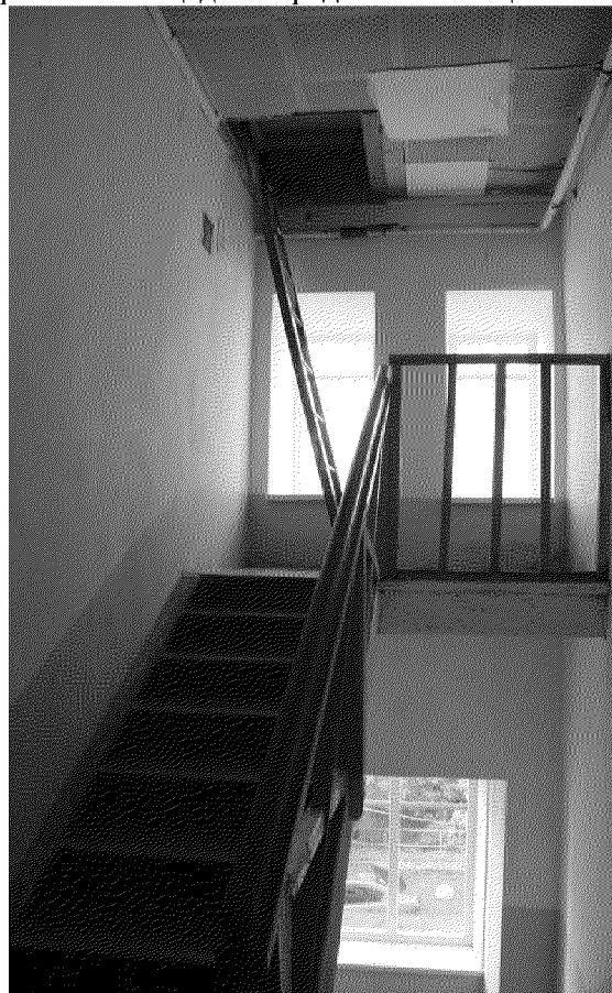
Видовая точка № 17. Деревянный лестничный марш служебной лестницы (подъем на чердак)
