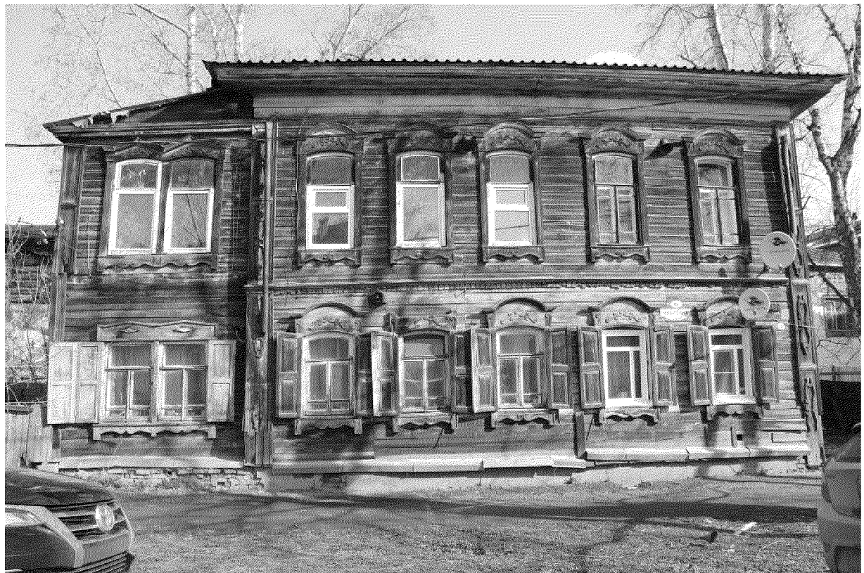
Видовая точка № 4. Главный (южный) фасад здания.
