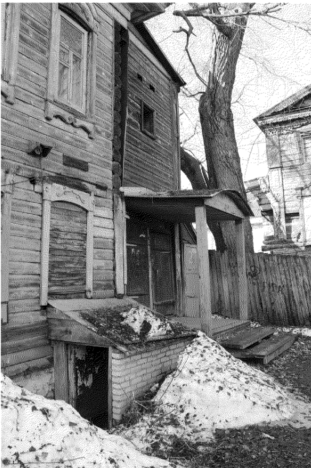
Видовая точка № 6 Фрагмент северного фасада: дворový вход и вход в подвал.
