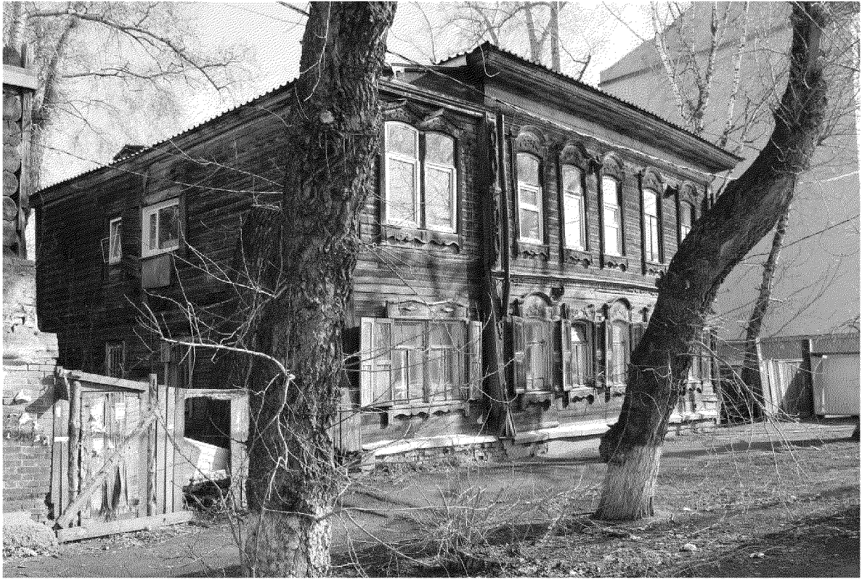
Видовая точка № 3. Общий вид здания с ул. Никитина.
