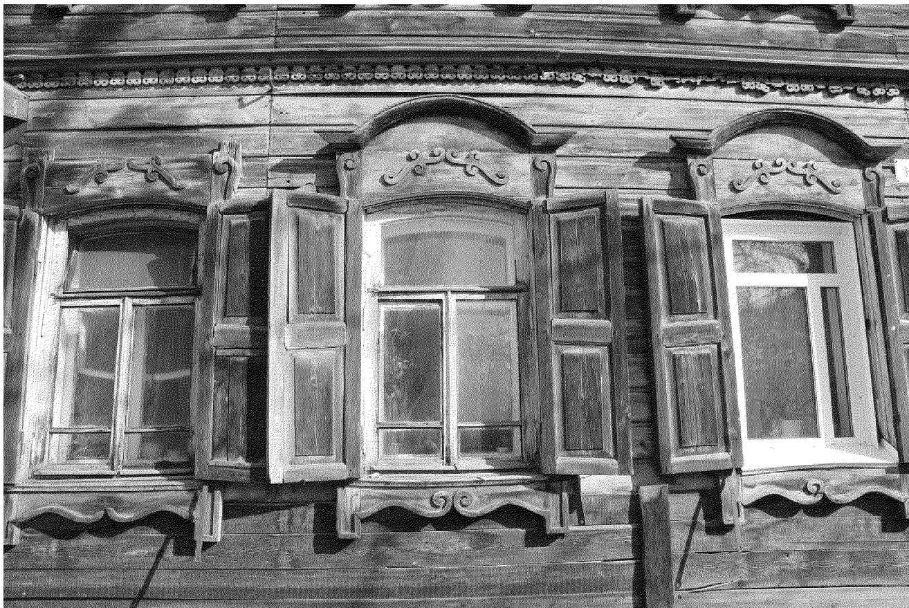
Видовая точка № 8. Фрагмент главного фасада, окна первого этажа со ставнями.
