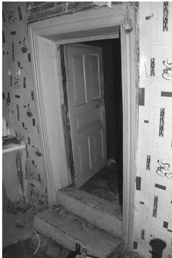
Видовая точка № 16. Дверной проем входа в помещение подклета (фото: Яблонской М.А., 19.10.2016)
