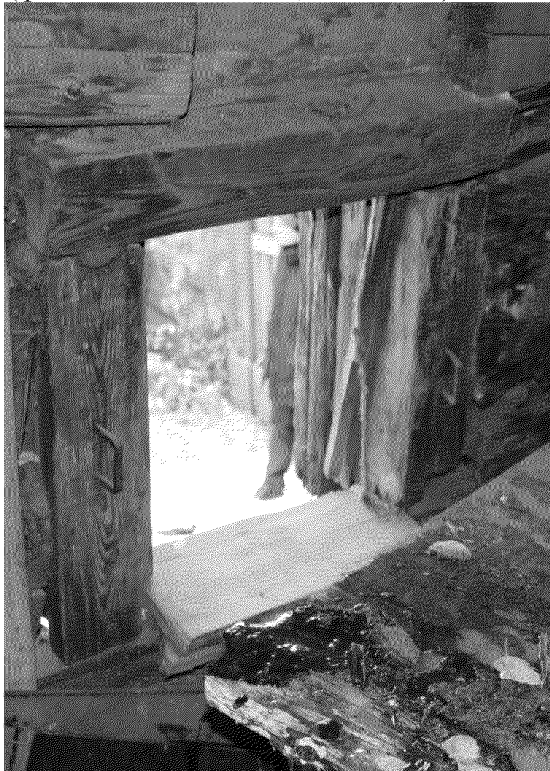
Видовая точка № 21. Оконный проем пристройки (фото: Яблонской М.А., 19.10.2016)
