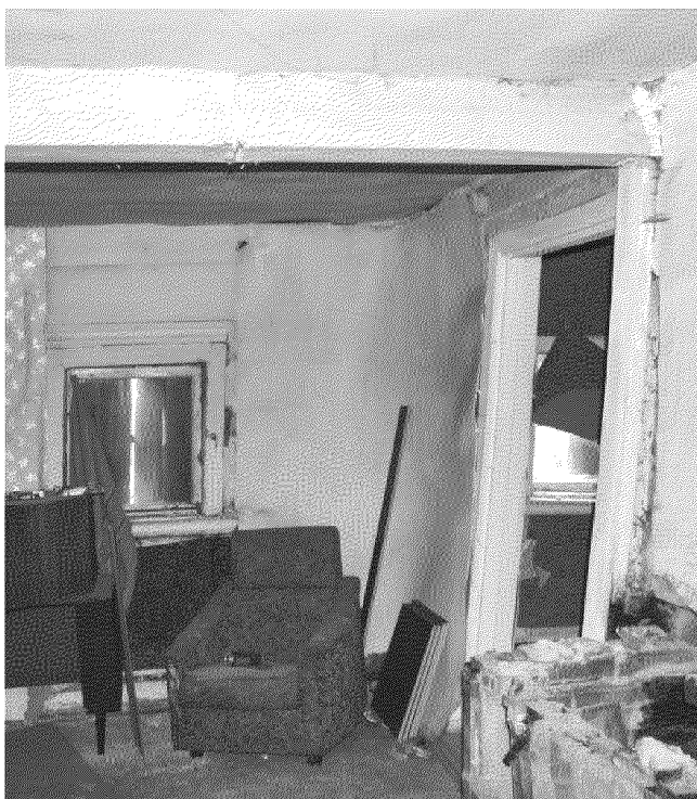
Видовая точка № 17. Общий вид помещения подклета (фото: Яблонской М.А., 19.10.2016)
