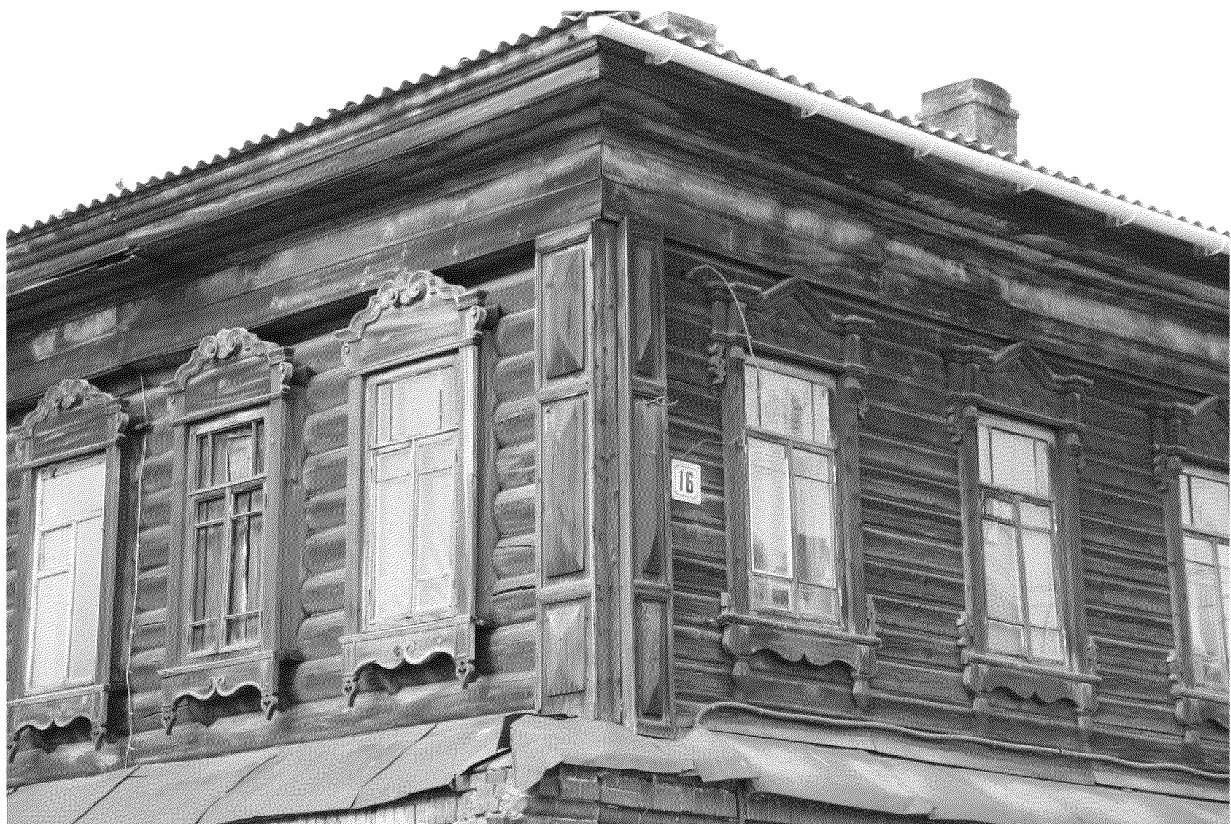
Видовая точка № 6. Фрагмент юго-восточного угла здания (2 этаж) (дата съемки: 06.11.2019 г.)
