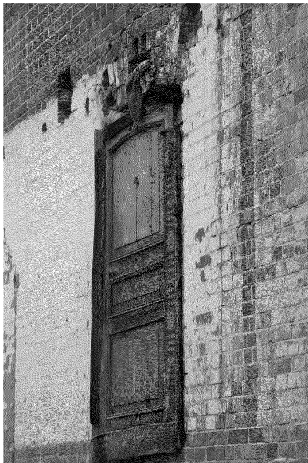
Видовая точка № 10. Дверь торцевого (южного) фасада (Яблонская М.А., 06.11.2019 г.)
