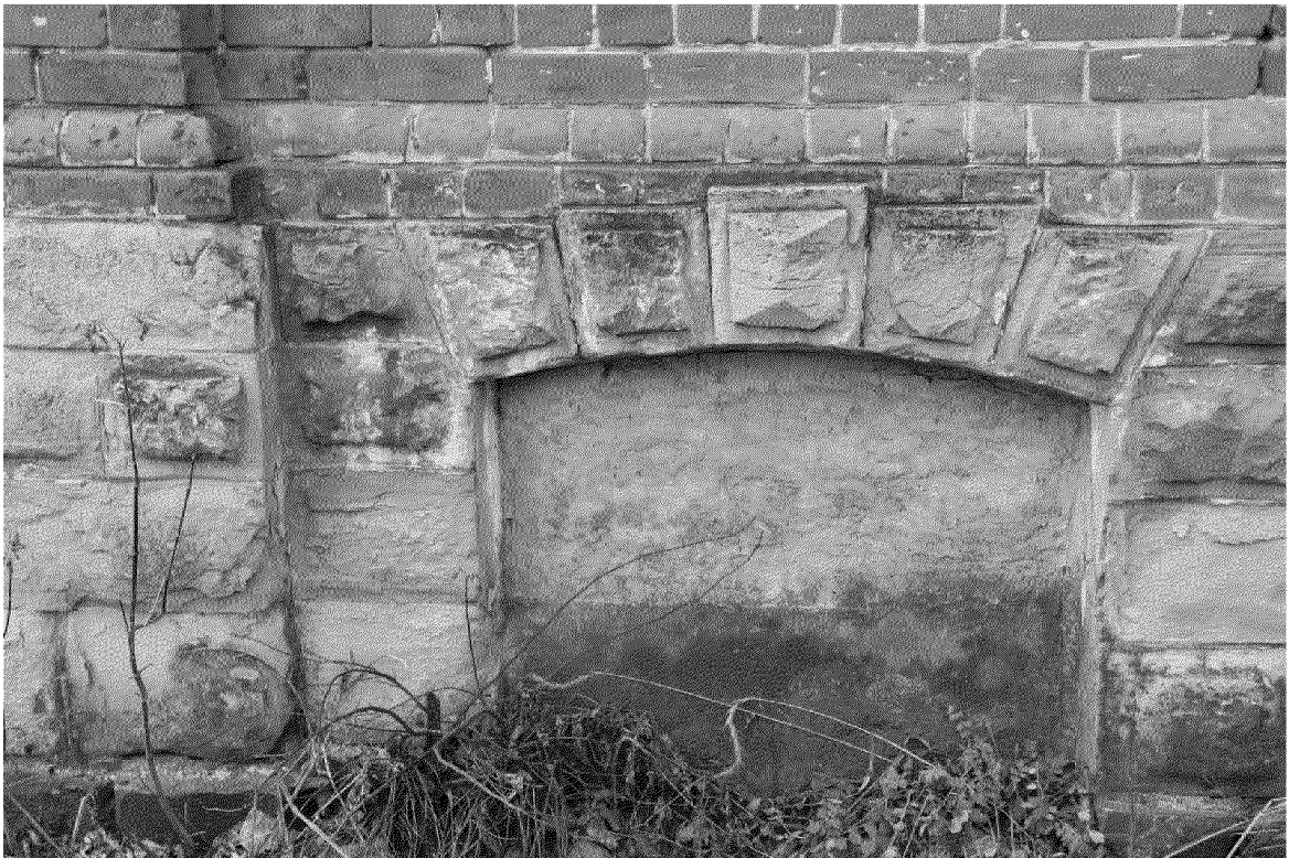
Видовая точка № 8. Фрагмент главного фасада. Плиты песчаника в облицовке цоколя и оконных проемов подвального этажа (автор снимка: Яблонская М.А., 2019 г.).
