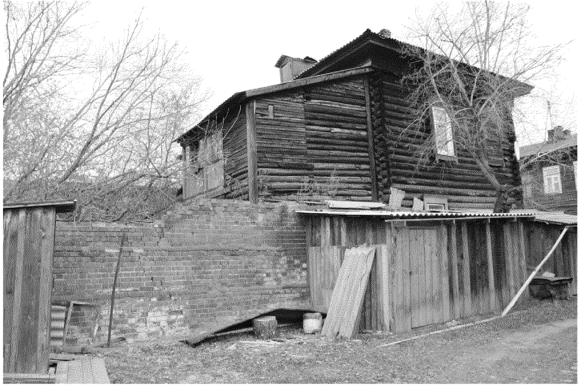
Видовая точка № 8. ул. Бакунина, 16. Фрагмент брандмауэрной стены (автор снимка: Яблонская М.А., дата съемки: 2019 г.)
