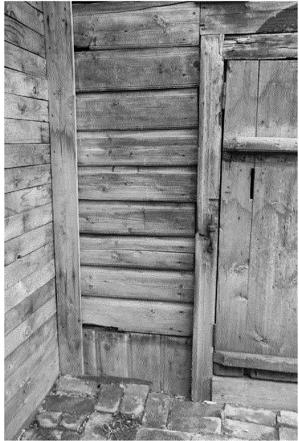
Видовая точка № 17. Фрагмент обшивки северного фасада пристройки из профильных досок
