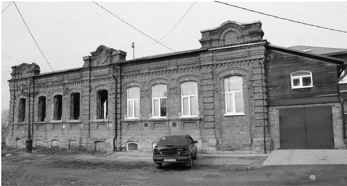
Видовая точка № 4. Главный фасад здания по ул. Бакунина, 14 (08.04.2020 г.)
