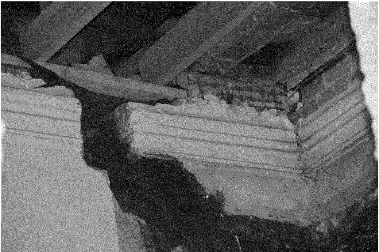
Видовая точка № 16. Фрагмент декора интерьера (профильные потолочно-стеновые штукатурные тяги) (Яблонская М.А., 06.11.2019 г.)
