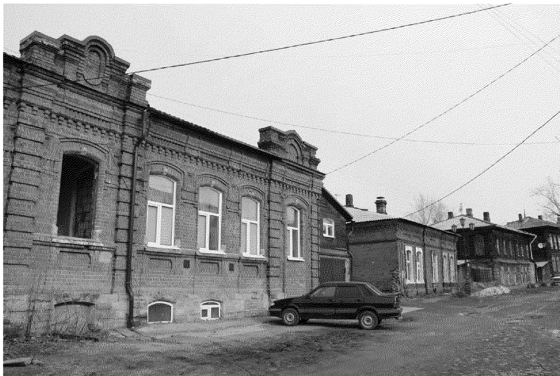
Видовая точка № 1. Общий вид зданий усадьбы по ул. Бакунина (08.04.2020 г.)
