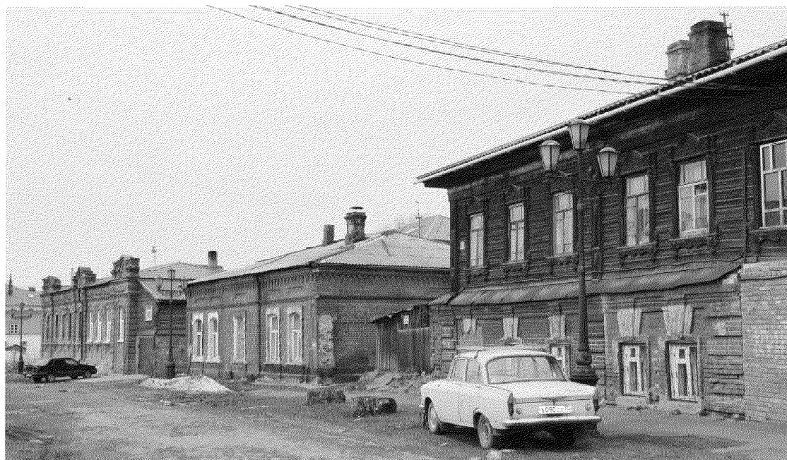
Видовая точка № 2. Общий вид зданий усадьбы по ул. Бакунина (08.04.2020 г.)
