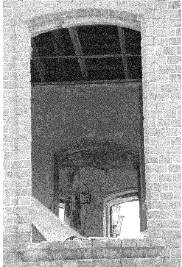
Видовая точка № 15. Фрагмент декора интерьера (профильное штукатурное обрамление проемов) (Яблонская М.А., 06.11.2019 г.)
