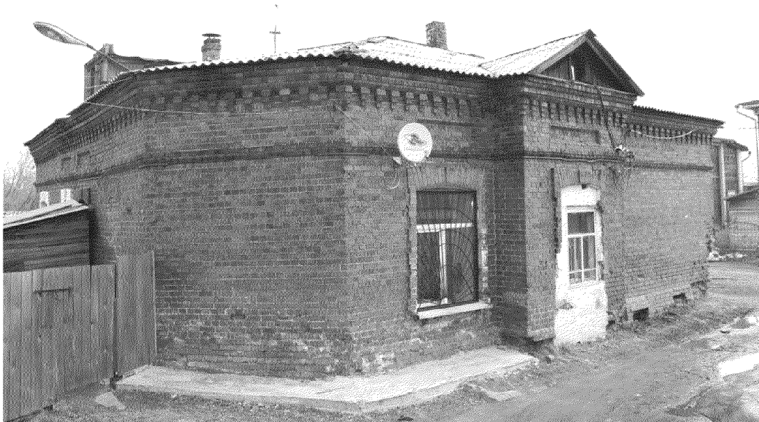
Видовая точка № 6. Вид здания с юго-западной стороны
