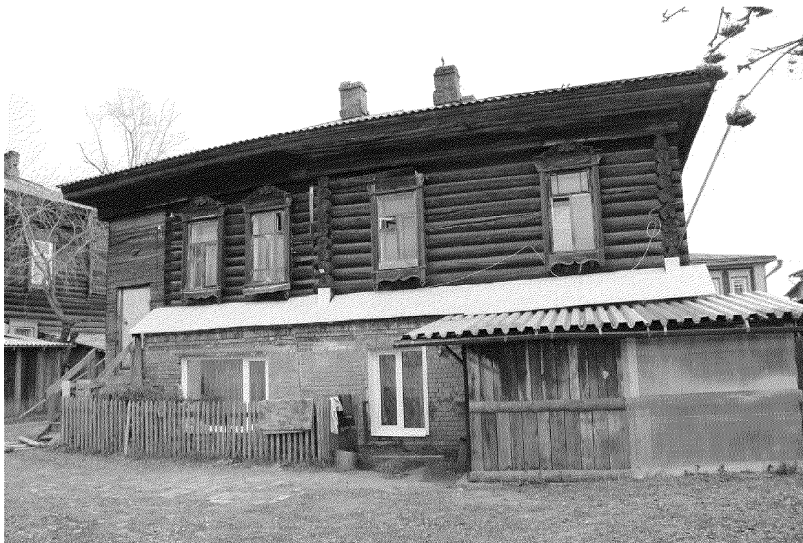
Видовая точка № 10. Западный фасад здания, вид с территории двора (дата съемки: 06.11.2019 г.)
