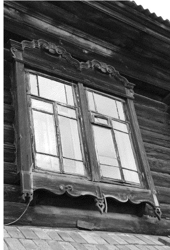
Видовая точка № 15. Сдвоенное окно 2-го этажа южного фасада (дата съемки: 06.11.2019 г.)
