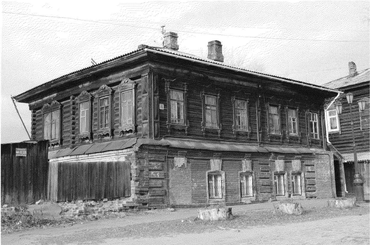
Видовая точка № 5. Общий вид здания с юго-восточной стороны (дата съемки: 06.11.2019 г.)
