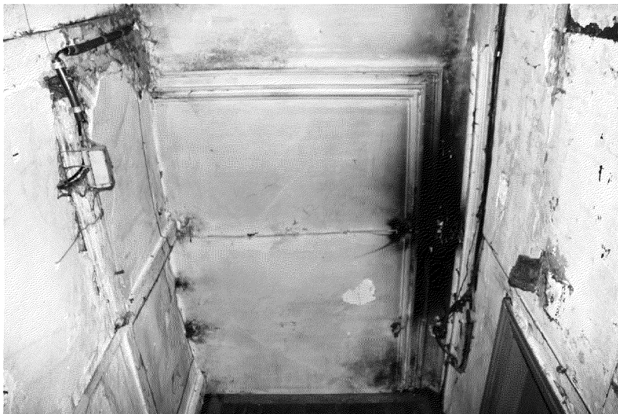
Видовая точка № 12. Фрагмент декора интерьера коридора (профильные потолочно-стеновые штукатурные тяги) (Меньшикова Н.М., 07.06.2018 г.)
