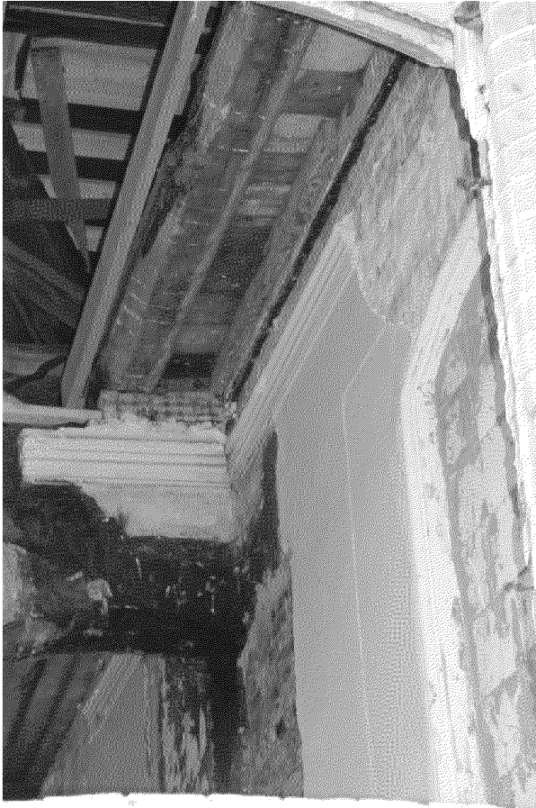
Видовая точка № 14. Фрагмент декора интерьера (профильное штукатурное обрамление проемов) (Яблонская М.А., 06.11.2019 г.)
