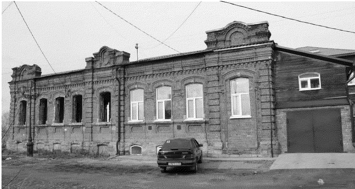
Видовая точка № 2. Главный (восточный) фасад здания (Яблонская М.А., дата съемки: 08.04.2020 г.)
