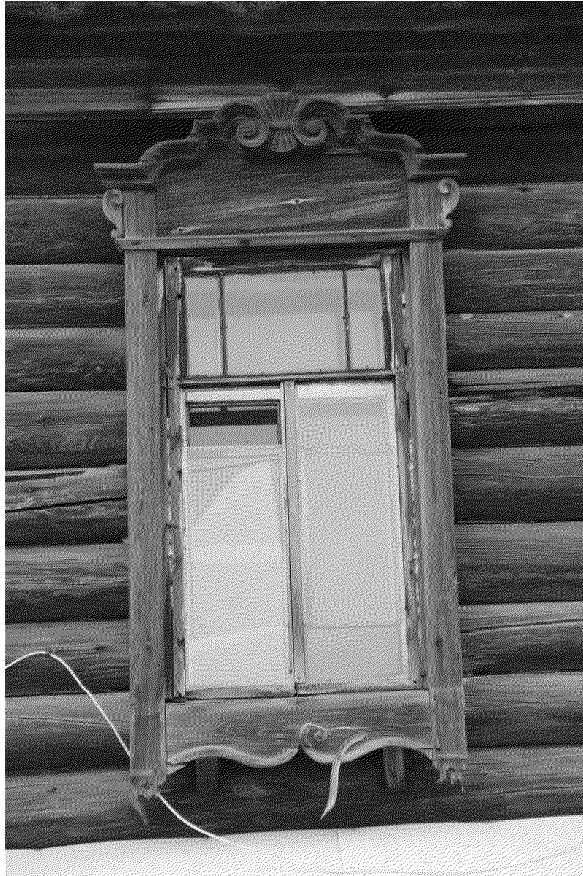
Видовая точка № 12. Окно 2-го этажа дворового (западного) фасада с наличником (06.11.2019 г.)
