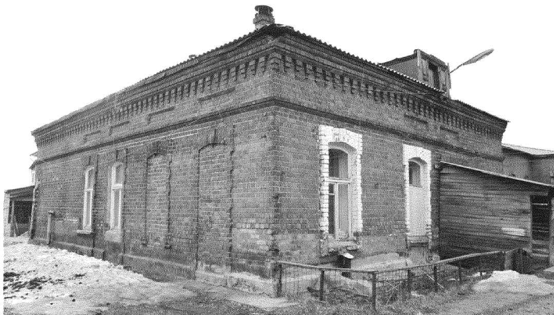
Видовая точка № 7. Вид здания с северо-западной стороны
