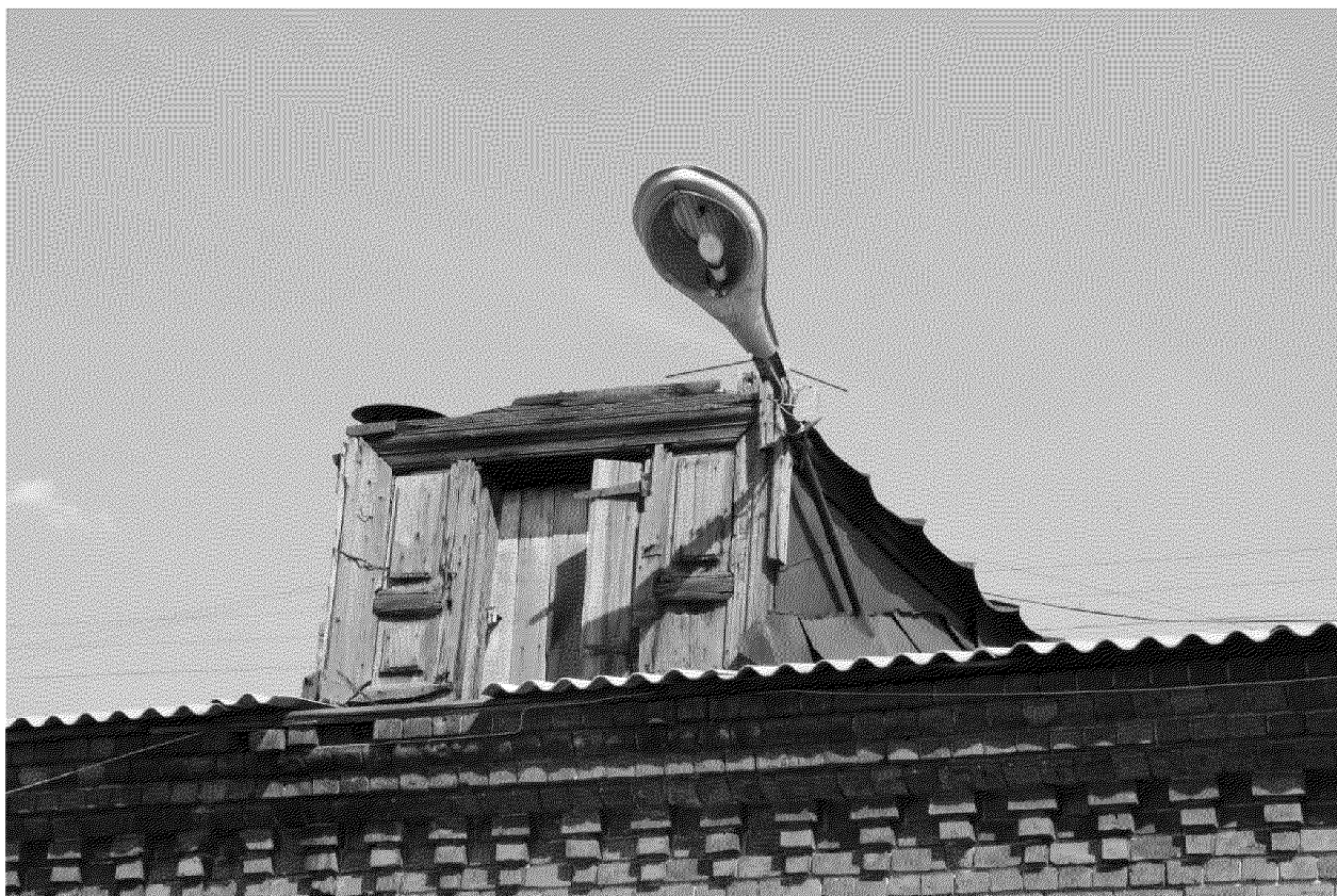
Видовая точка № 9. Слуховое окно дворового (западного) фасада (Меньшикова Н.М., 07.06.2018 г.)
