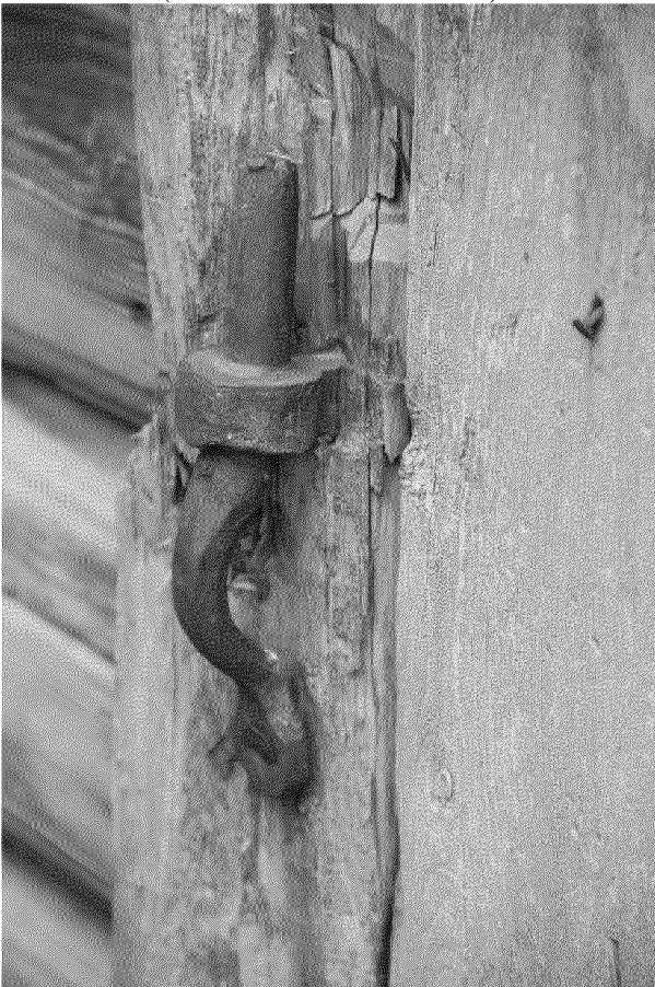
Видовая точка № 18. Кованый подстав дверного проема (пристройка)
