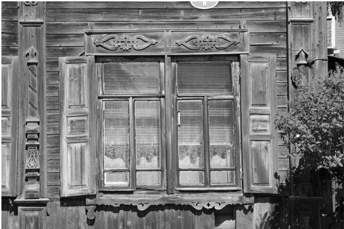
Видовая точка № 10. Парное с импостом окно 1-го этажа главного фасада
