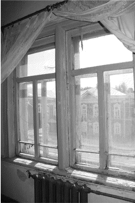
Видовая точка № 19. Сдвоенное окно с импостом в квартире 2-го этажа
