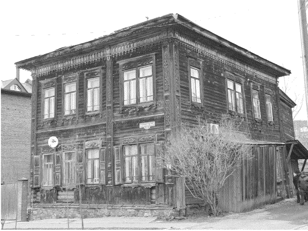
Видовая точка № 3. Общий вид здания с юго-западной стороны (08.04.2020 г.)
