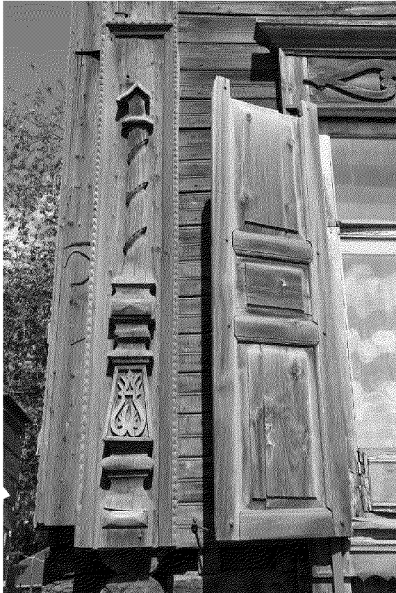
Видовая точка № 5. Фрагмент декора угловой лопатки (в уровне 1-го этажа)
