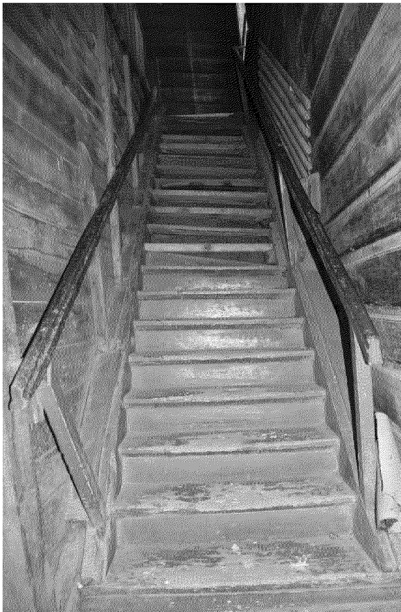
Видовая точка № 13. Деревянная лестница на 2-й этаж (автор снимка: Рыжикова А.Ю.)
