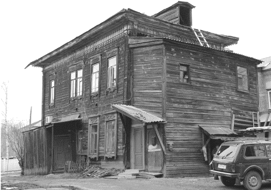
Видовая точка № 4. Общий вид здания с юго-восточной дворовой стороны (08.04.2020 г.).
