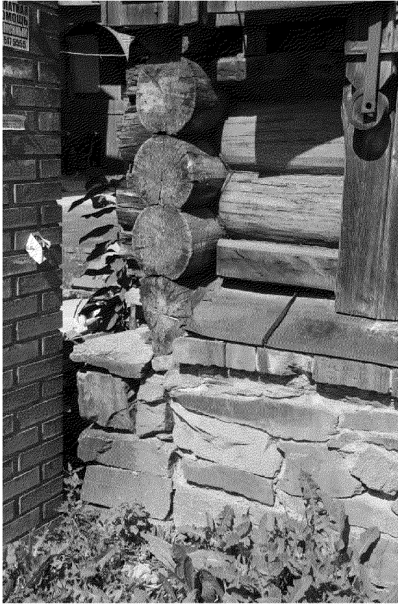
Видовая точка № 11. Фрагмент цоколя здания (бутовый камень)
