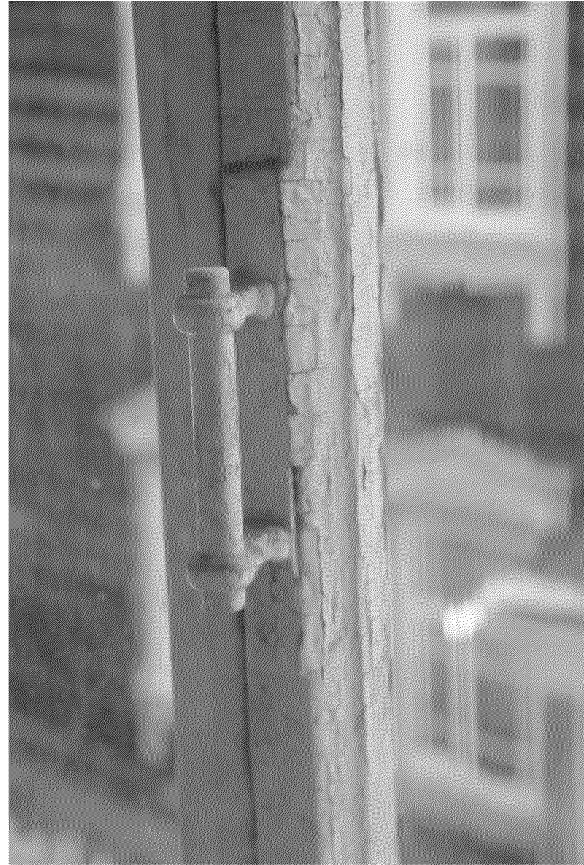
Видовая точка № 20. Оконная ручка наружной рамы (металл)
