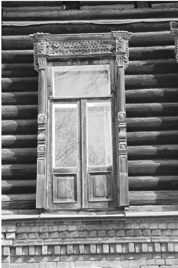
Видовая точка № 5. Балконная дверь западного фасада (дата съемки: 11.04.2019 г.).
