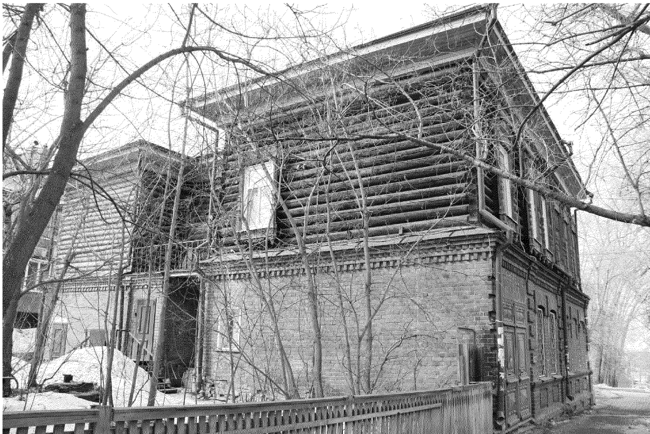
Видовая точка № 3. Дворовый (восточный) фасад (08.04.2020)
