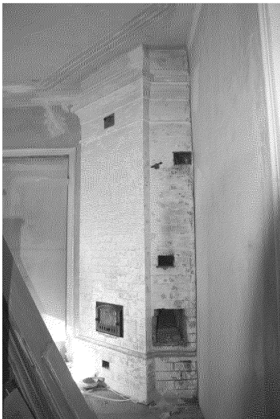
Видовая точка № 12. Угловая печь (автор снимка: Леонтьева Н.М.)
