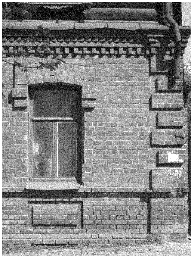
Видовая точка № 7. Декор окна 1-го этажа западного фасада
