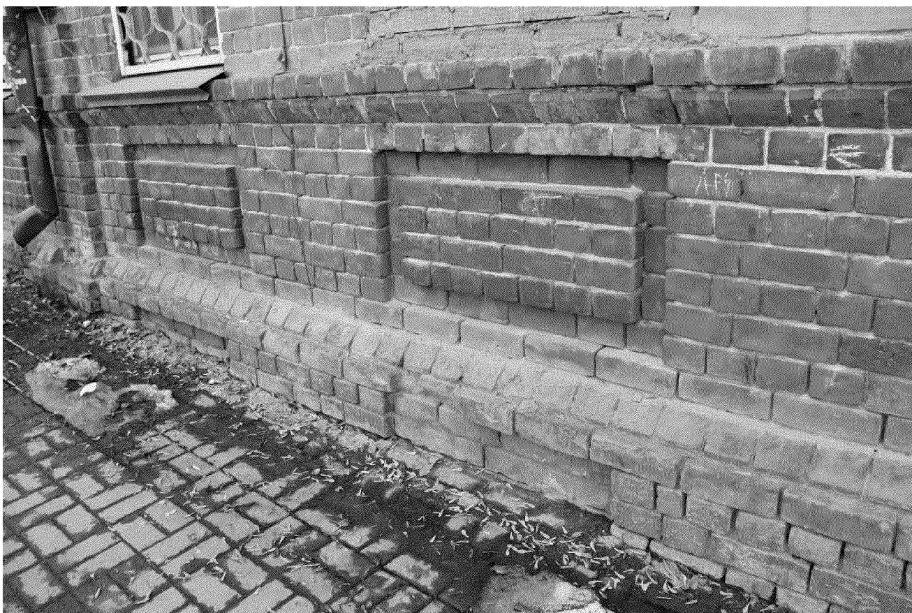
Видовая точка № 4. Декор кирпичной цокольной части здания северного фасада (Яблонская М.А., 08.04.2020)
