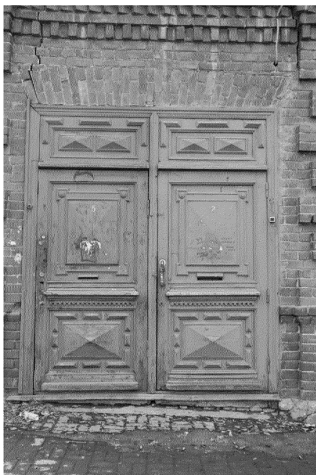
Видовая точка № 10. Двери парадного входа северного фасада (Яблонская М.А., 08.04.2020)
