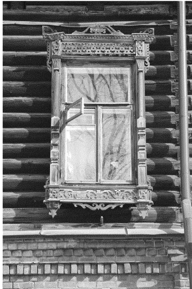
Видовая точка № 6. Фрагмент западного фасада. Окно 2-го этажа (дата съемки: 11.04.2019 г.).
