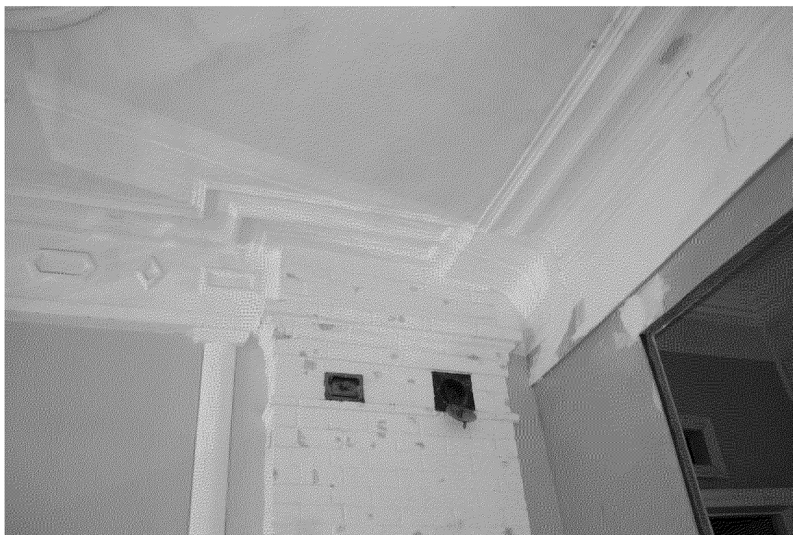
Видовая точка № 14. Фрагмент декора печи и декора потолка – профильные штукатурные потолочно-стенные тяги (автор снимка: Леонтьева Н.М.)
