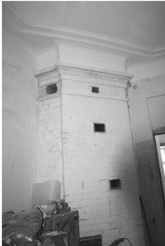
Видовая точка № 13. Угловая печь (автор снимка: Леонтьева Н.М.)
