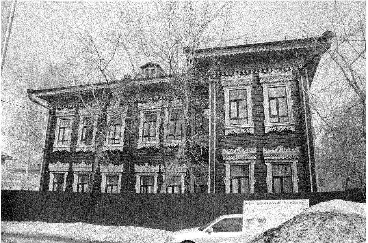
Видовая точка № 5. Южный фасад здания (дата съемки: 08.04.2020 г.)
