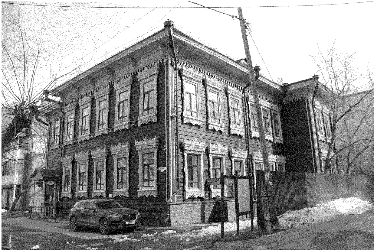
Видовая точка № 3. Общий вид здания с юго-западной стороны (дата съемки: 08.14.2020 г.)
