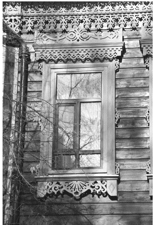
Видовая точка № 7. Окно 2-го этажа ризалита (после ремонта, дата съемки: 12.10.2018 г.)
