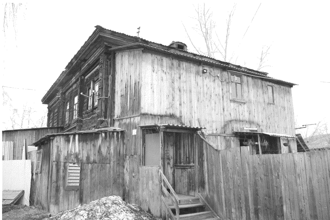
Видовая точка № 14 Общий вид здания с территории двора. Дворовый (восточный) фасад (08.04.2020 г.)
