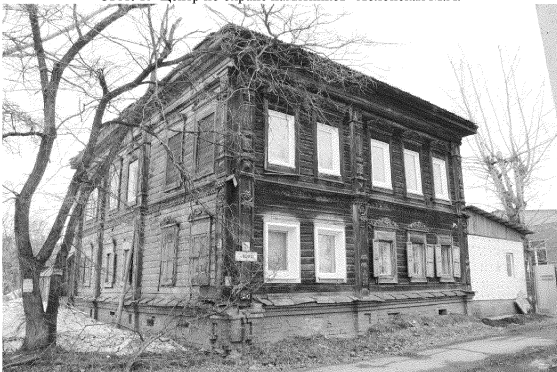
Видовая точка № 1. Общий вид здания с ул. Войкова (08.04.2020 г.)
