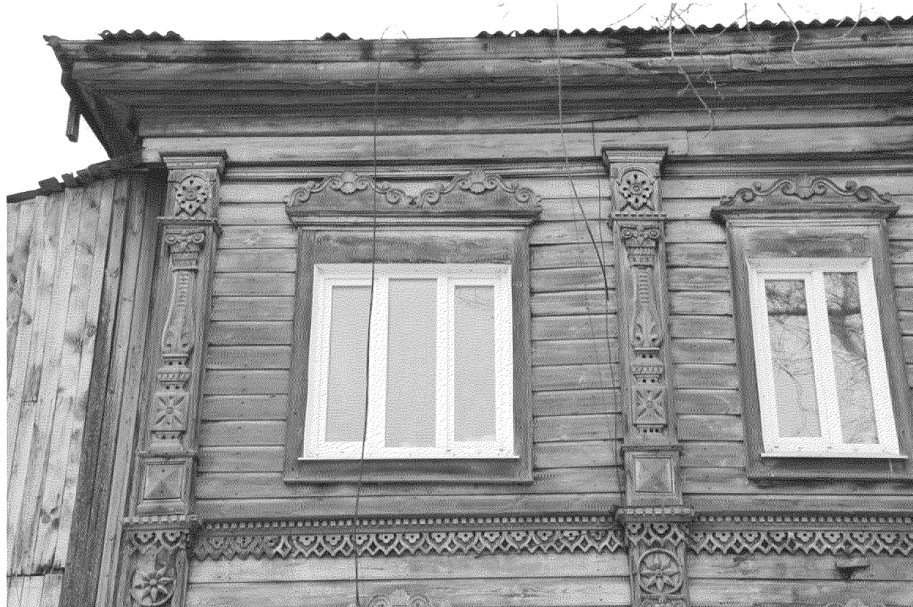
Видовая точка № 13 Фрагмент декора северного фасада. Сдвоенное окно 2-го этажа (08.04.2020 г.)
