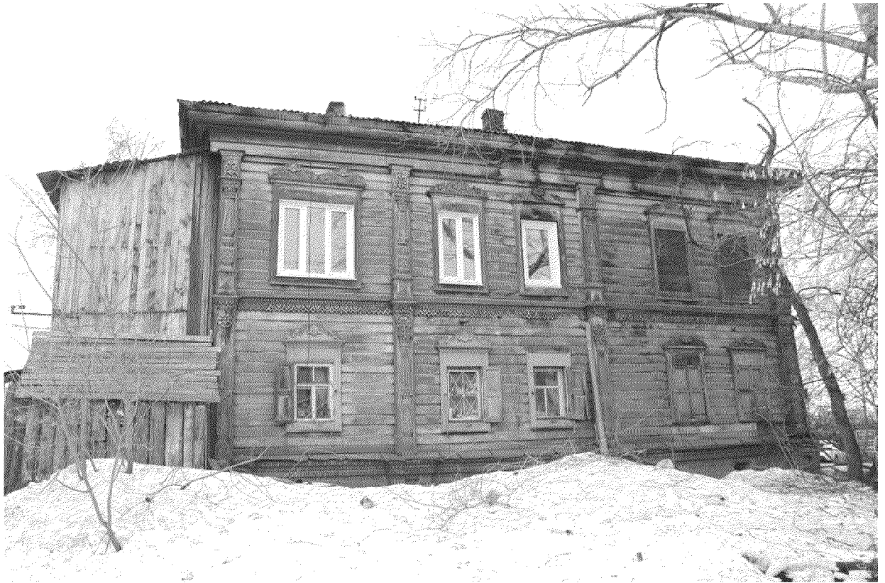
Видовая точка № 9. Северный фасад здания, вид с пер. Заозерного (08.04.2020 г.)
