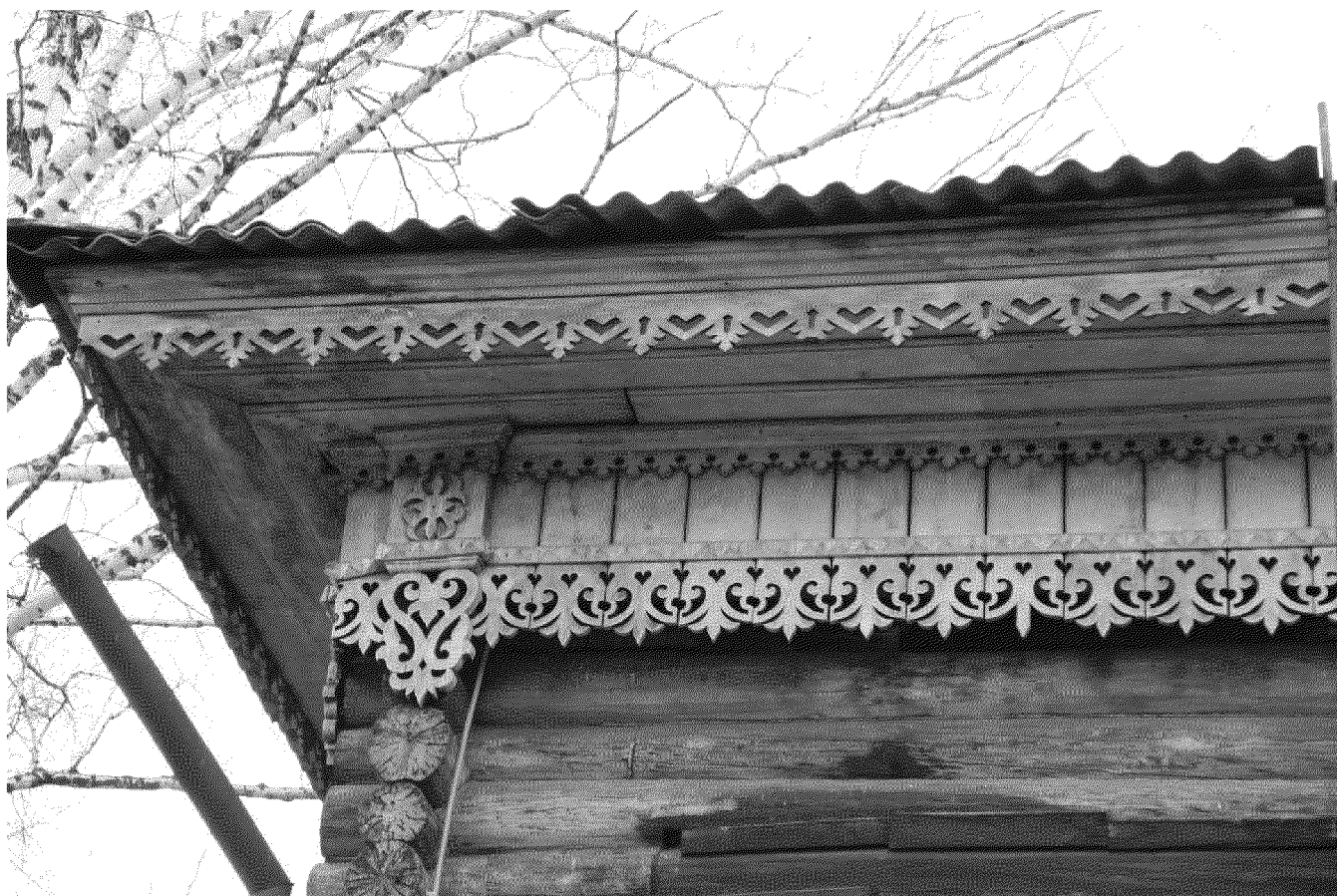
Видовая точка № 6 Фрагмент декора карниза северо-восточного фасада (Яблонская М.А., 08.04.2020 г.)
