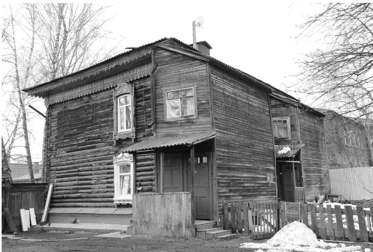
Видовая точка № 9. Боковой (северо-восточный) фасад здания (автор снимка: Яблонская М.А., 08.04.2020 г.)
