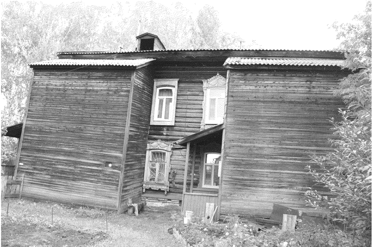
Видовая точка № 10. Дворовый (северо-западный) фасад здания (Рыжикова А.Ю., 18.09.2017 г.)
