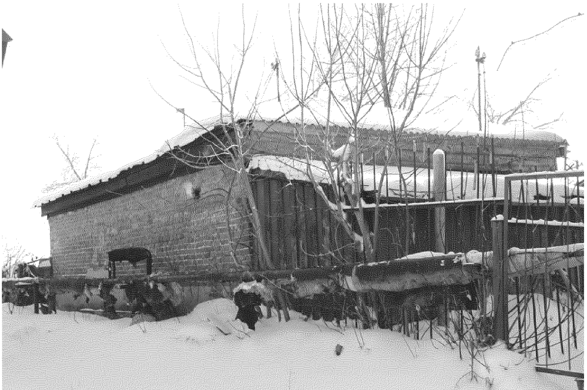
Видовая точка № 3. Общий вид здания со стороны северного фасада (фото Яблонской М.А., 2019 г.)
