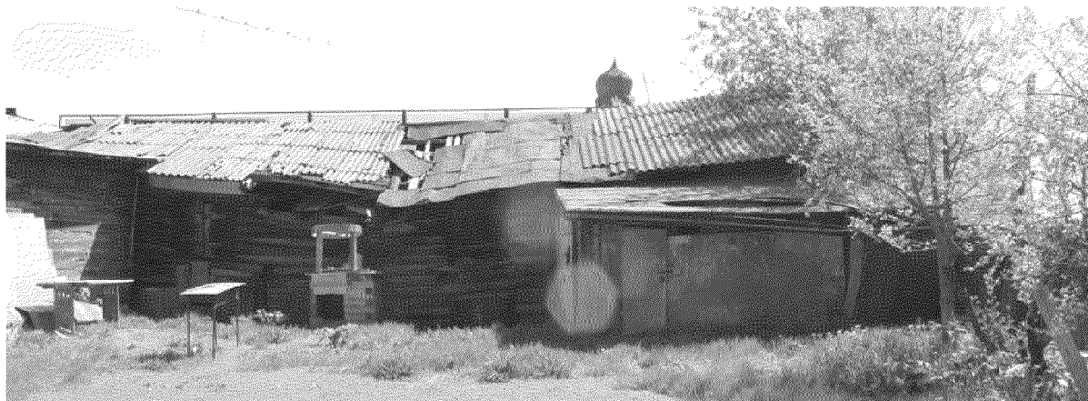
Видовая точка № 5. Фрагмент северного фасада деревянных служб. (Автор снимка: Леонтьева Н.М., дата съемки: 07.06.2018)
