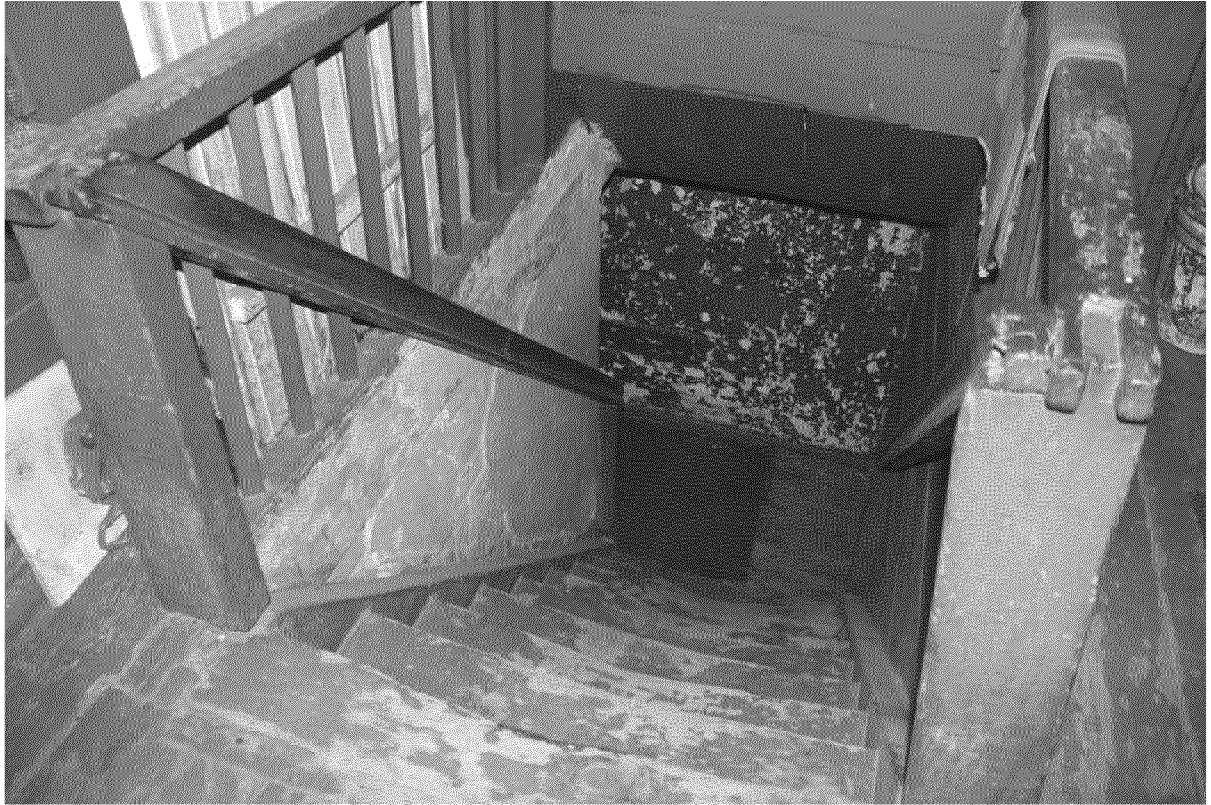
Видовая точка № 16. Лестница пристройки дворового (восточного) фасада
