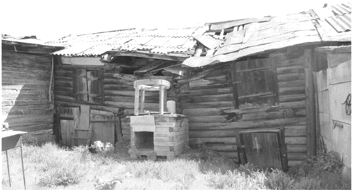
Видовая точка № 9. Фрагмент северного фасада деревянных служб. (Автор снимка: Леонтьева Н.М., дата съемки: 07.06.2018)
