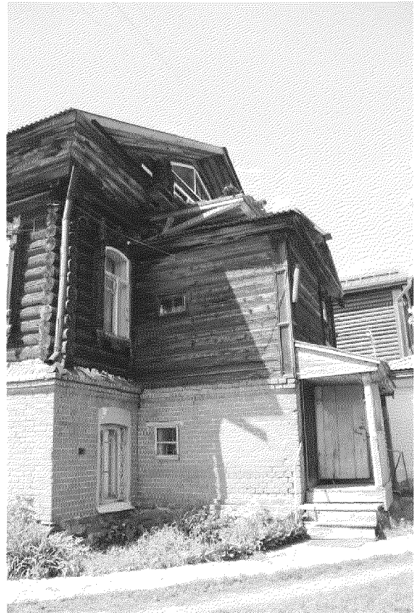
Видовая точка № 10. Пристройка восточного фасада
