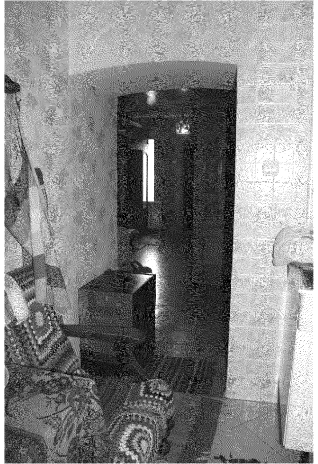
Видовая точка № 23. Лучковый дверной проем в квартире 1-го этажа
