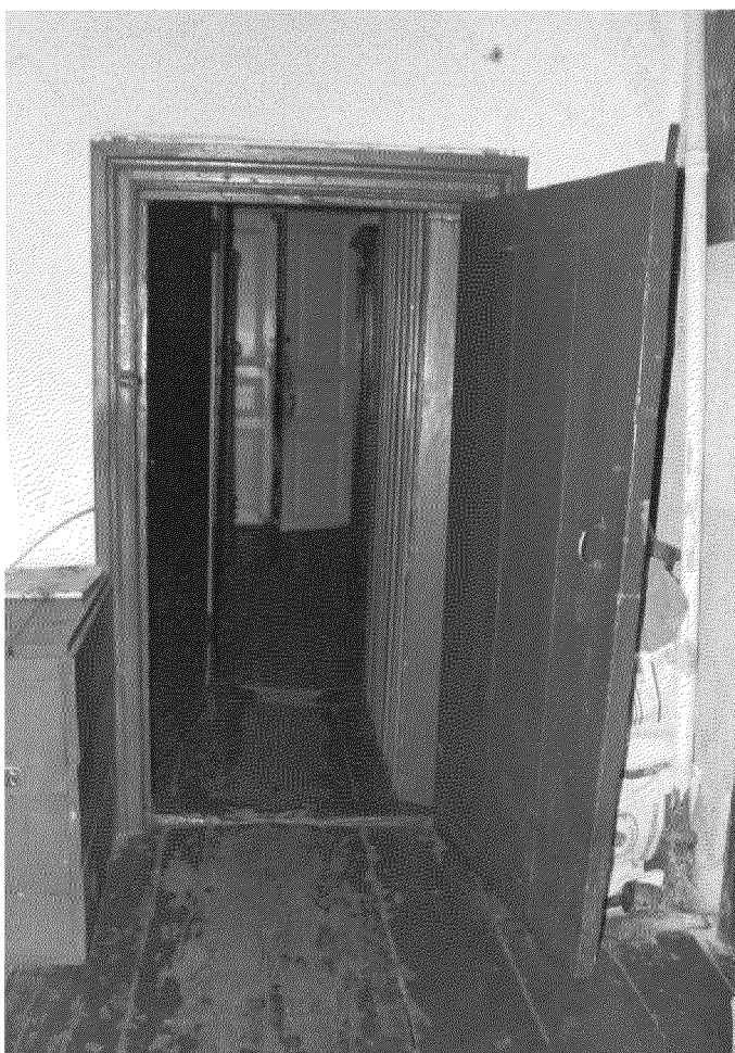
Видовая точка № 20. Внутренняя входная дверь
