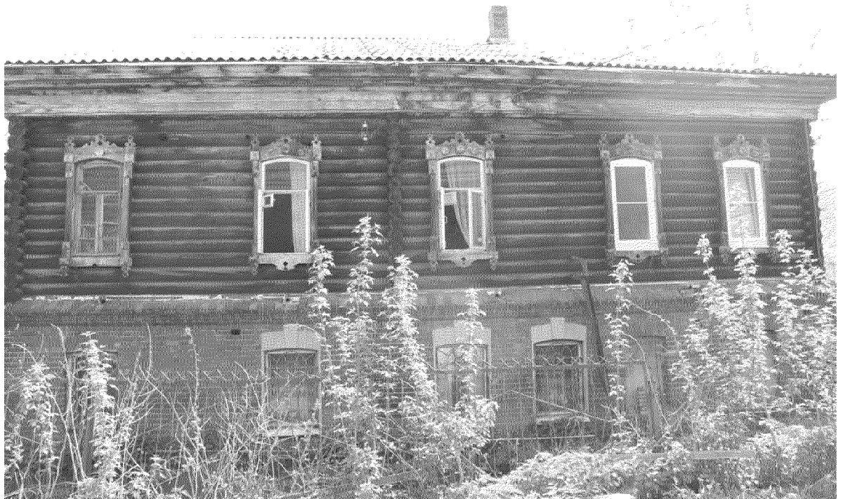
Видовая точка № 7. Северный фасад здания
