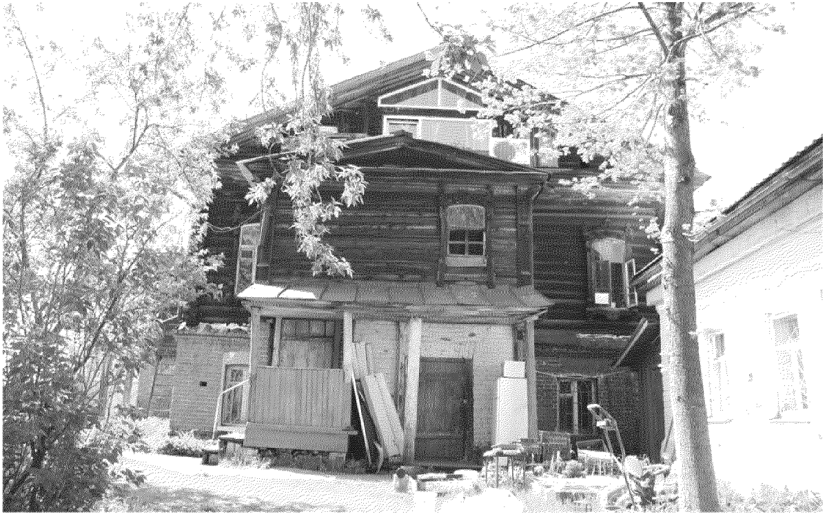
Видовая точка № 6. Восточный фасад здания, вид с территории двора
