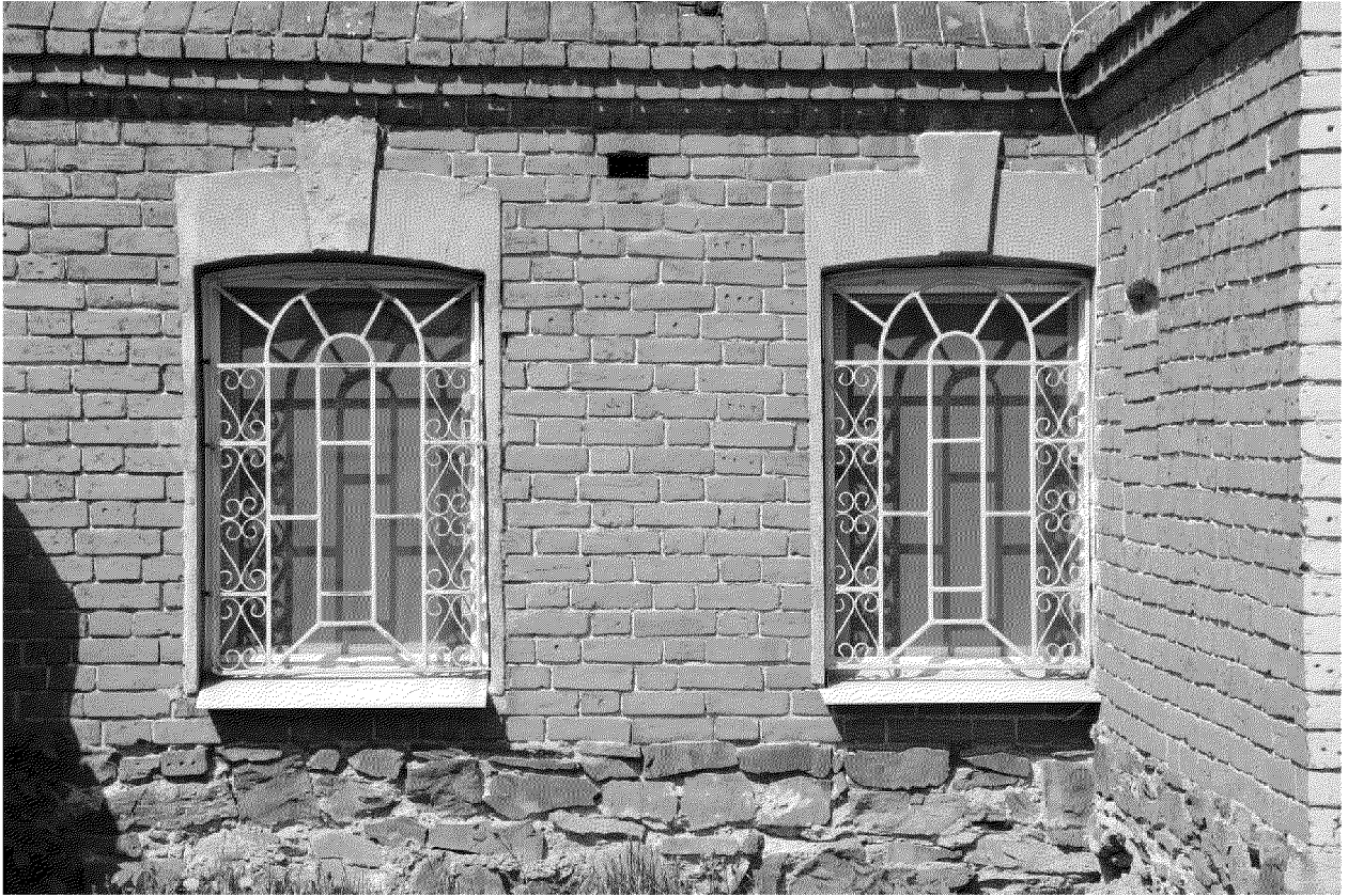
Видовая точка № 13. Оконные проемы 1-го этажа южного фасада. Бутовый камень в цокольной части здания.
