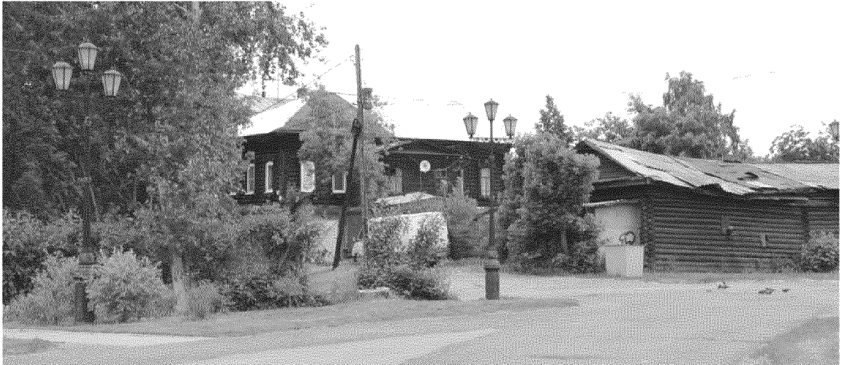
Видовая точка № 4. Общий вид усадьбы с юго-западной стороны ул. Бакунина. (Автор снимка: Монич Г.И., дата съемки: 02.07.2014)
