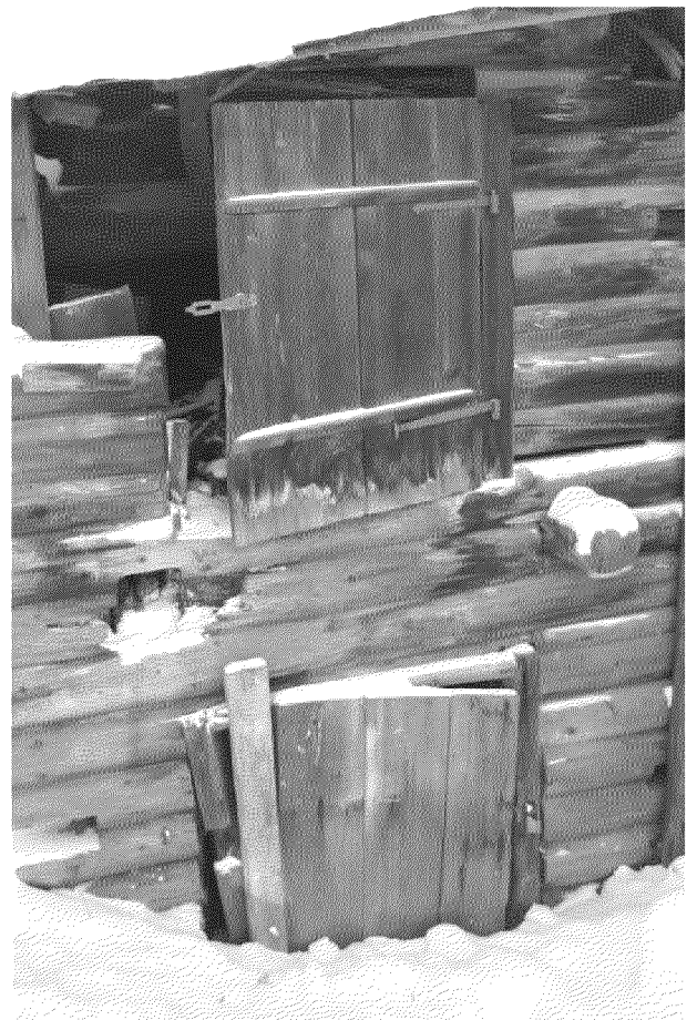
Видовая точка № 11. Дошчатые двери на кованых навесах. Местоположение лестницы на 2-й этаж. (фото: Яблонской М.А., 2019 г.)
