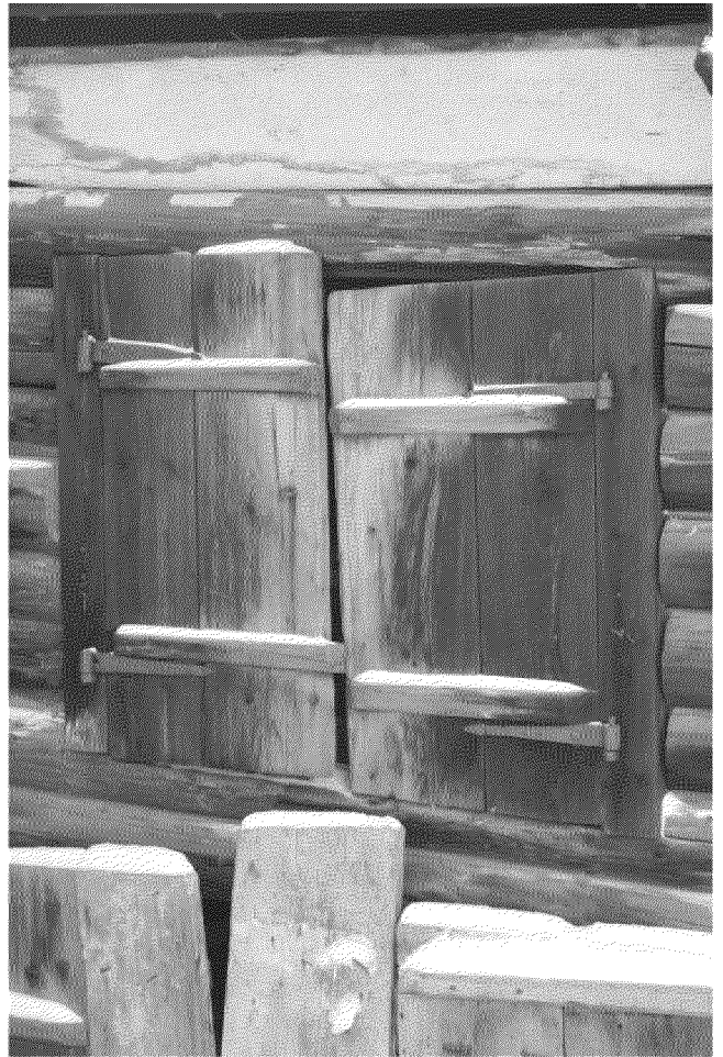
Видовая точка № 13. Дощатые двухстворчатые двери 2-го этажа (фото: Яблонской М.А., 2019 г.)
