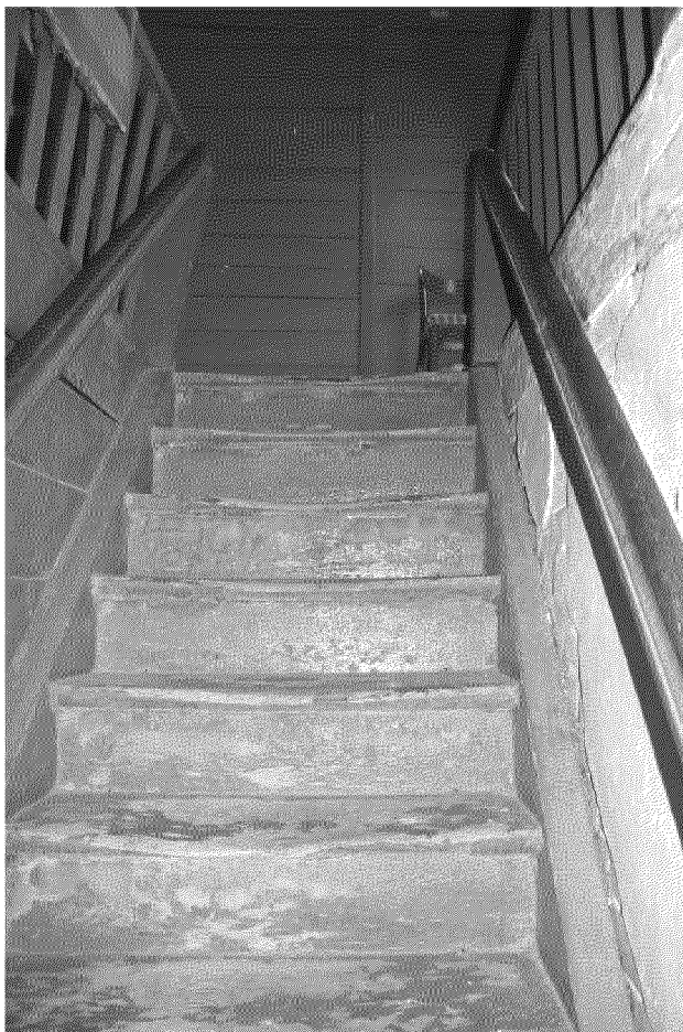
Видовая точка № 17. Лестница пристройки дворового (восточного) фасада
