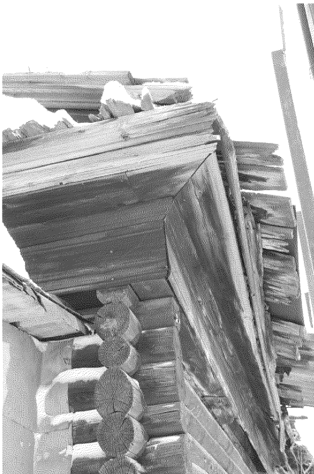
Видовая точка № 7. Фрагмент обшивки карниза (фото: Яблонской М.А., 2019 г.)
