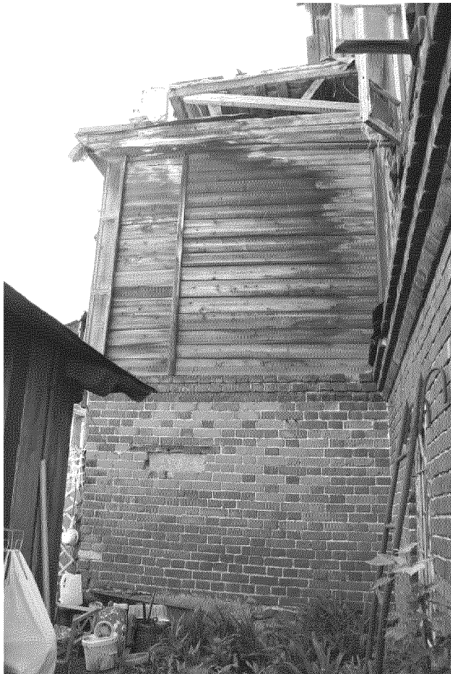
Видовая точка № 11. Северный фасад дворовой пристройки
