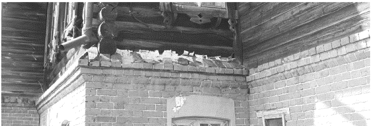
Видовая точка № 8. Фрагмент междуэтажного карниза с гидроизоляцией из слоя бересты
