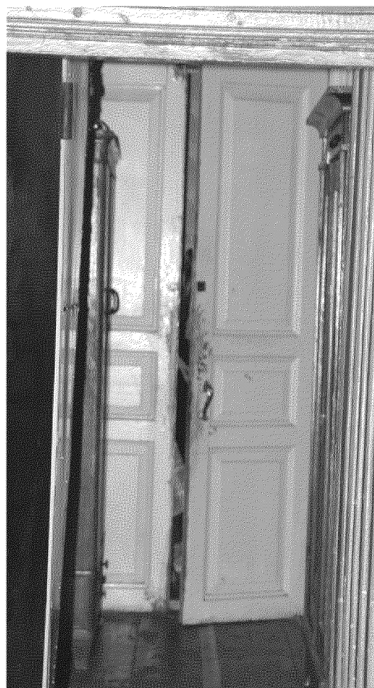
Видовая точка № 21. Внутриквартирная двустворчатая филенчатая дверь
