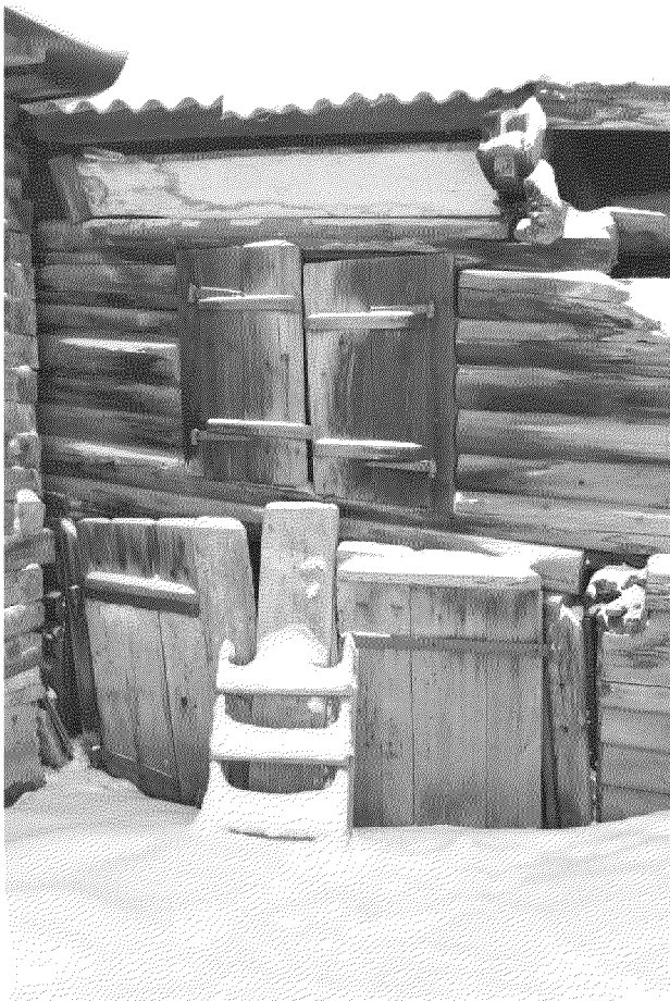
Видовая точка № 10. Дошчатые двери 2-го этажа и ворота 1-го этажа на кованых навесах (фото: Яблонской М.А., 2019 г.)
