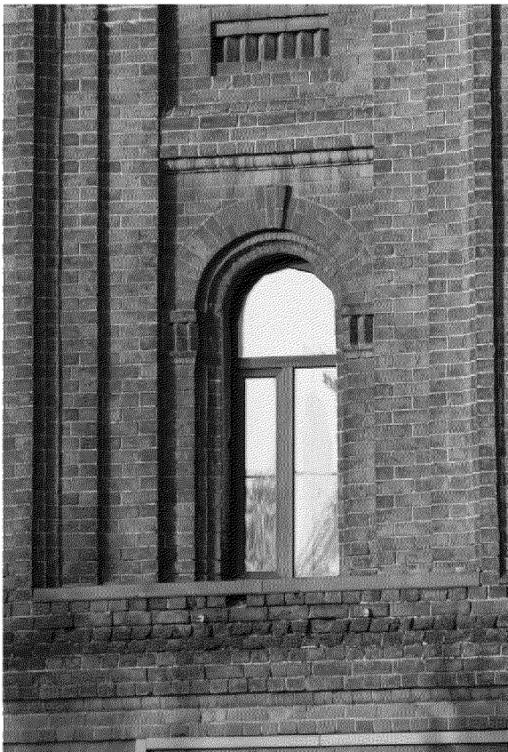
Видовая точка № 8. Арочный оконный проем 2-го этажа и элементы фасадного декора
