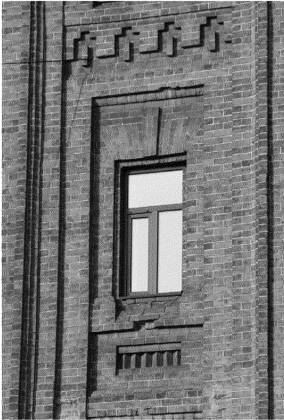
Видовая точка № 6. Оконный проем 4-го этажа и элементы фасадного декора
