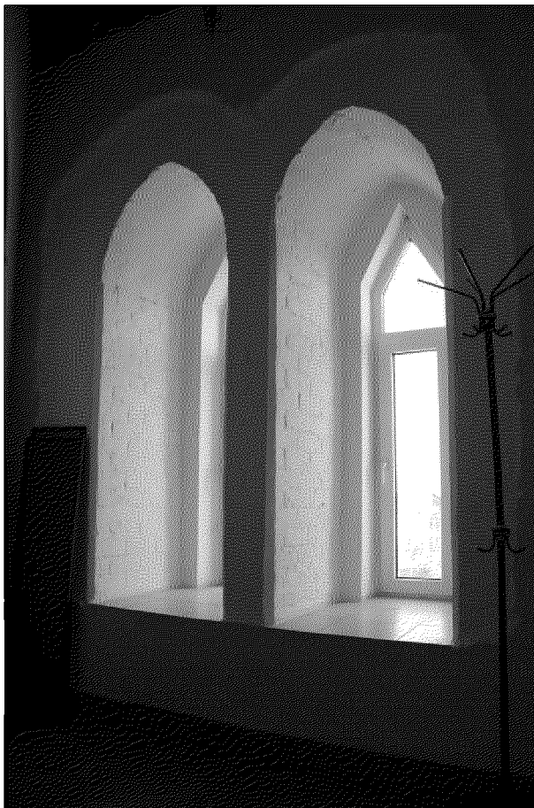
Видовая точка № 15. Оконные проемы 5-го этажа, откосы обработаны срезкой граней
