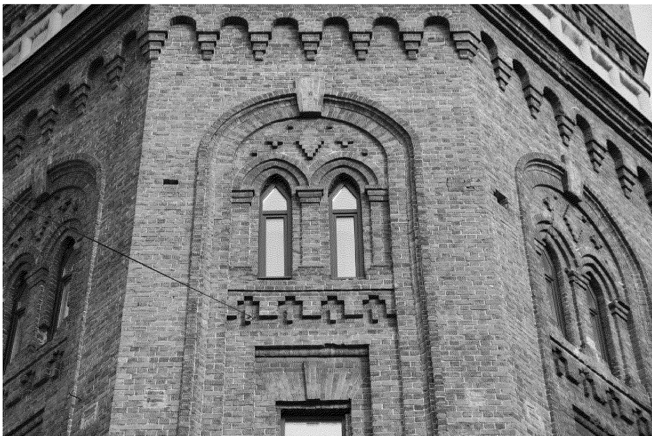
Видовая точка № 5. Фрагмент западного фасада башни в уровне 5-го этажа.
