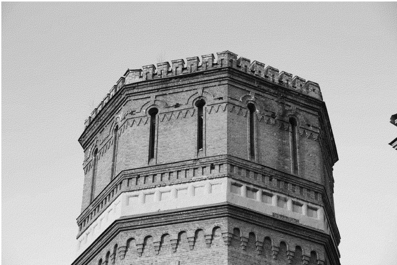
Видовая точка № 4. Венчающая часть водонапорной башни
