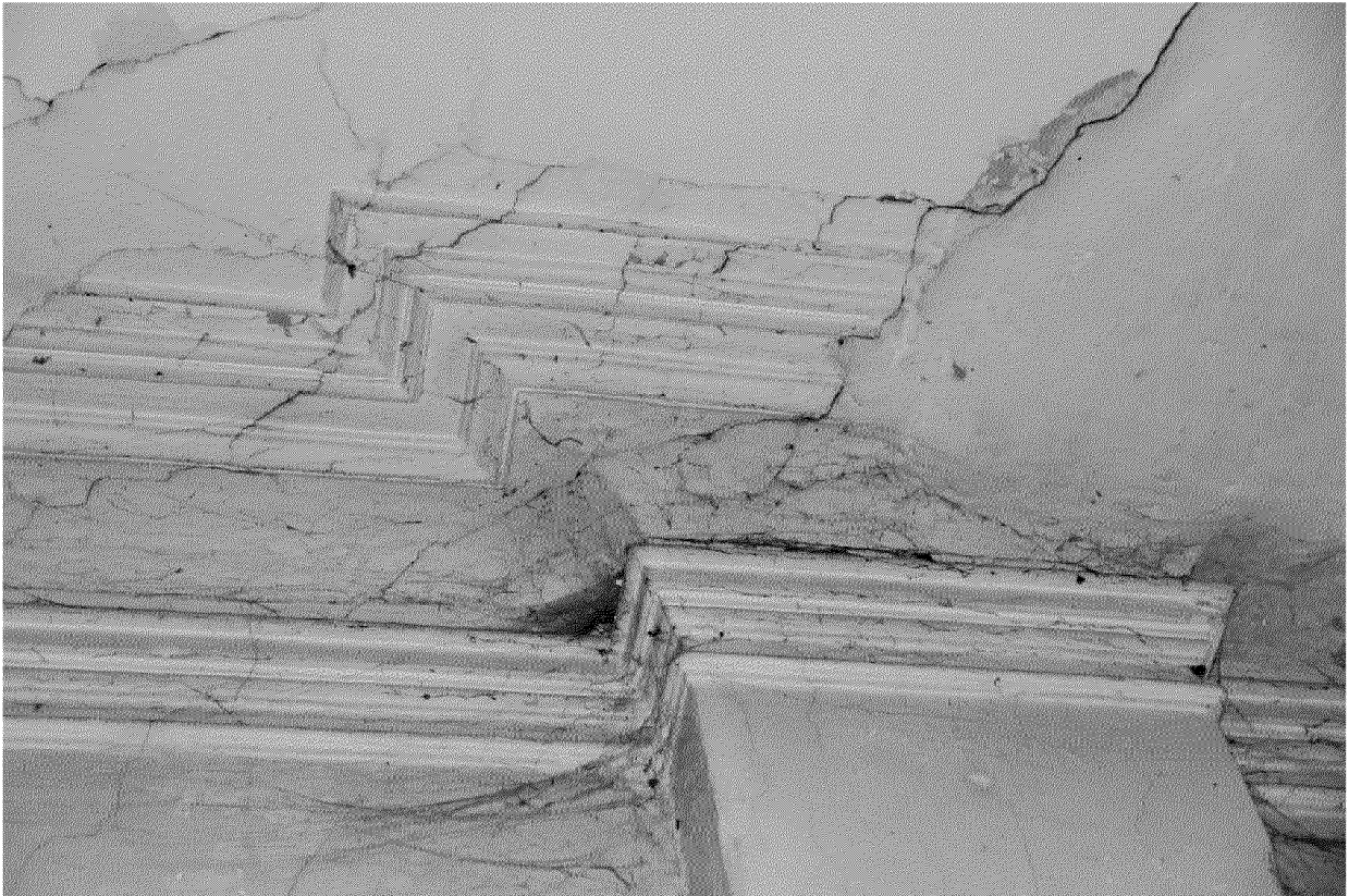
Видовая точка № 25 Помещение лестницы парадного входа. Профильные потолочно-стеновые тяги
