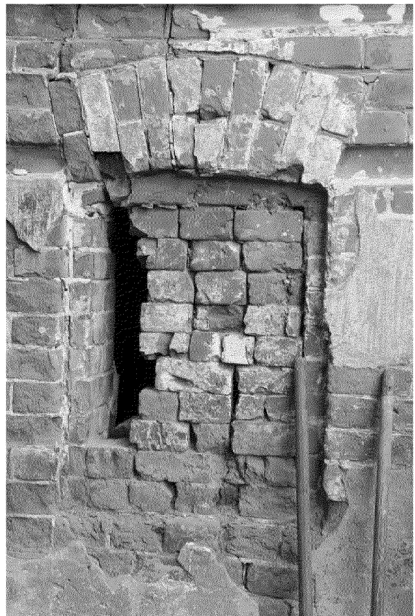
Видовая точка № 9 Лучковый оконный проем дворового ризалита
