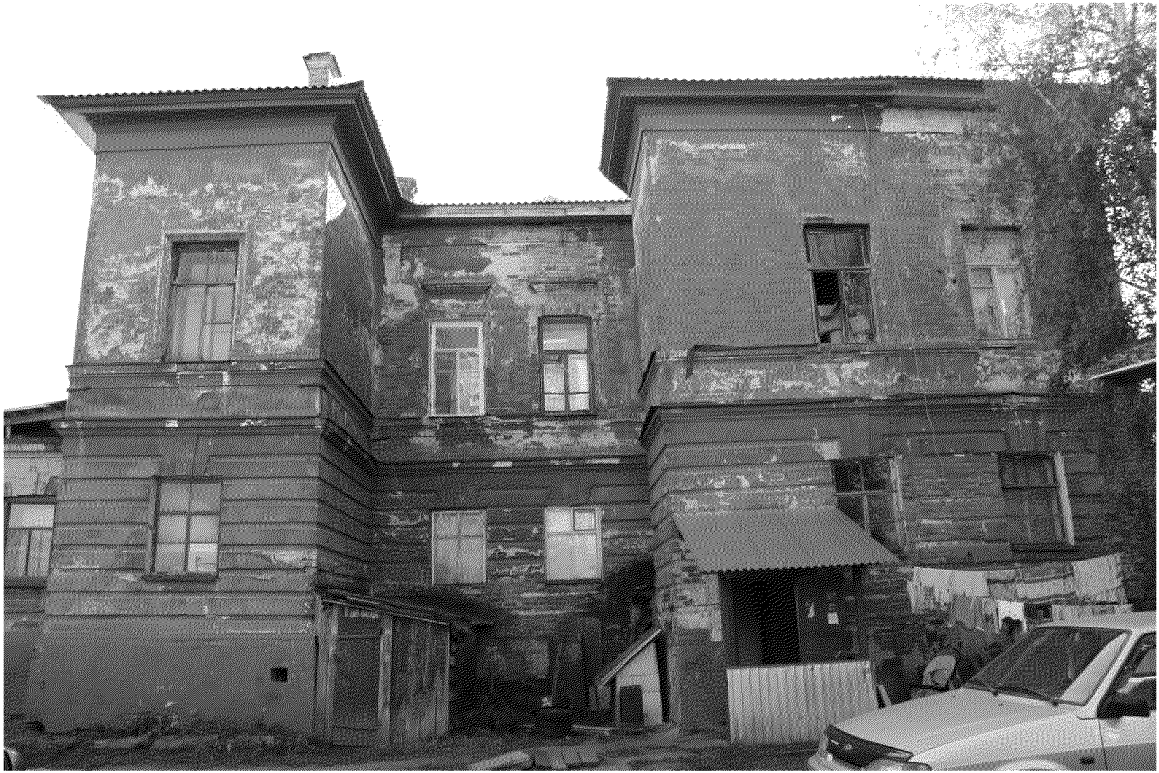
Видовая точка № 10 Фрагмент главного (восточного) фасада. Междуетажный пояс.
