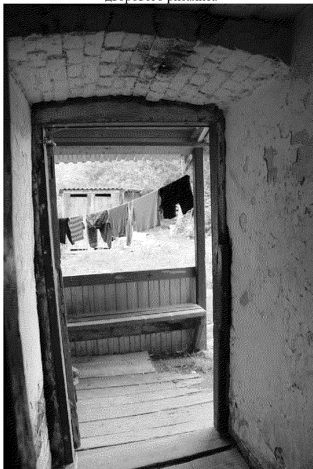
Видовая точка № 28 Лучковый дверной проем дворового входа
