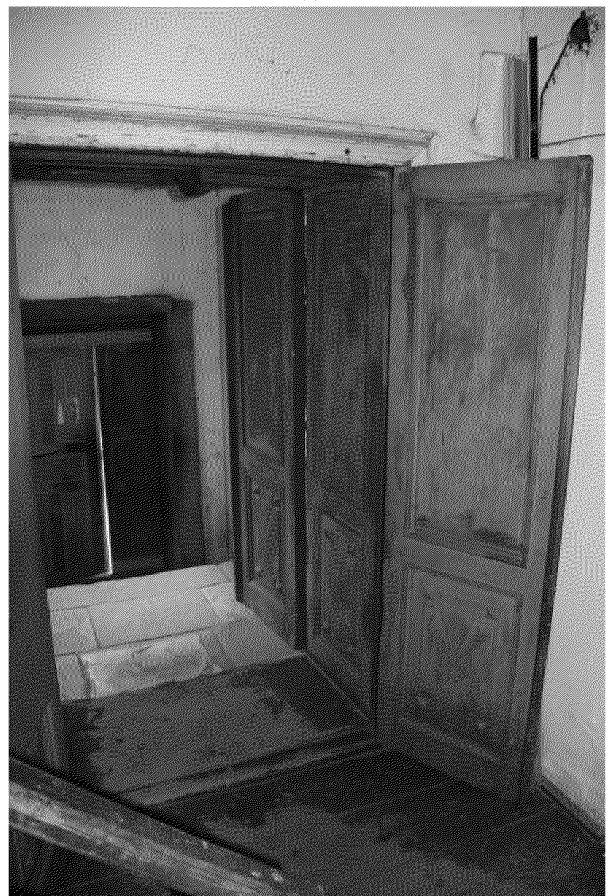
Видовая точка № 16 Деревянный филенчатый тамбур парадного входа.
