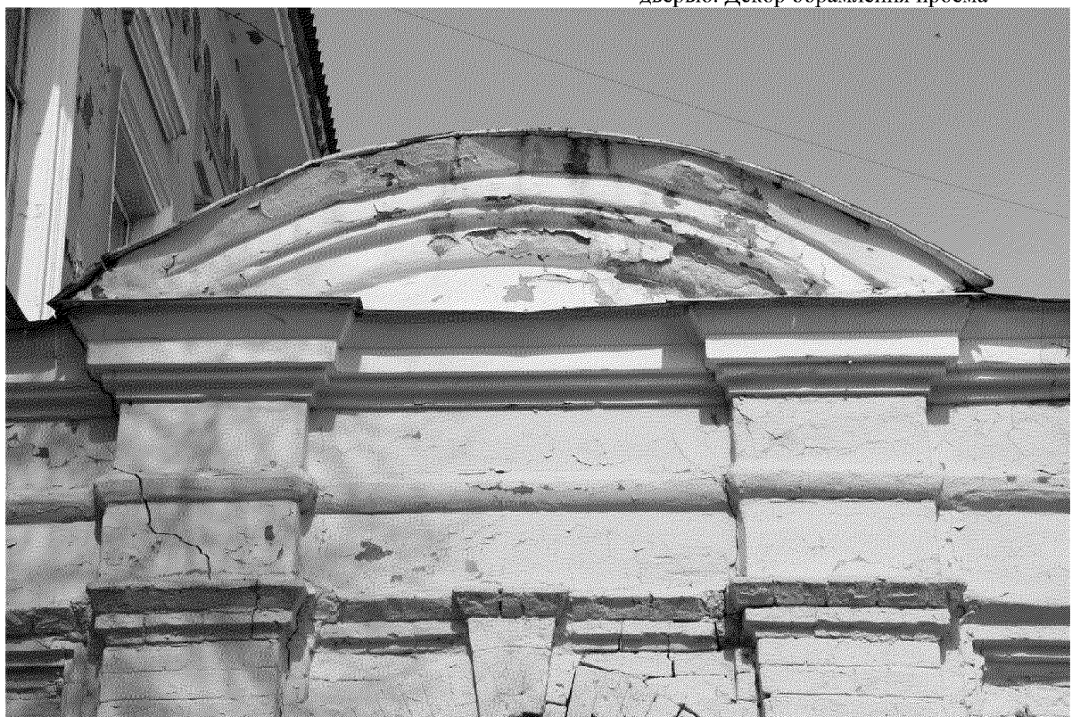
Видовая точка № 5 Фрагмент декора каменных ворот ограждения усадьбы (лучковый аттик, профильный карниз с широким фризом, профильные пояса, клинчатый замковый камень)
