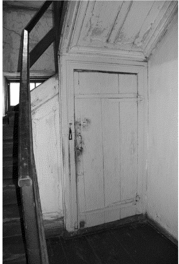
Видовая точка № 18 Дверь дощатая на шпонках и кованых навесах
