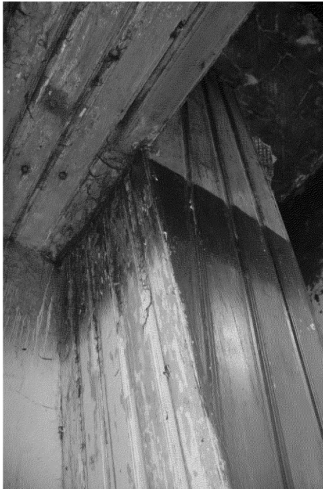
Видовая точка № 31 Профильная обшивка конструкции лестницы на чердак
