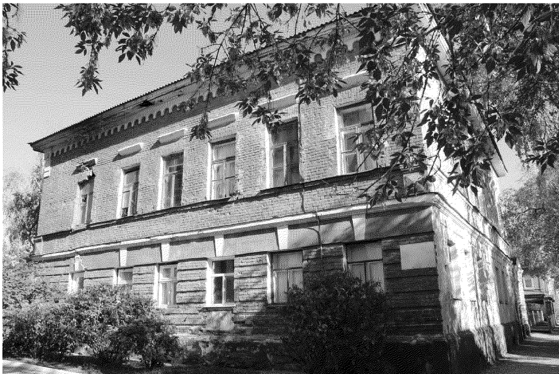
Видовая точка №2 Западный (боковой) фасад здания.
