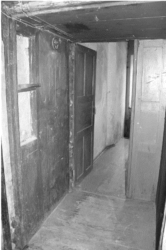
Видовая точка № 30 Тамбур дворового входа (между лестницей и коридором)
