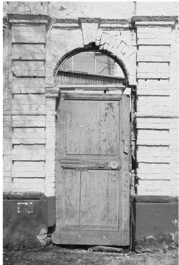
Видовая точка № 4 Арочный проем калитки с деревянной филенчатой дверью. Декор оформления проема
