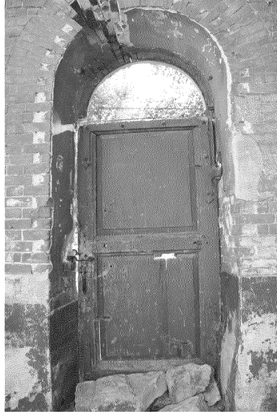
Видовая точка № 7 Проем калитки с арочной полуциркульной перемычкой, деревянная филенчатая дверь на кованых навесах. Металлическая скобяная фурнитура.
