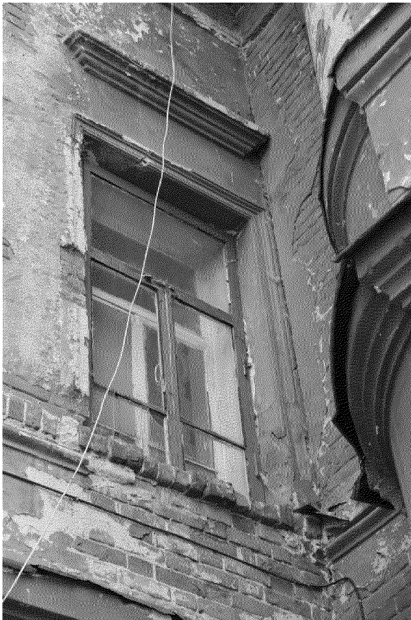
Видовая точка № 11 Окно 2-го этажа дворового фасада.
