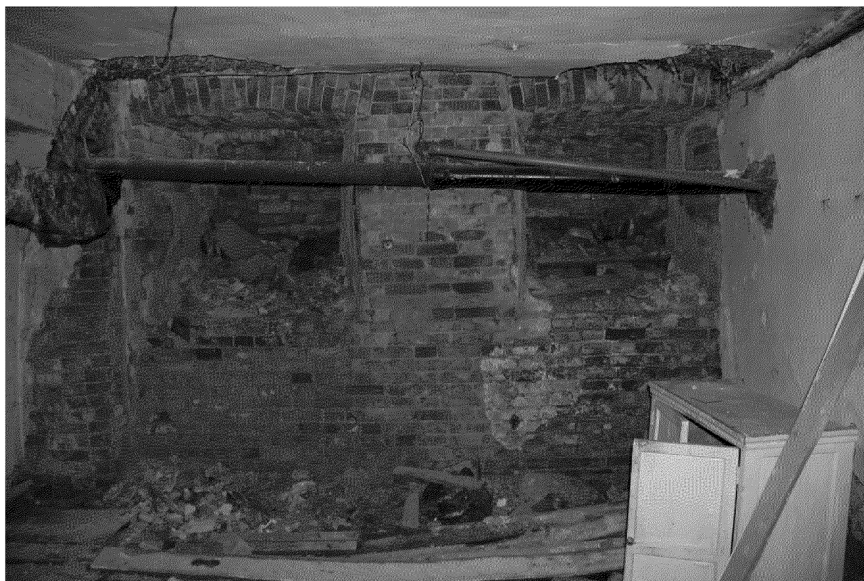
Видовая точка № 32 Фрагмент помещения подвала. Оконные проемы с лучковыми перемычками.
