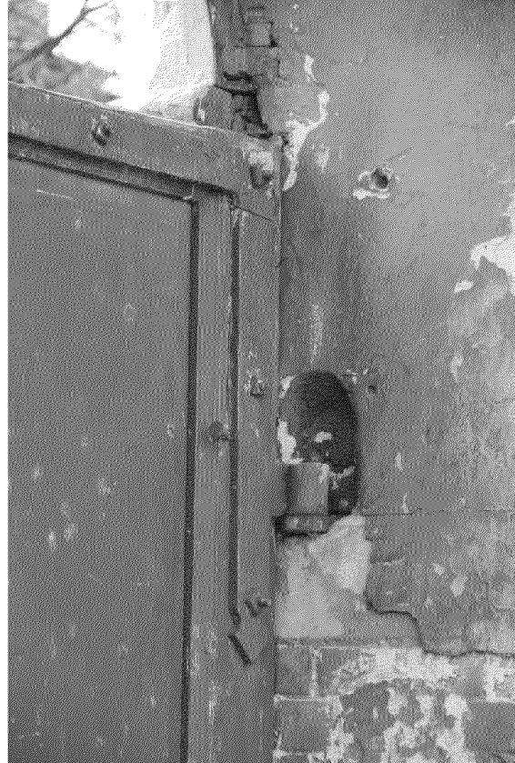
Видовая точка № 9 Элемент крепления створки ворот, кованый навес на блоке из песчаника
