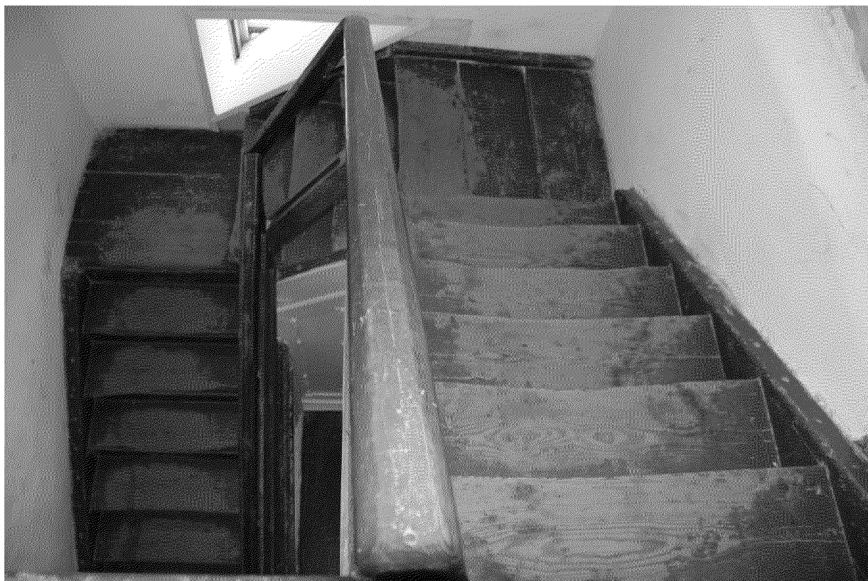
Видовая точка № 21 Деревянная трехмаршевая парадная лестница
