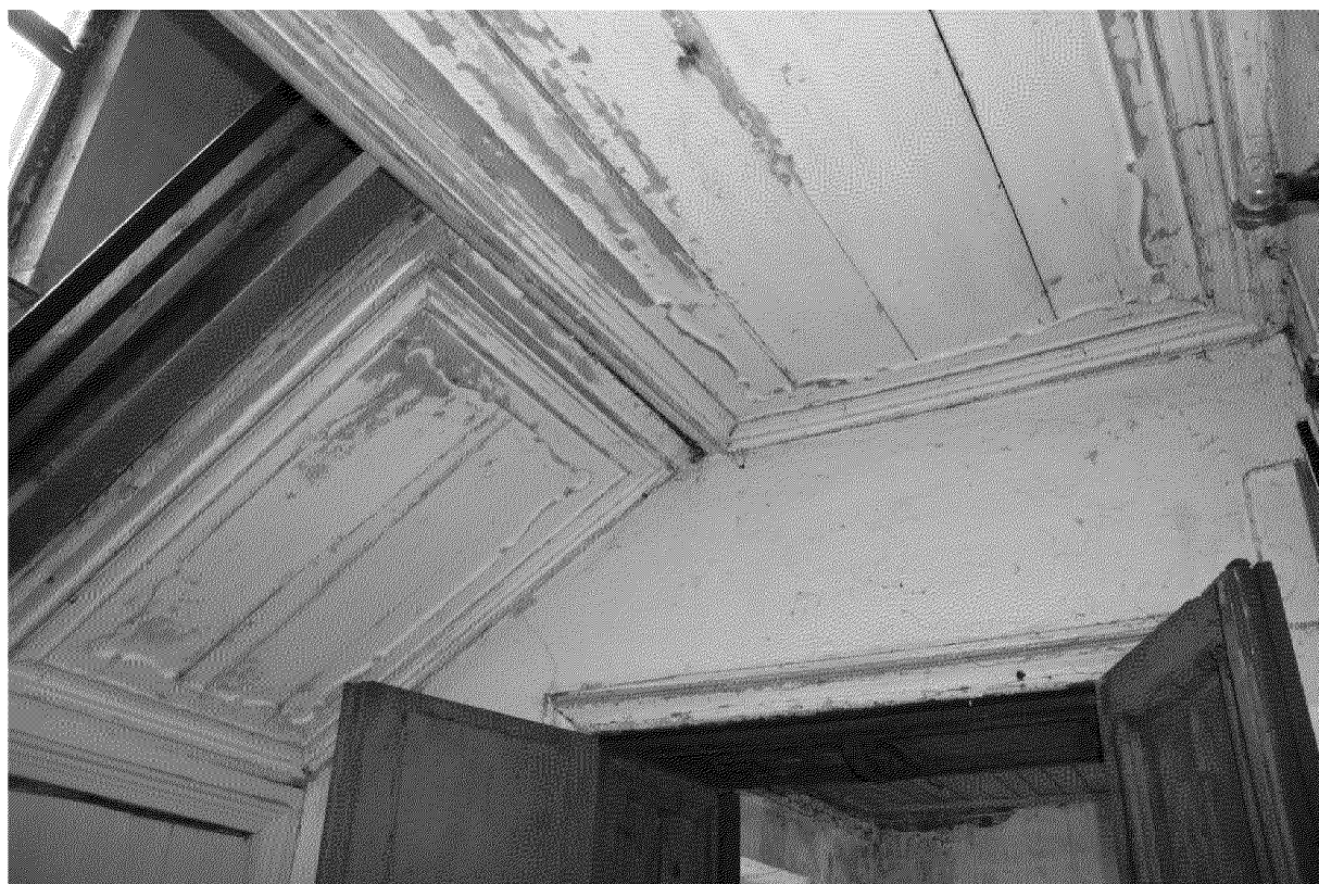
Видовая точка № 22 Декор подшивки лестничного марша и площадки
