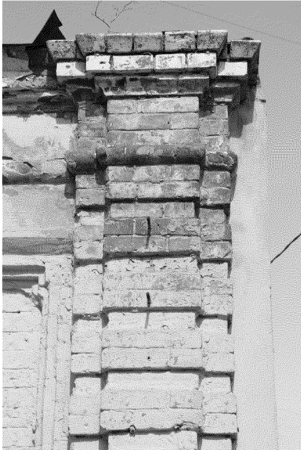
Видовая точка № 3 Фрагмент декора – рустованная пилястра
