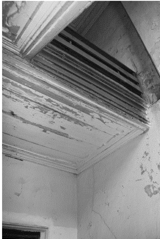
Видовая точка № 20 Фрагмент лестничной площадки с профильной обшивкой торцевой части
