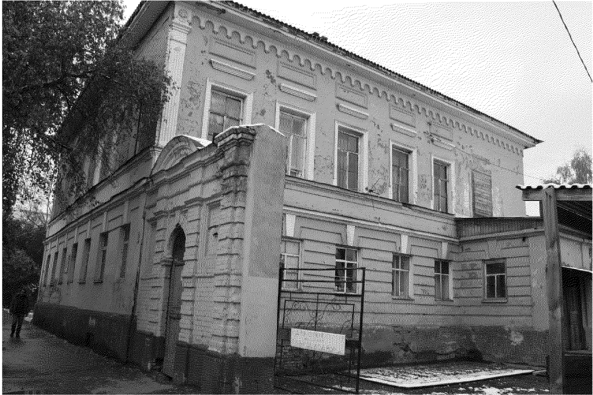
Видовая точка №3 Восточный (боковой) фасад здания.
