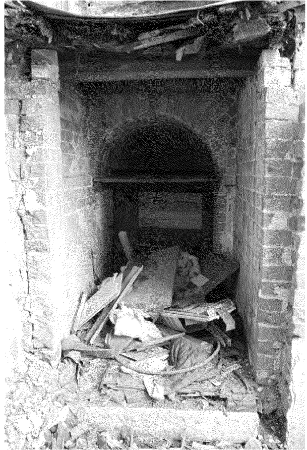
Видовая точка № 14 Арочный проем первоначального входа в подвал
