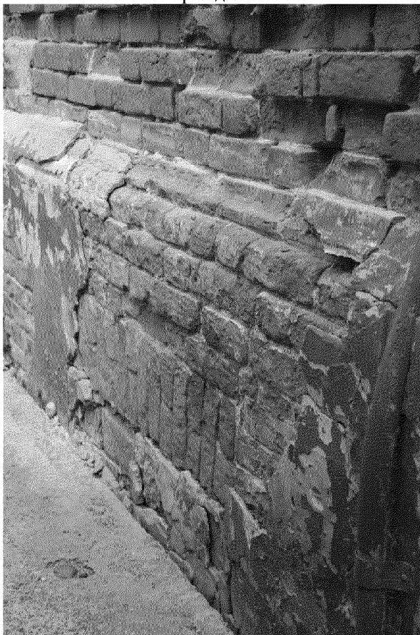
Видовая точка № 8 Цокольная часть фасада с профилированным поясом
