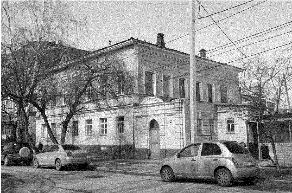
Видовая точка № 1. Общий вид здания с пер. Кооперативного.
