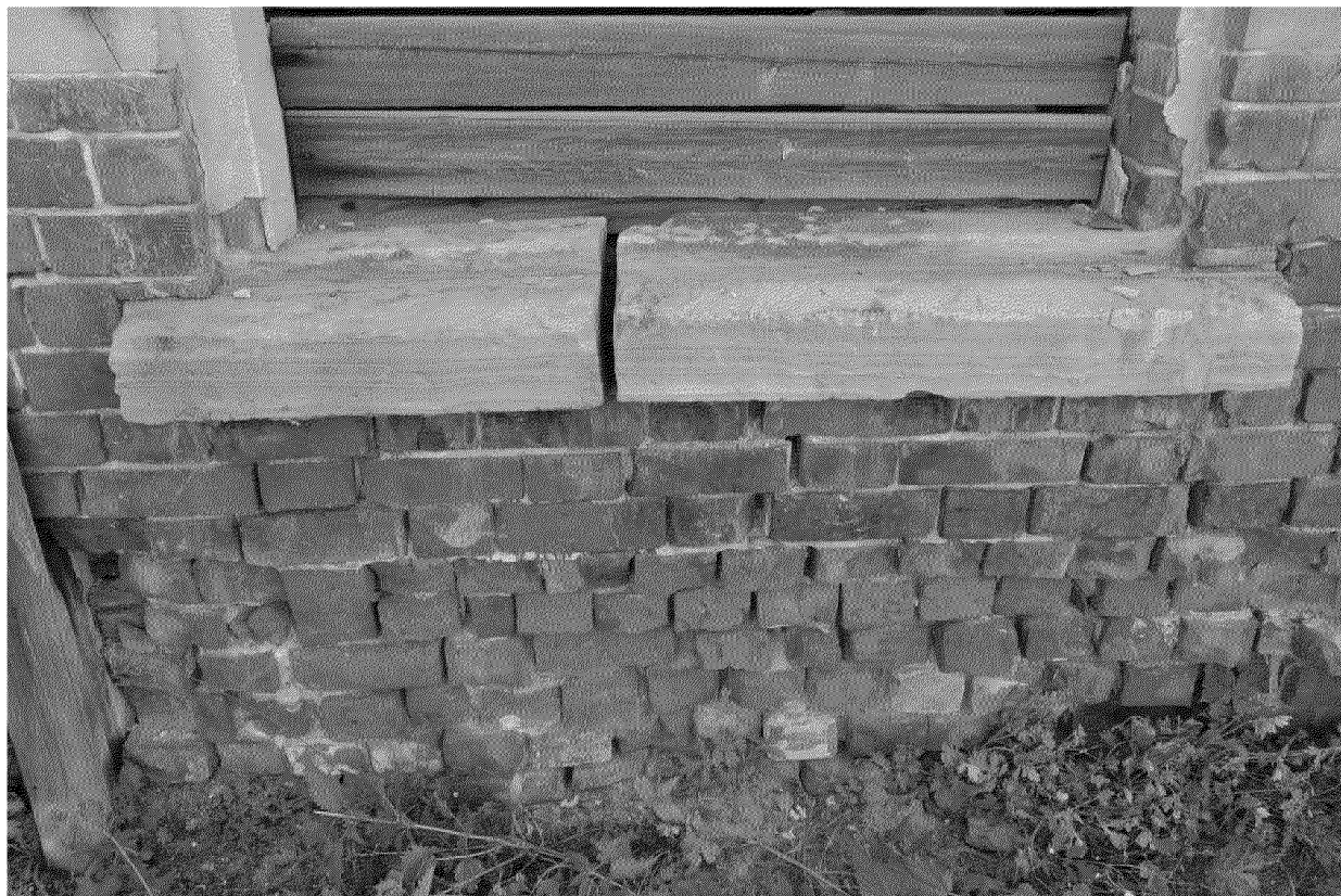
Видовая точка № 12. Подоконник из песчаника (автор снимка: Литвинова О.Г., дата съемки: 28.07.2017 г.)
