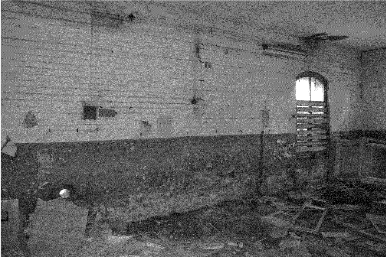
Видовая точка № 15. Общий вид помещения (Литвинова О.Г., 28.07.2017 г.)
