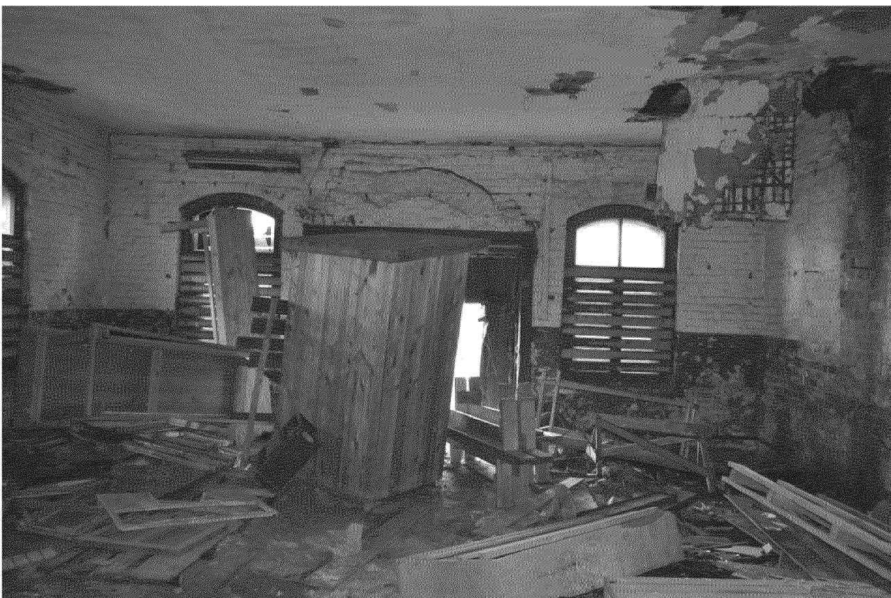
Видовая точка № 19. Общий вид внутреннего помещения здания (Литвинова О.Г., 28.07.2017 г.)
