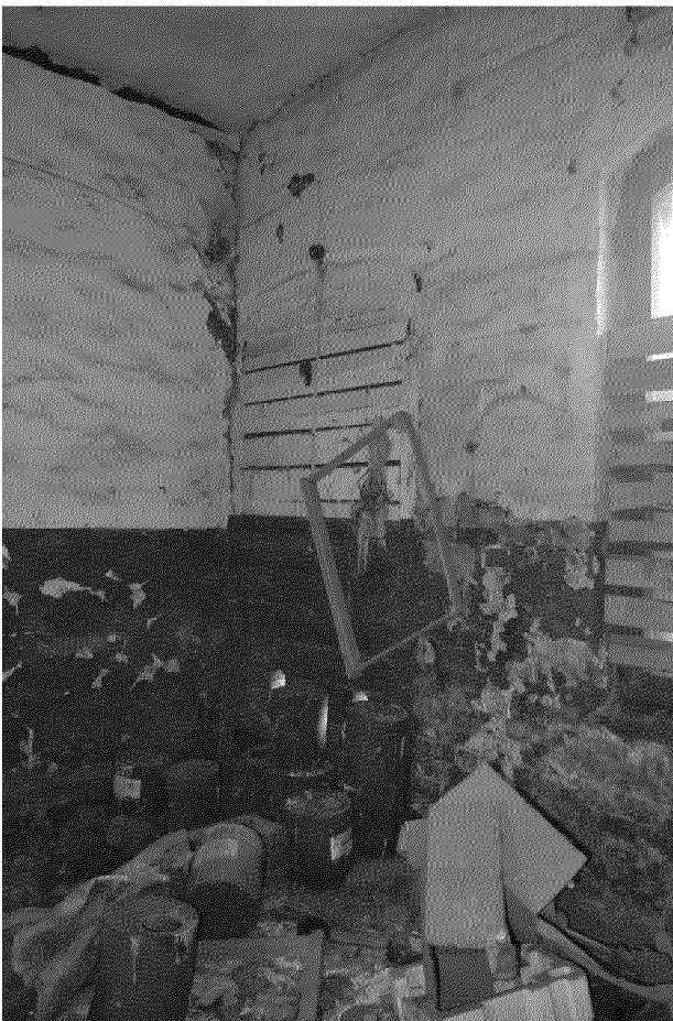
Видовая точка № 16. Фрагмент помещения (Литвинова О.Г., 28.07.2017 г.)
