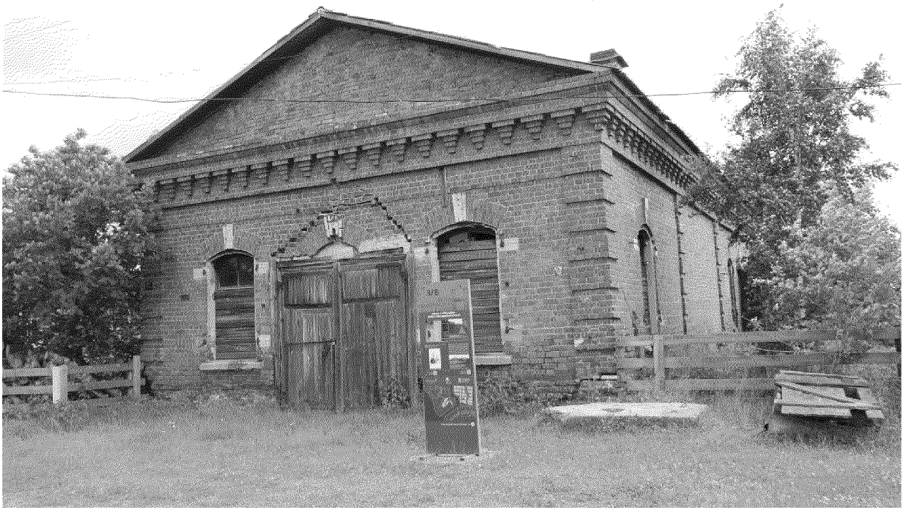
Видовая точка № 3. Главный (западный) фасад. Вид с ул. Куйбышева (автор снимка: Лырова Е.В., дата съемки: 10.07.2019 г.)
