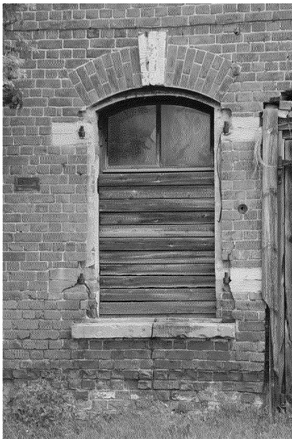
Видовая точка № 10. Окно западного фасада с коваными подставами для крепления ставней
