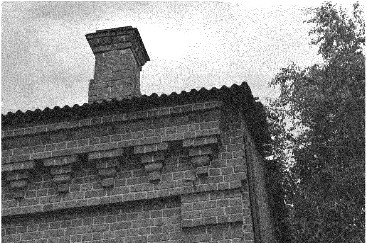
Видовая точка № 9. Печная труба в южно-восточной части здания (автор снимка: Литвинова О.Г., дата съемки: 28.07.2017 г.)
