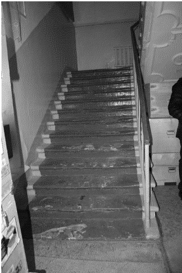
Видовая точка № 15 Двухмаршевая лестница из песчаника
