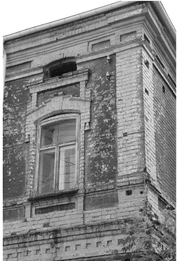
Видовая точка № 9 Фрагмент западного фасада. Лучковые окна 2-го этажа и чердака (Яблонская М.А., 04.07.2019)
