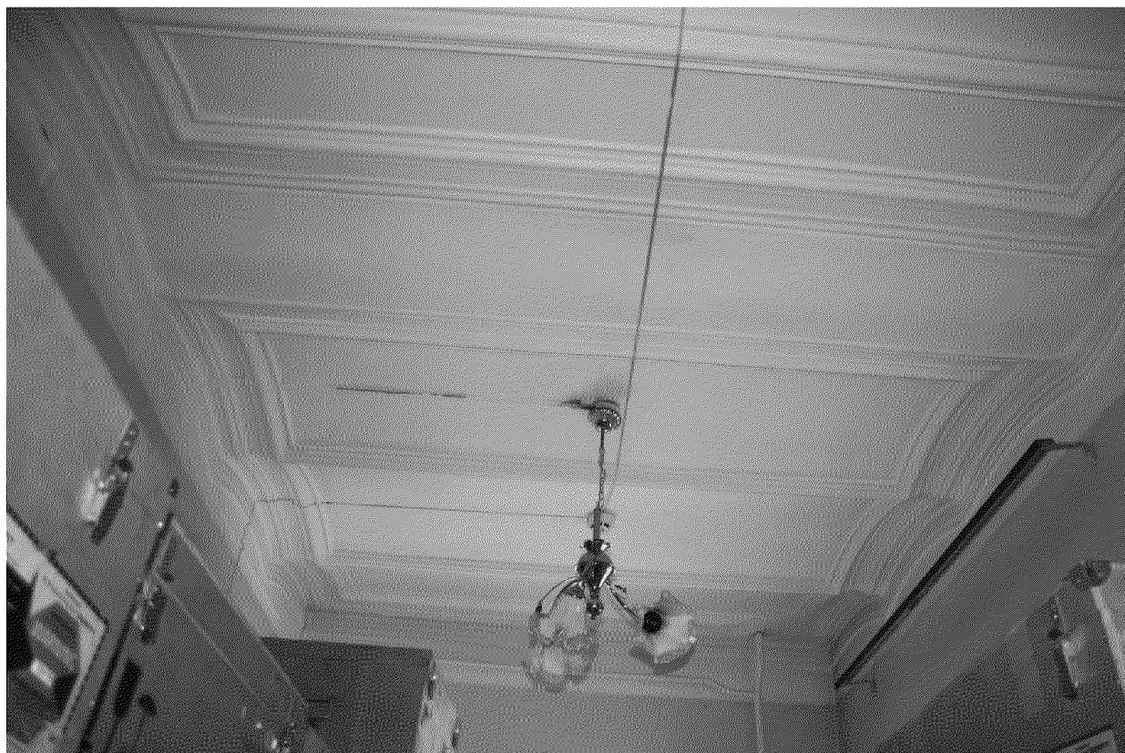
Видовая точка № 20 Профильный штукатурный декор кирпичных сводов перекрытия
