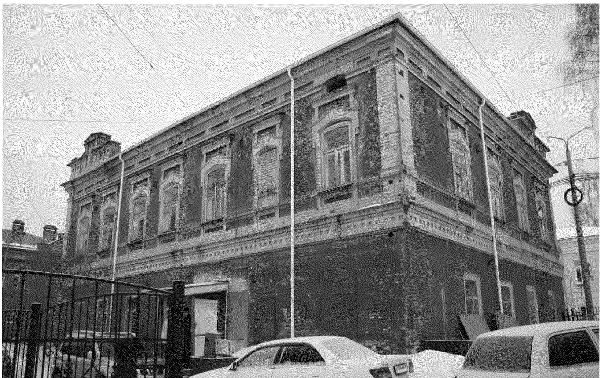
Видовая точка № 10 Общий вид здания с юго-западной стороны (Рыжикова А.Ю., 15.02.2017 г.)
