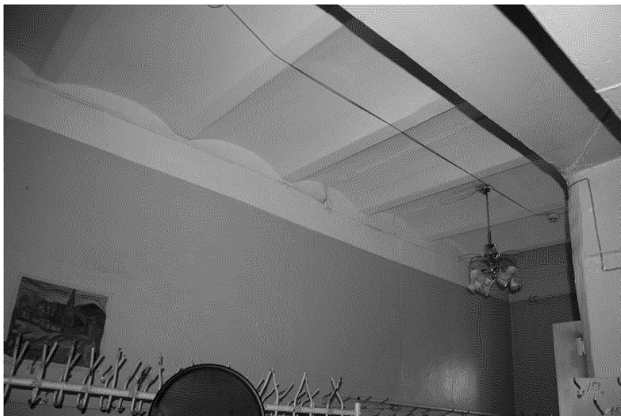
Видовая точка № 21 Кирпичные своды перекрытия в помещении 1-го этажа
