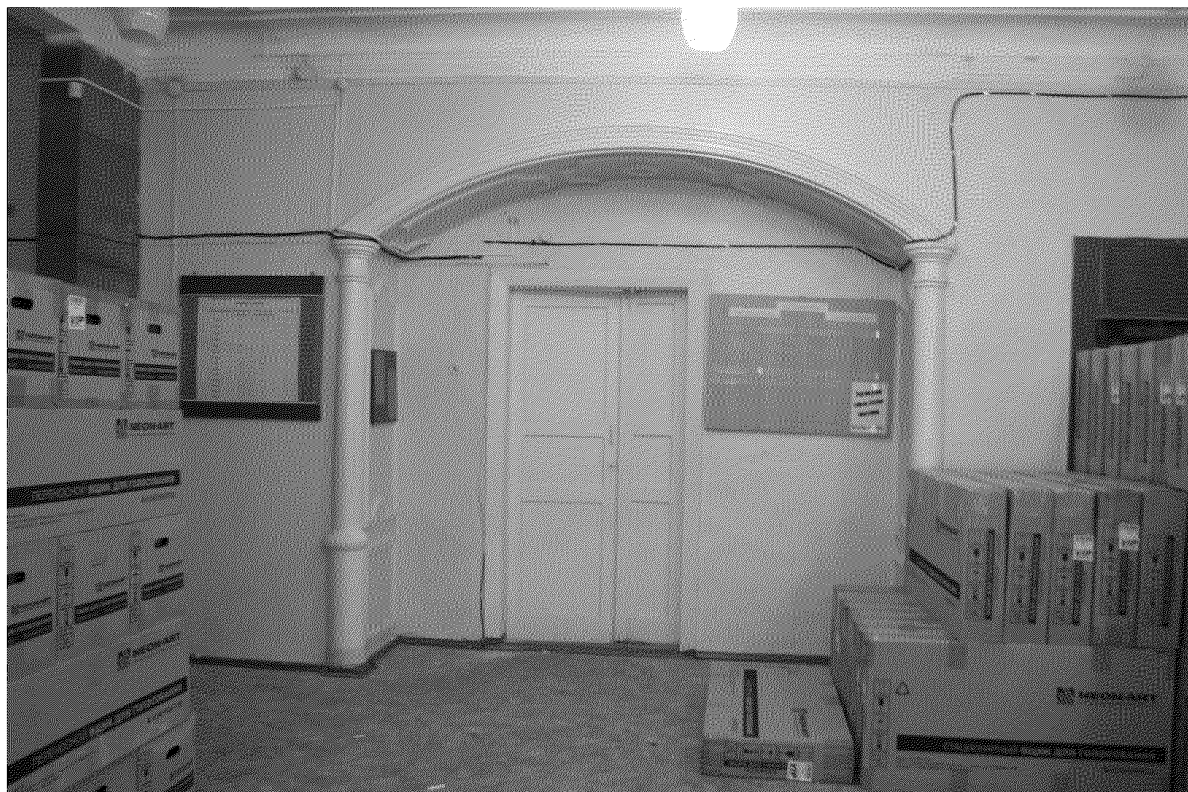
Видовая точка № 12 Фрагмент интерьера помещения 2-го этажа. Лучковая арка
