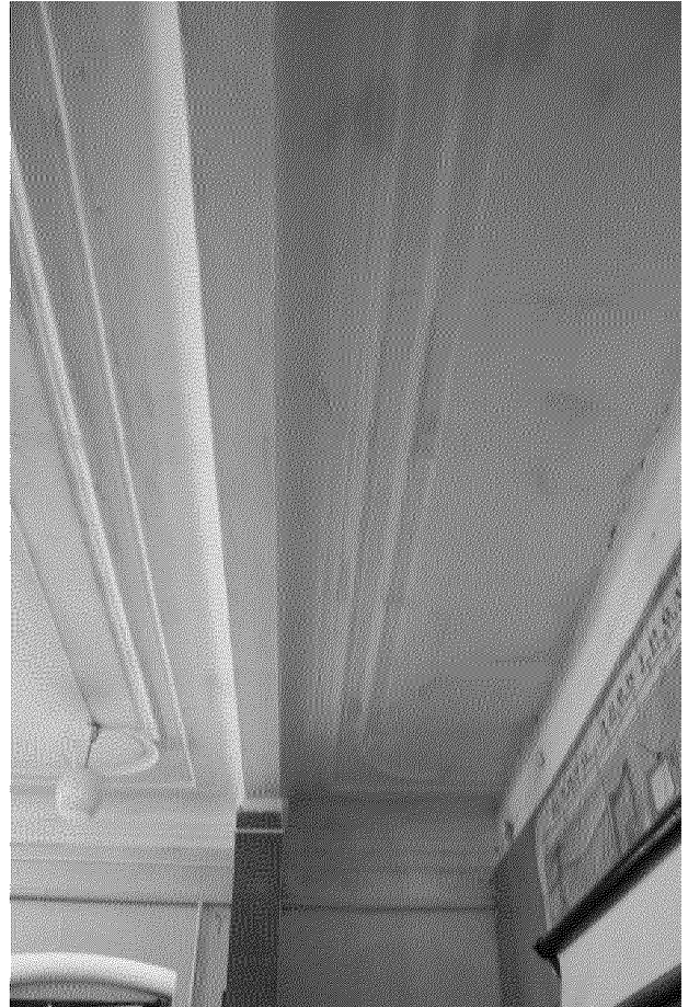
Видовая точка № 18 Фрагмент декора потолка (2-й этаж)
