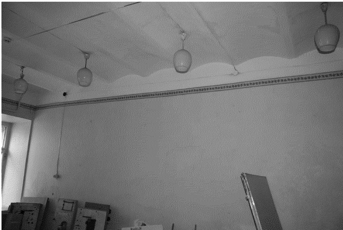
Видовая точка № 11 Фрагмент интерьера помещения 1-го этажа с кирпичными сводами перекрытия
