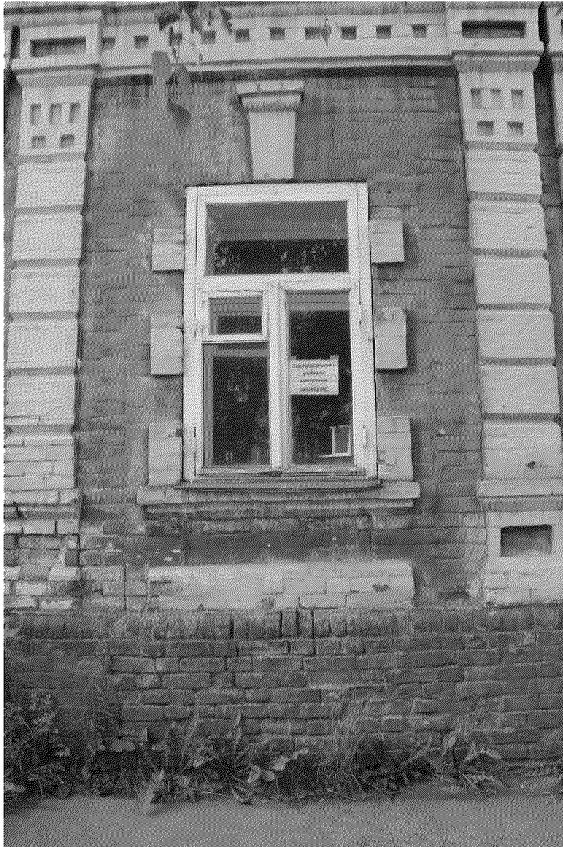
Видовая точка № 8 Фрагмент северного фасада. Местоположение первоначального входа. (Яблонская М.А., 04.07.2019)
