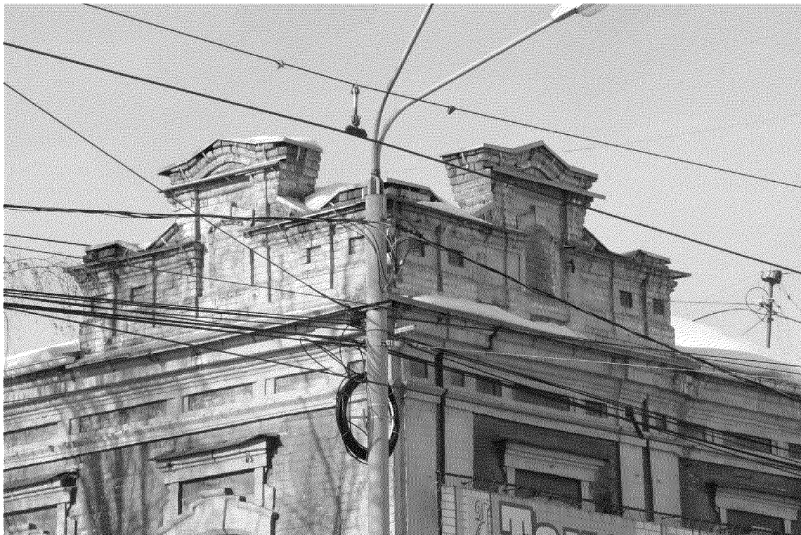
Видовая точка № 5 Фрагмент юго-восточного угла здания. Аттик в уровне крыши
