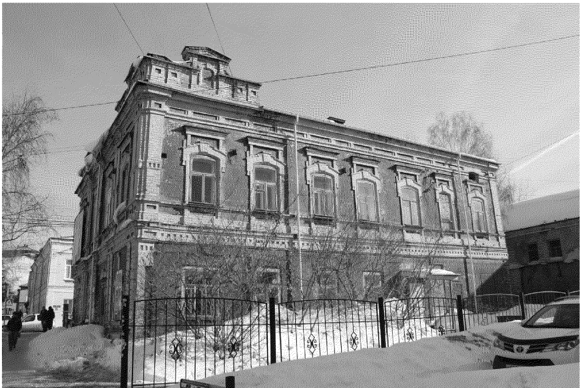
Видовая точка № 4 Западный фасад здания
