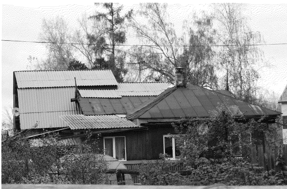
Видовая точка № 4 Южный фасад здания (2017 г.).
