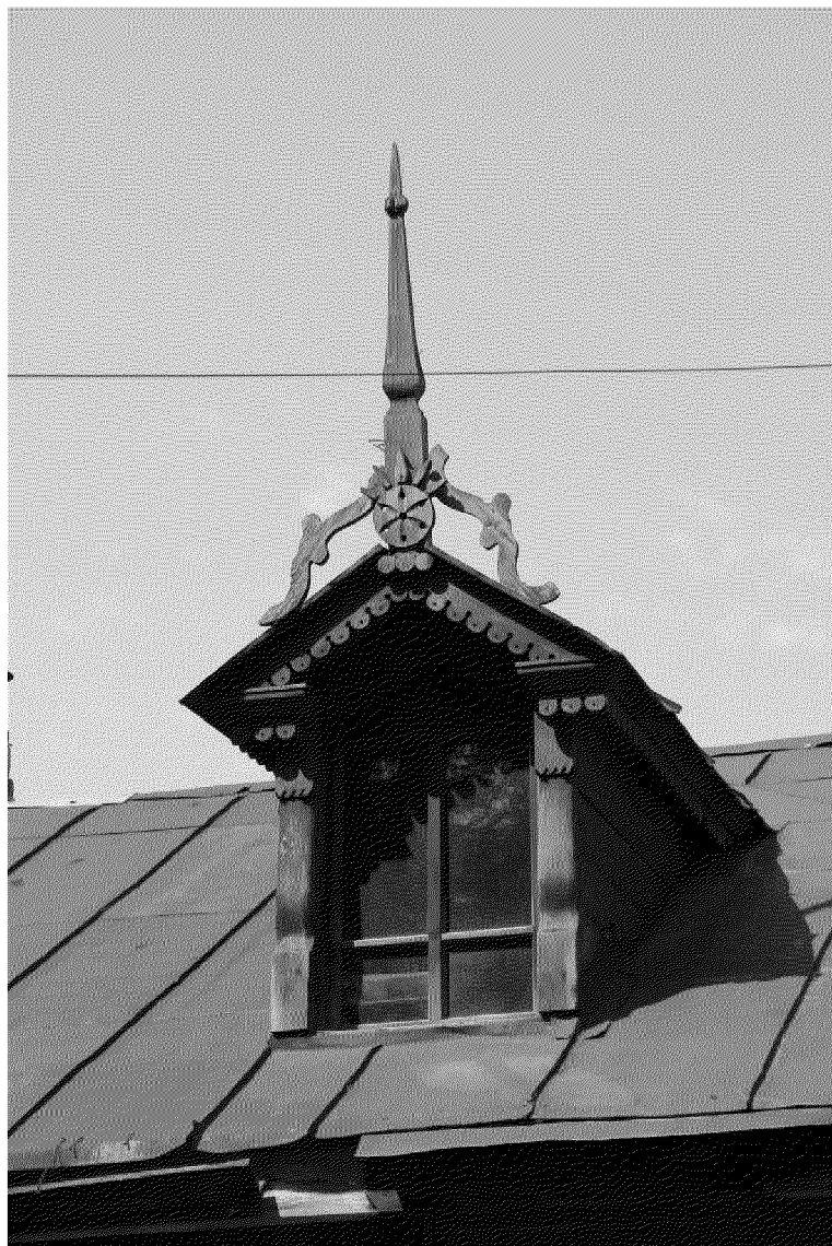
Видовая точка № 3 Фрагмент главного (восточного) фасада здания. Слуховое окно.
