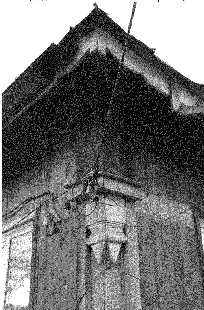
Видовая точка № 6 Фрагмент декоративного оформления угловой лопатки главного фасада здания (2017 г.)
