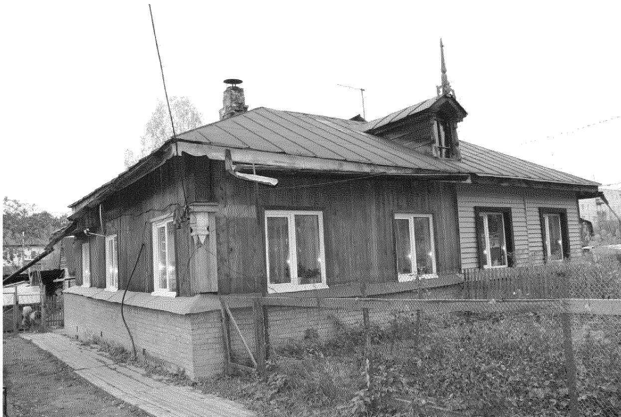
Видовая точка № 5 Общий вид здания с юго-восточной стороны (2017 г.).
