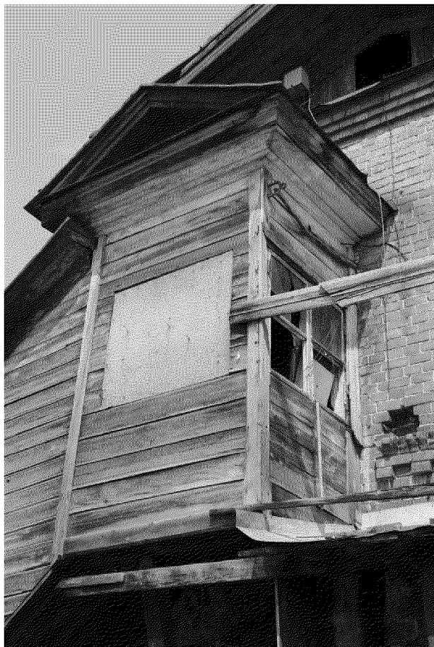
Видовая точка № 4 Фрагмент южного фасада здания. Пристройка лестничного блока.
