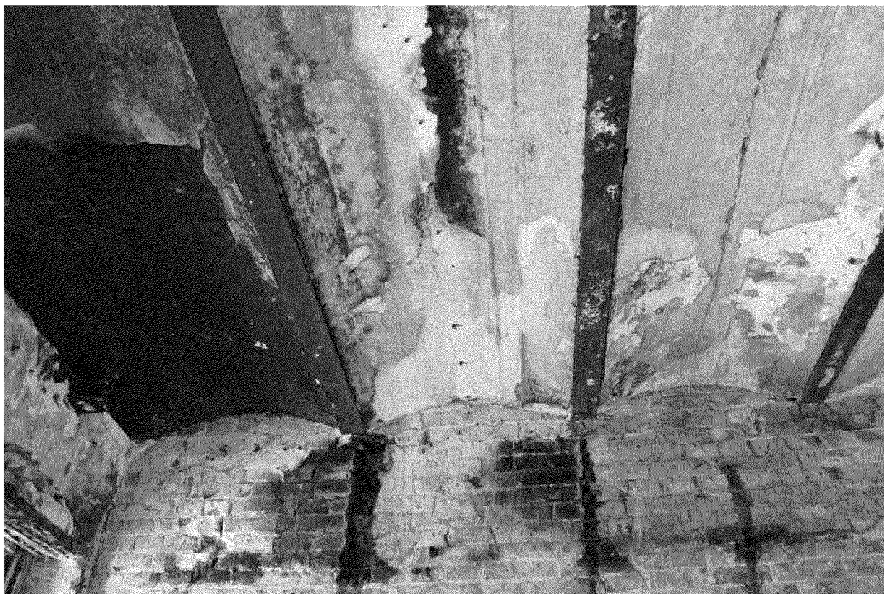
Видовая точка № 10 Фрагмент перекрытия из кирпичных сводов по металлическим балкам.
