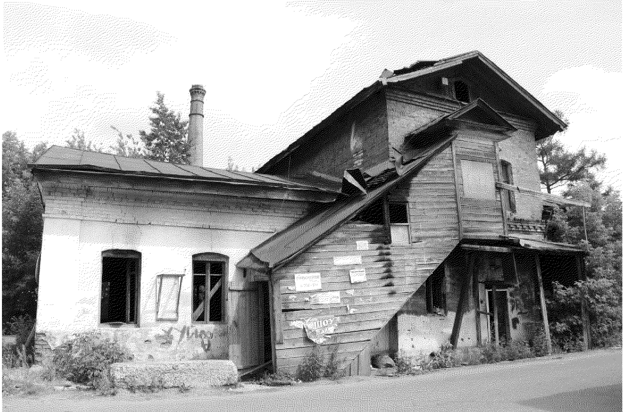
Видовая точка № 3. Южный фасад здания.
