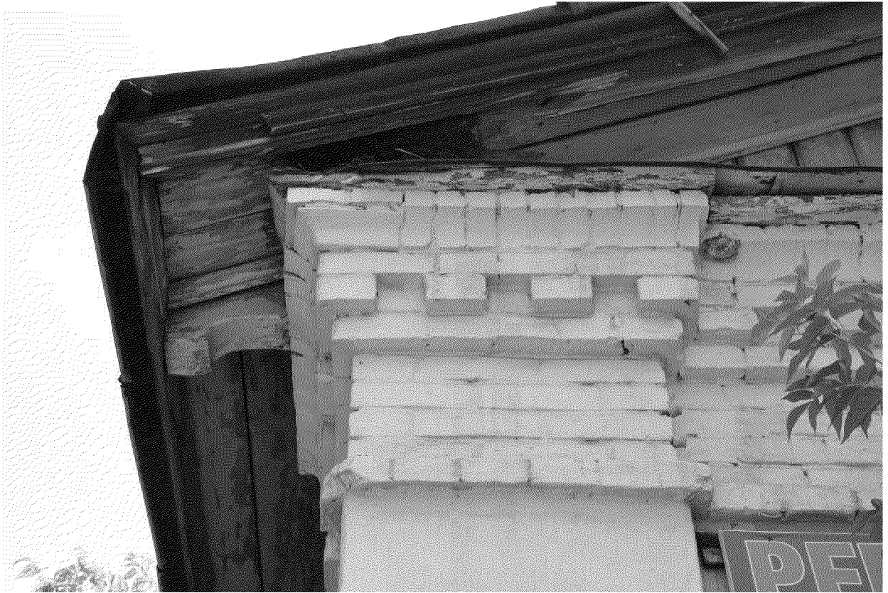
Видовая точка № 6 Фрагмент карниза западного фасада здания.
