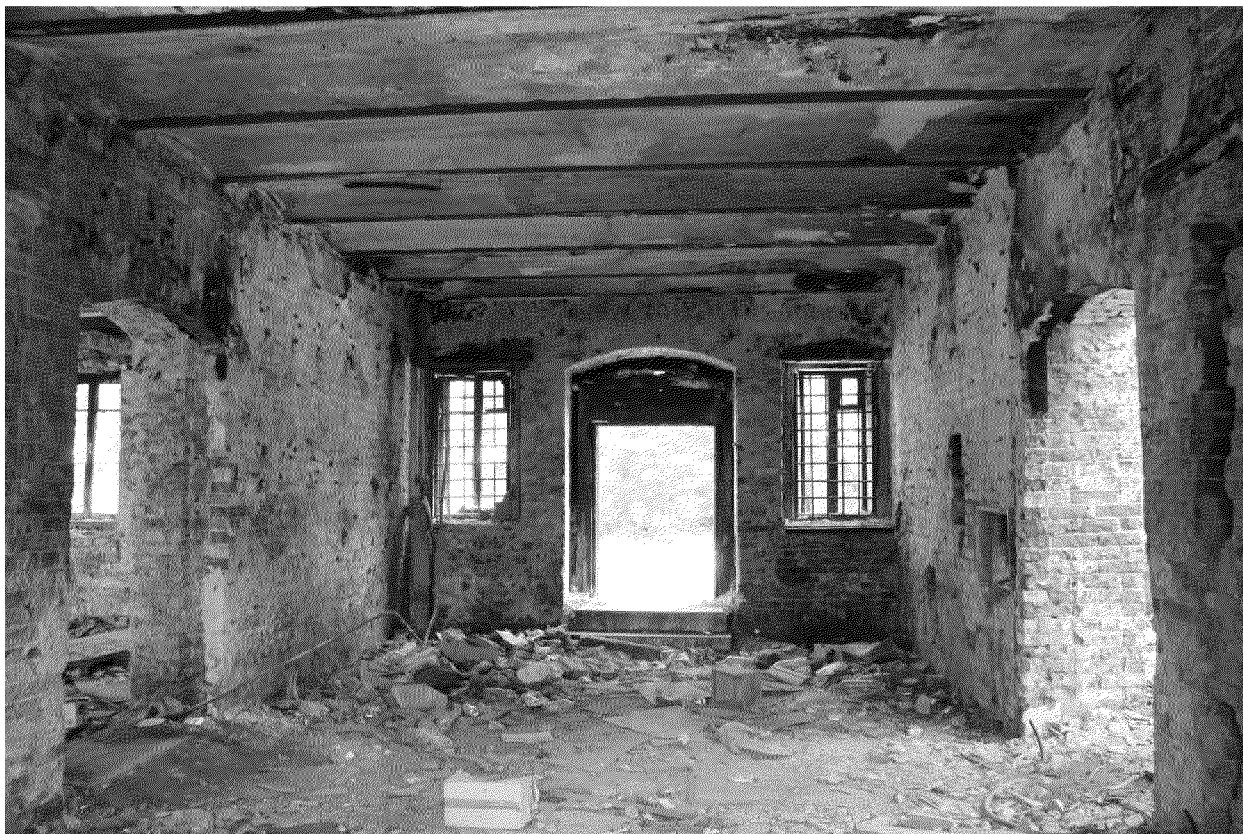
Видовая точка № 9 Общий вид помещения 1-го этажа центральной части здания.
