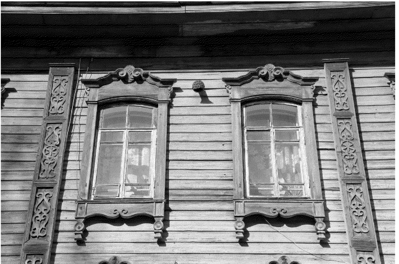
Видовая точка № 4. Фрагмент восточного фасада здания. Окна 2-го этажа.
