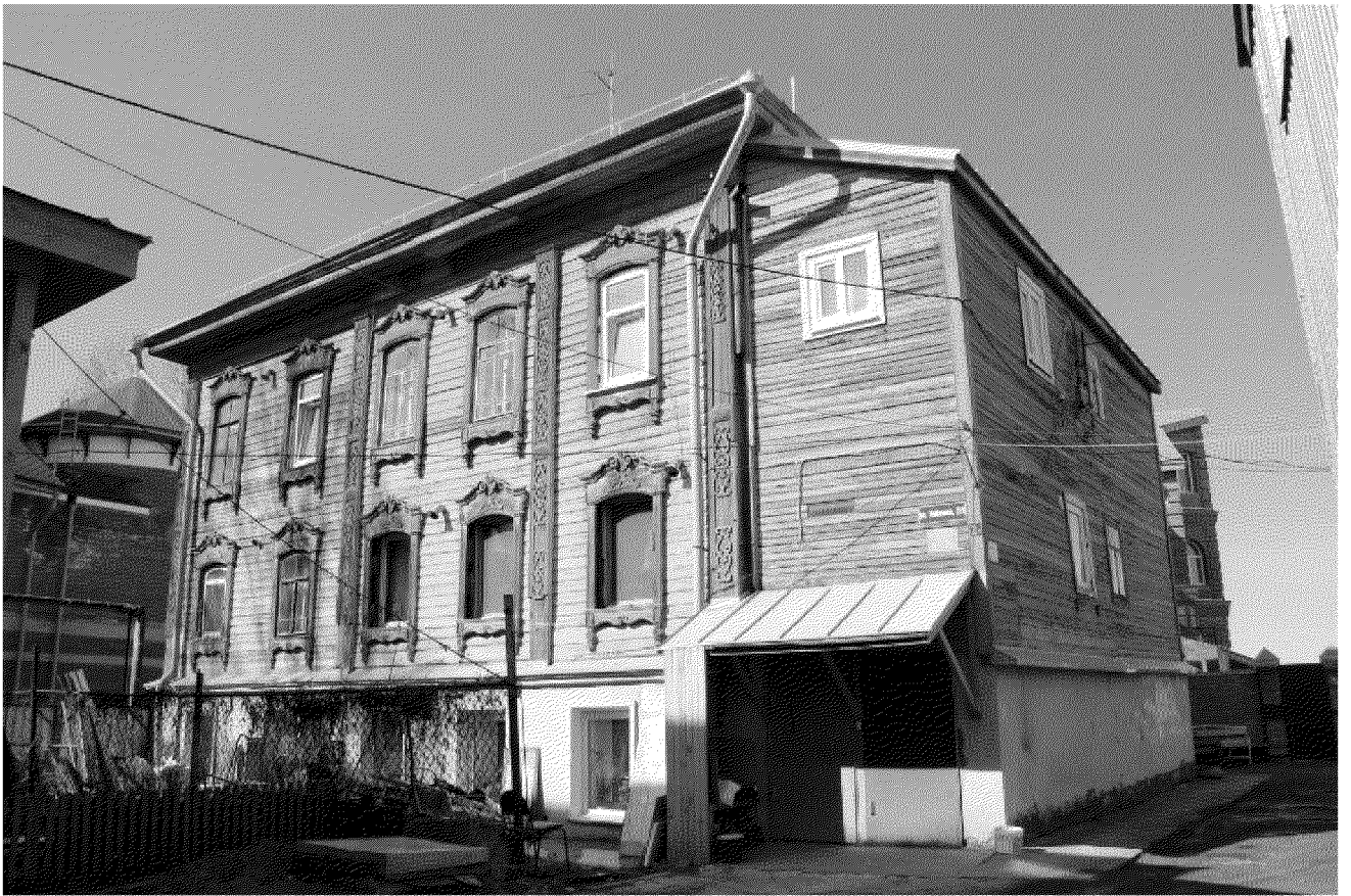
Видовая точка № 3. Восточный фасад здания (вид с территории двора).
