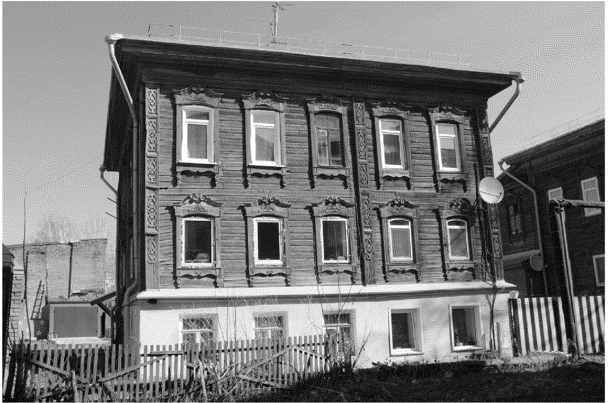
Видовая точка № 5. Южный фасад здания
