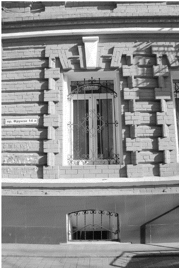
Видовая точка № 3 Оконный проем 1-го этажа главного фасада и его декор
