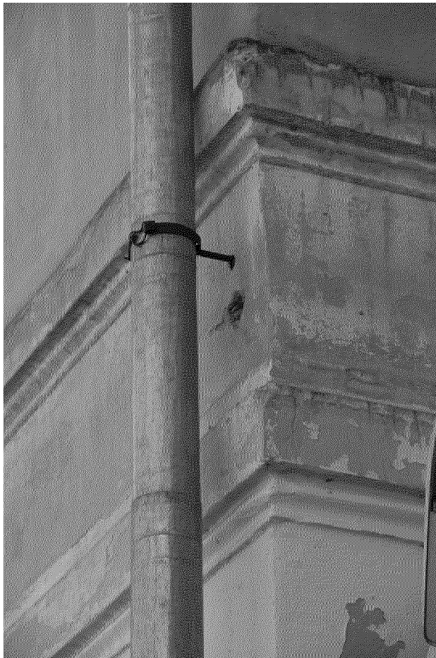
Видовая точка № 10 Фрагмент фасада ризалита. Междуэтажные пояса со штукатурными профильными тягами
