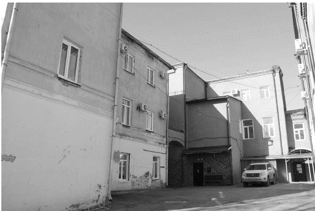
Видовая точка № 5 Общий вид усадьбы с внутри дворовой территории
