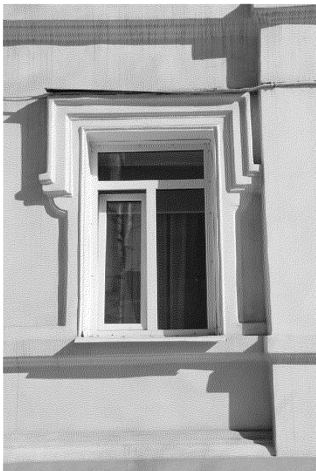
Видовая точка № 5 Оконный проем 1-го этажа и его декор
