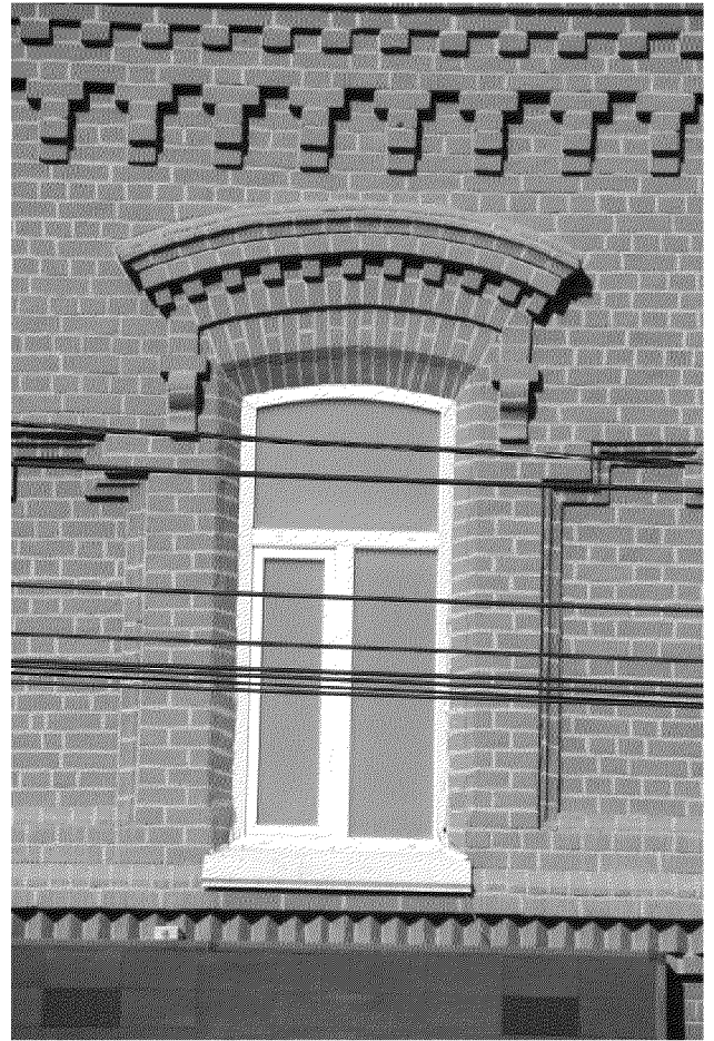
Видовая точка № 4 Оконный проем 2-го этажа главного фасада и его декор
