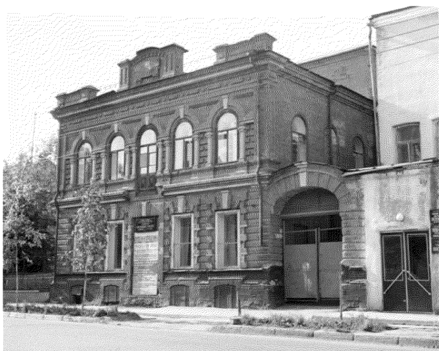
Видовая точка № 13 Общий вид здания с пр. Фрунзе (Коханенко П.Н., 1968-1974 гг.)
