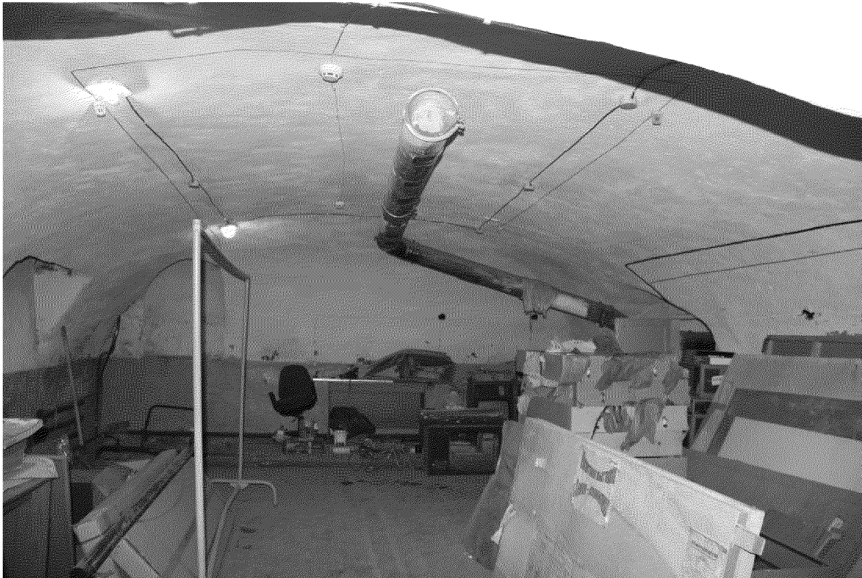
Видовая точка № 14 Помещение подвала, кирпичный свод перекрытия с распалубками
