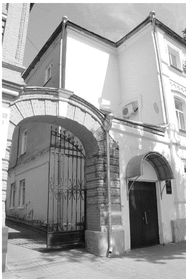
Видовая точка № 7 Фрагмент главного фасада. Арка ворот проезда во двор
