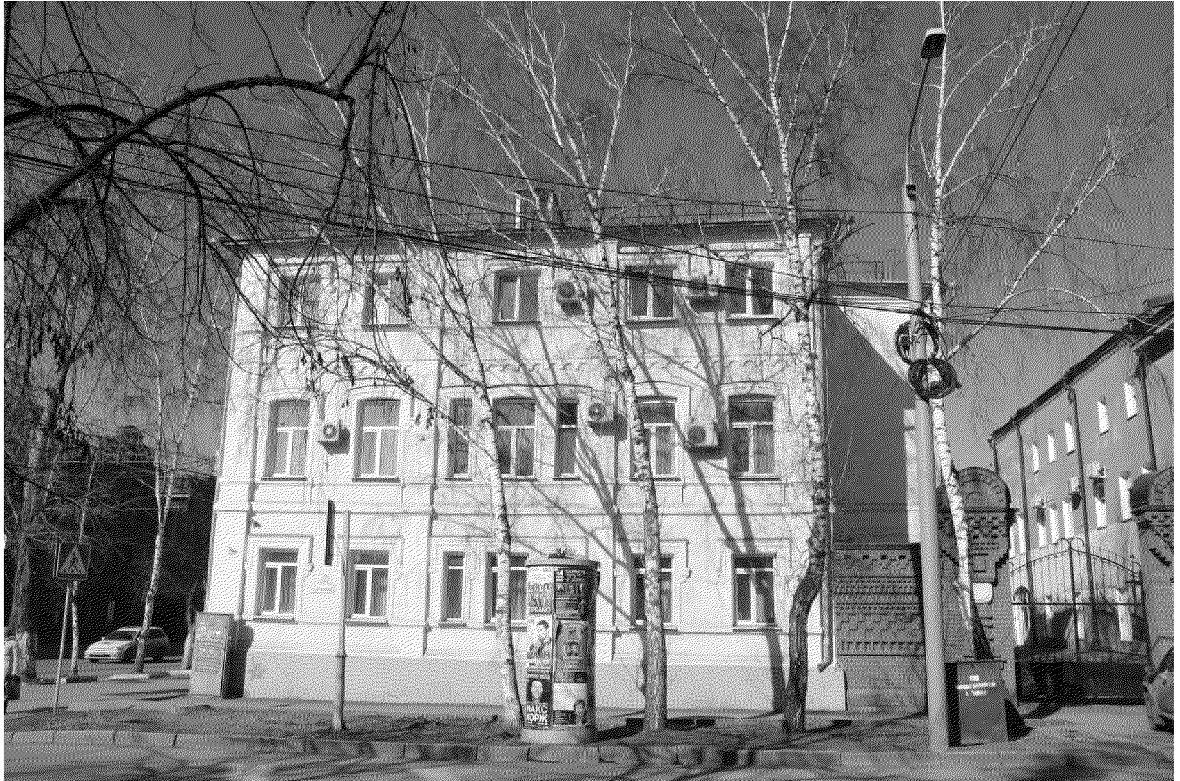
Видовая точка № 3 Восточный фасад здания, вид с ул. Крылова
