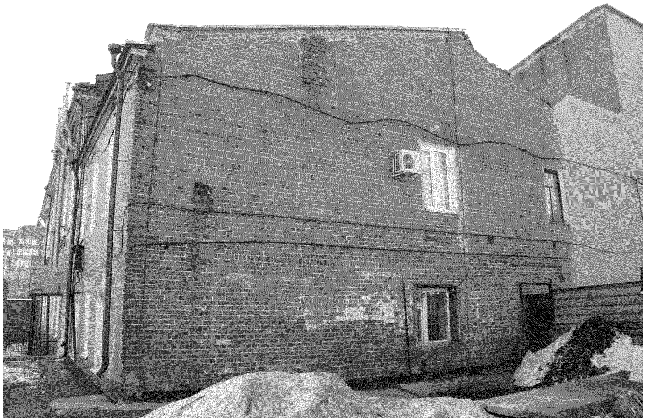
Видовая точка № 5 Западный фасад здания (брандмауэрная стена)
