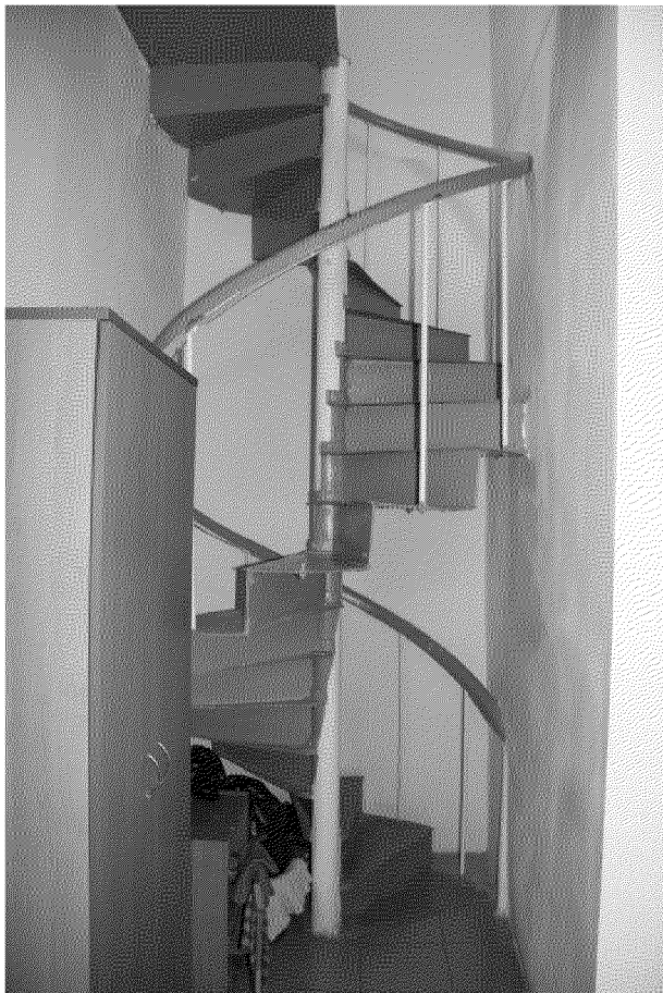
Видовая точка № 12 Металлическая винтовая лестница (ризалит северного фасада)
