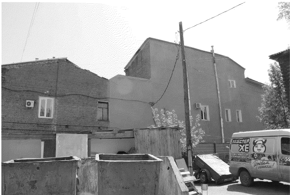
Видовая точка № 11 Западный фасад здания (брандмауэрная стена)
