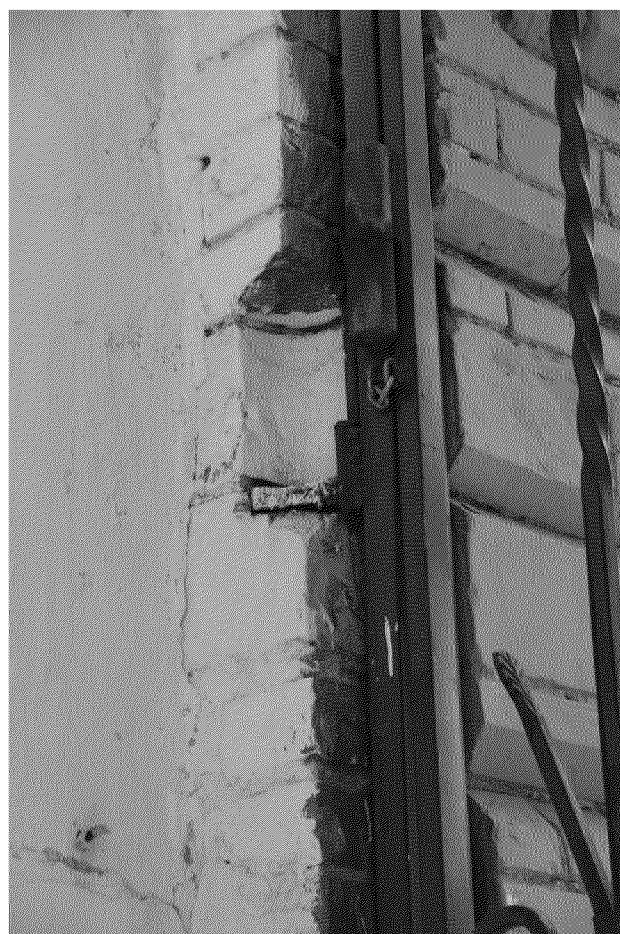
Видовая точка № 8 Кованый подстав для навески ворот (частично утрачен)
