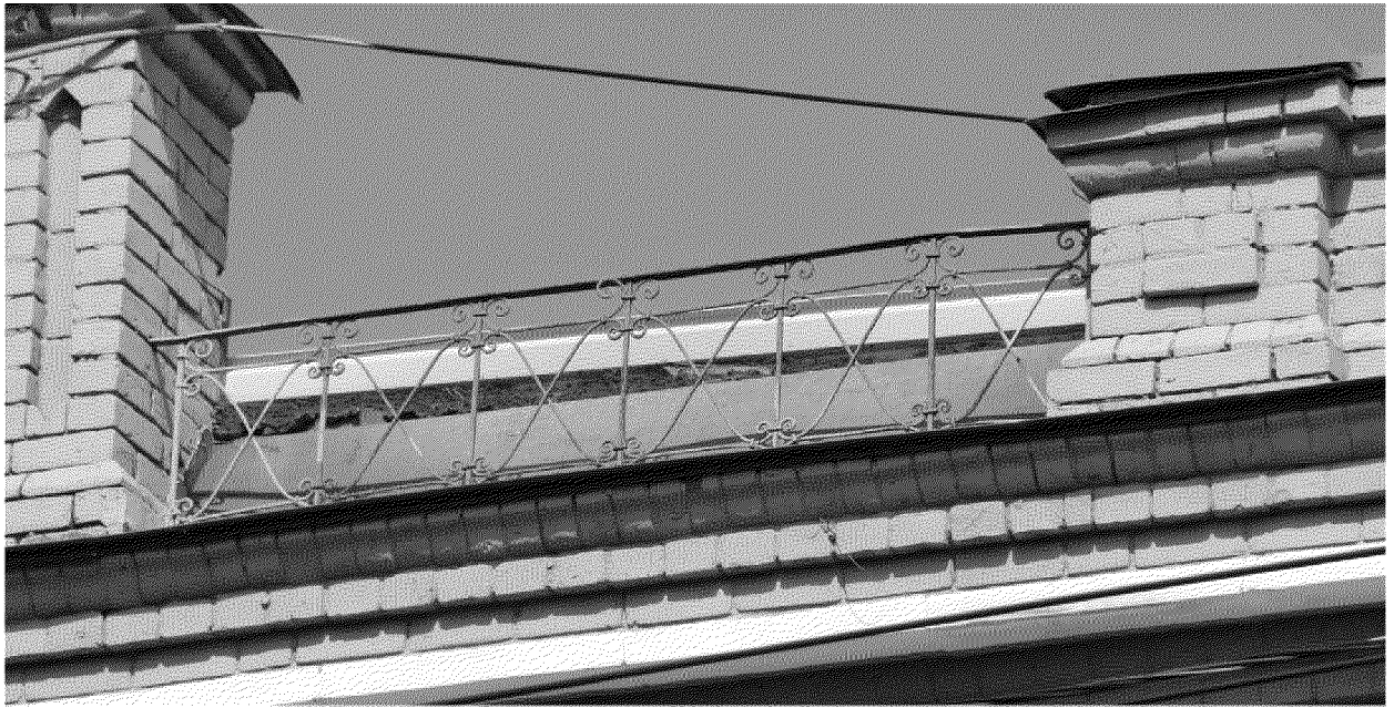
Видовая точка № 9 Решетка парапетного ограждения главного фасада
