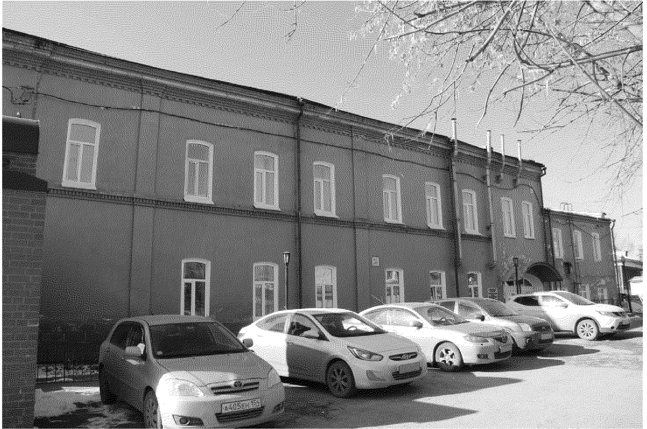
Видовая точка № 6 Северный фасад здания (вид с территории двора)
