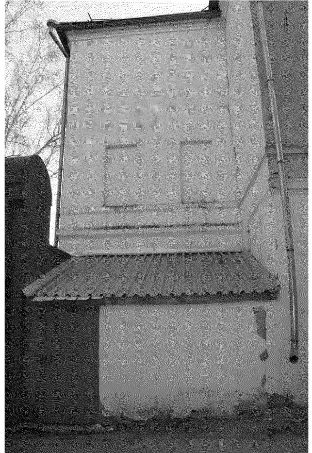
Видовая точка № 11 Фрагмент северного фасада основного объема (ниши)
