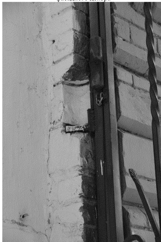
Видовая точка № 6 Кованый подстав для навески ворот (частично утрачен)
