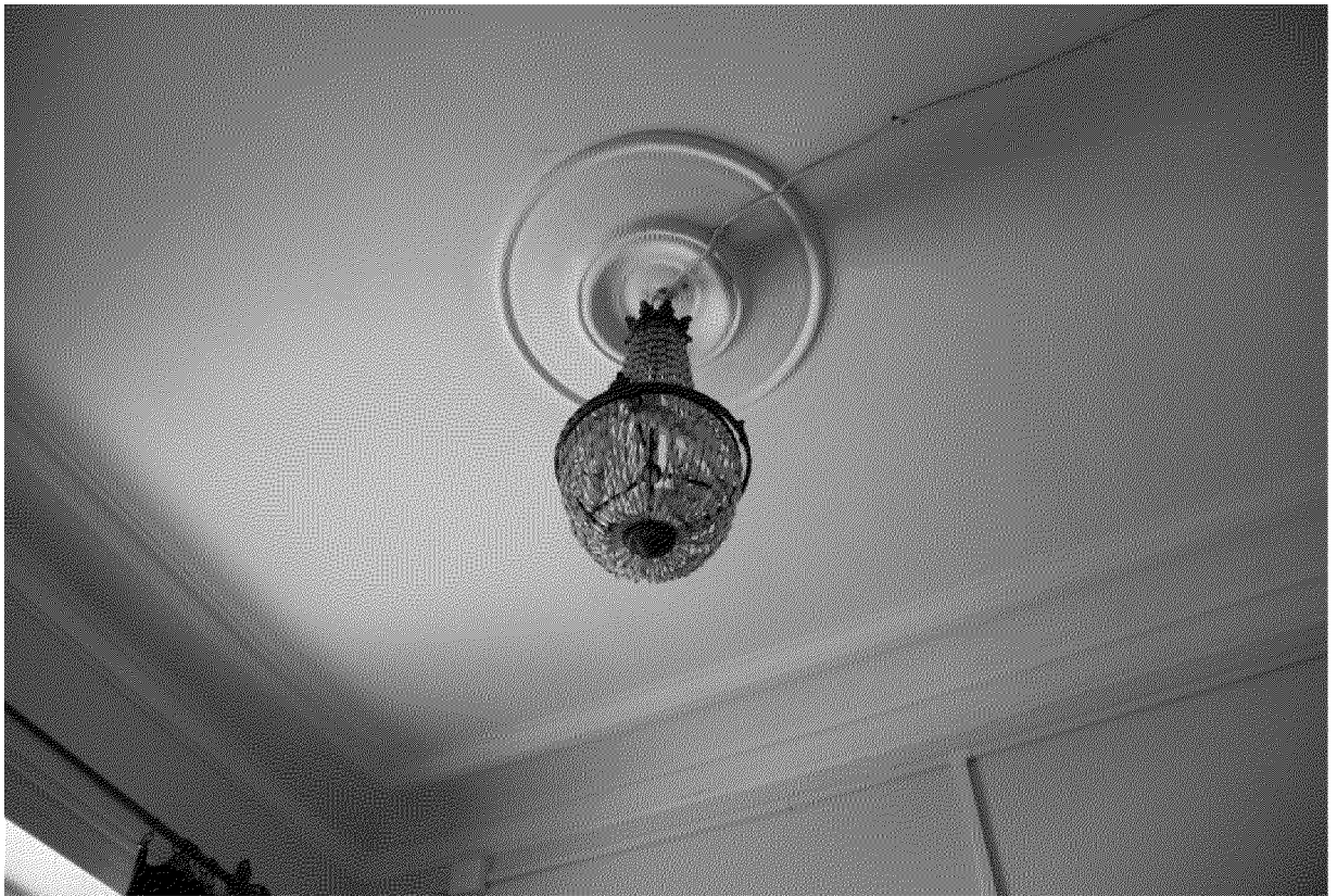
Видовая точка № 21. Фрагмент интерьера. Потолочная розетка. Профильные штукатурные тяги на потолке и в верхней части стен.
