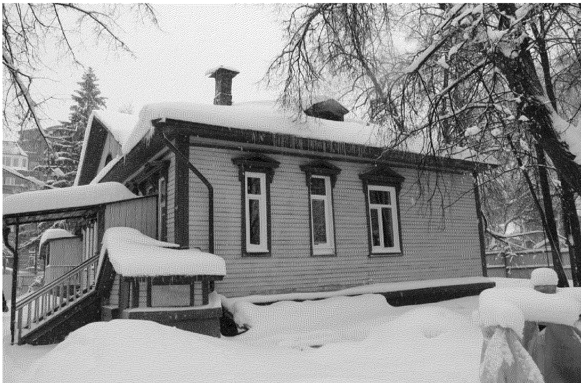
Видовая точка № 6. Западный фасад дома.
