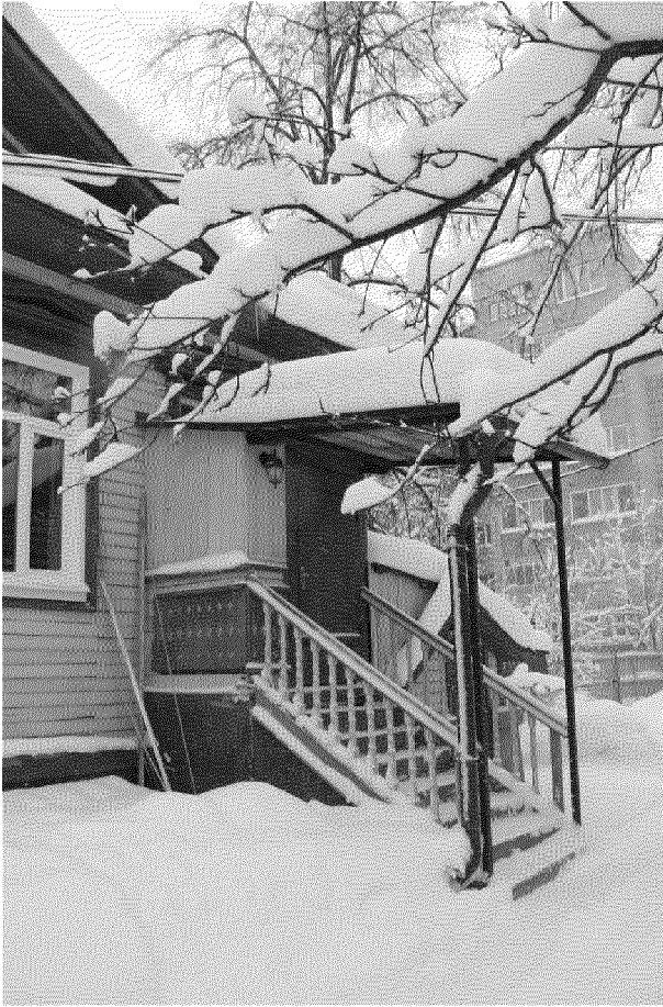
Видовая точка № 10. Крыльцо северного фасада.
