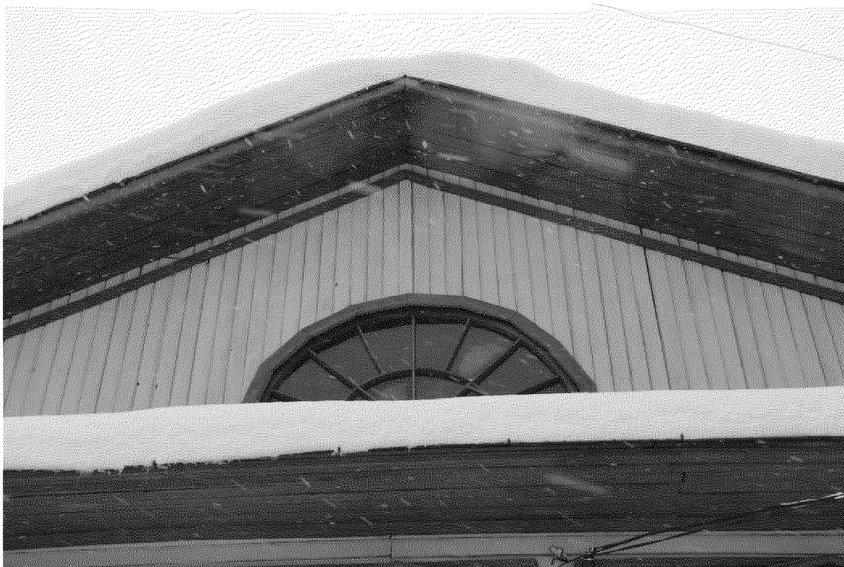
Видовая точка № 8. Чердачное окно фронтона северного фасада.
