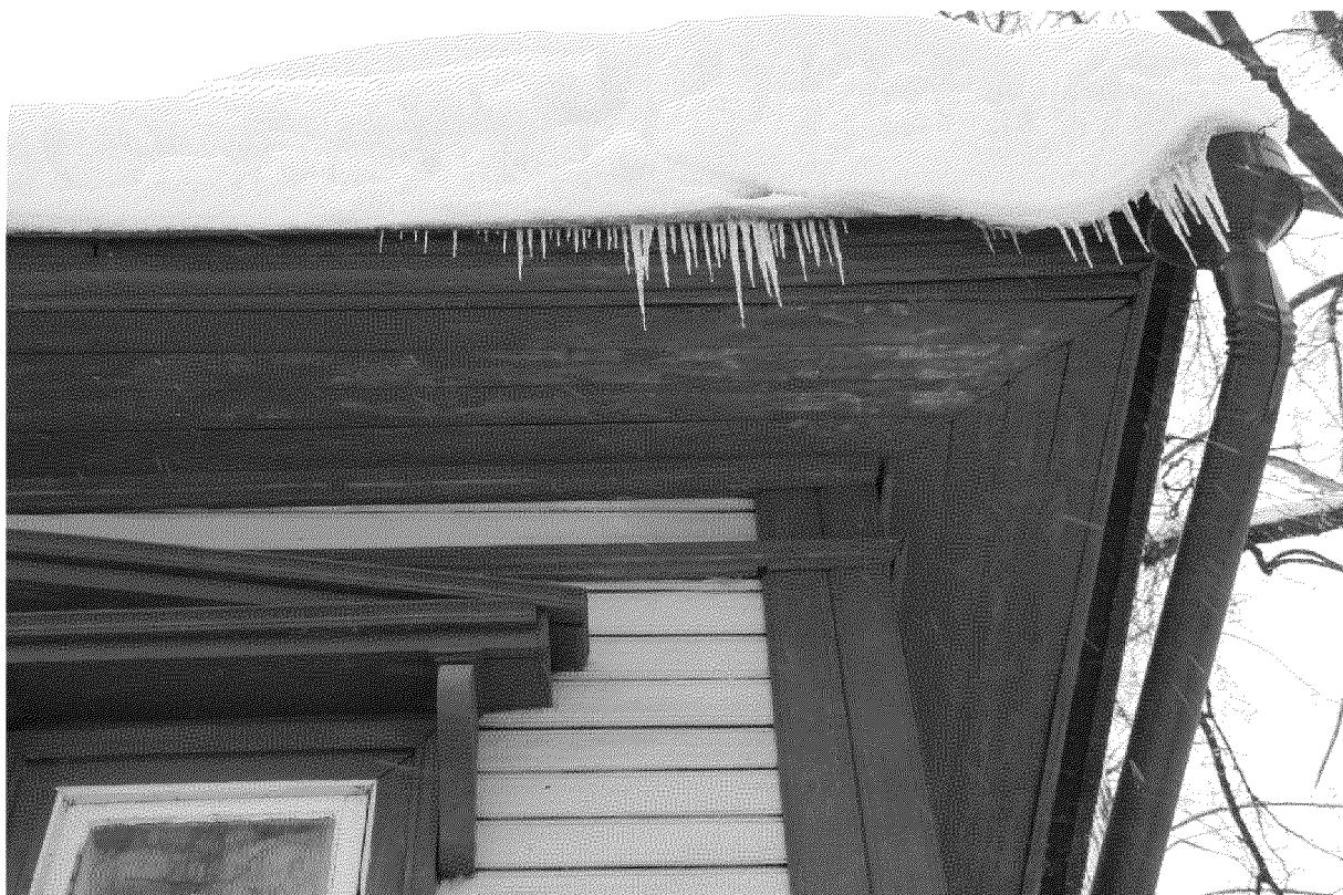
Видовая точка № 9. Карнизная часть дома.
