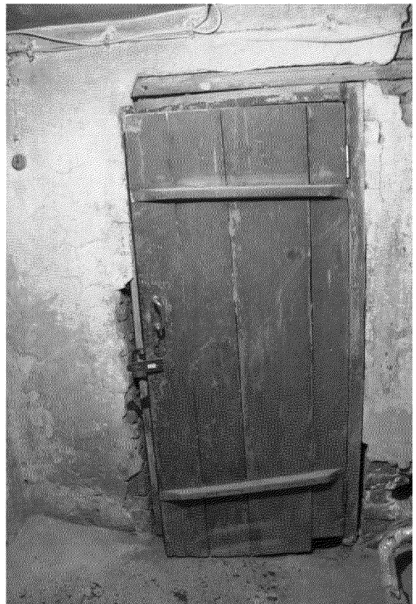
Видовая точка № 16. Внутренняя дверь подвала.
