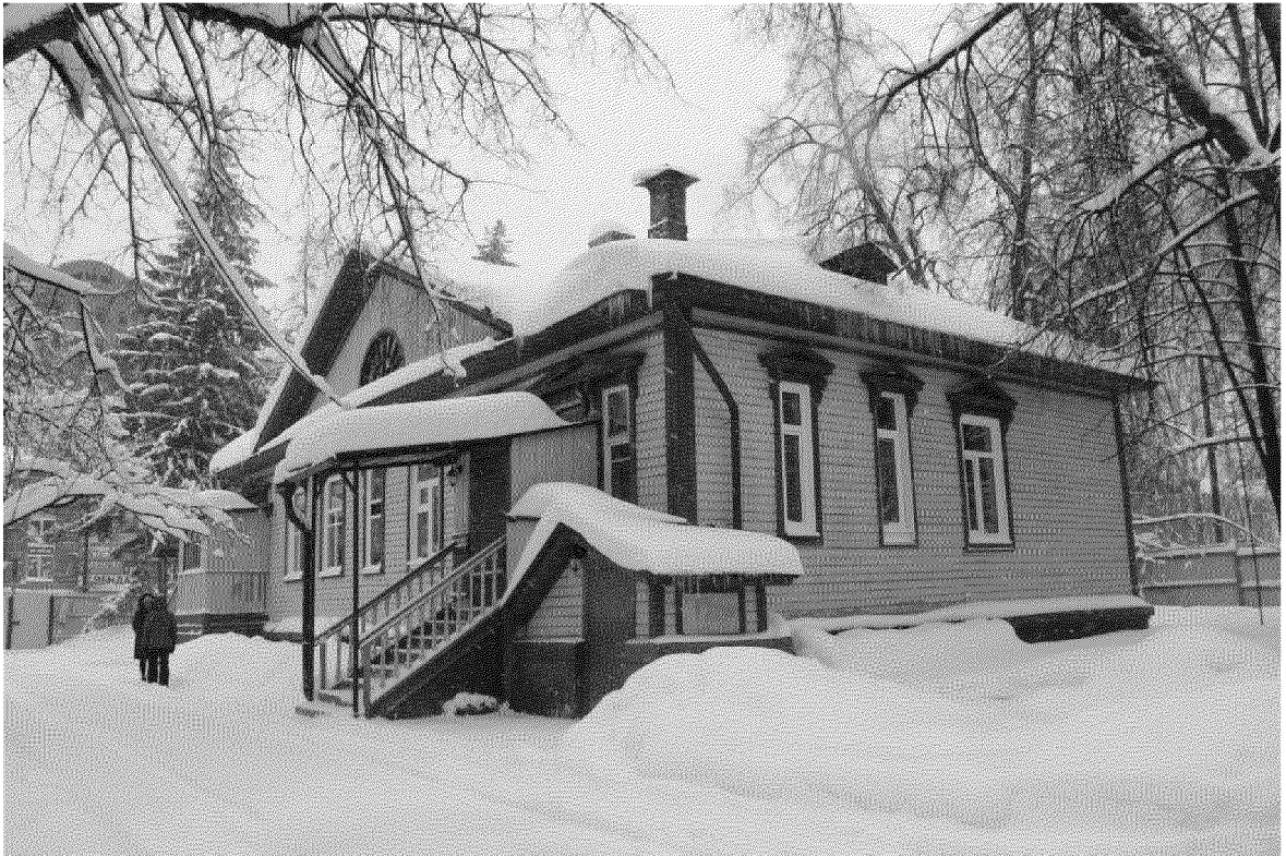
Видовая точка № 3. Общий вид дома с северо-западной стороны.
