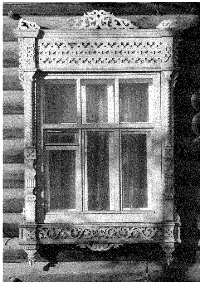
Видовая точка № 8. Окно 1 этажа главного фасада (тип 2).
