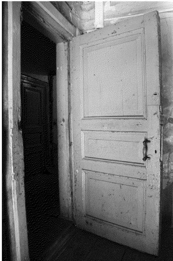
Видовая точка № 18. Дверь входа на 2-й этаж. (фото: Яблонской М.А., 02.04.2015)
