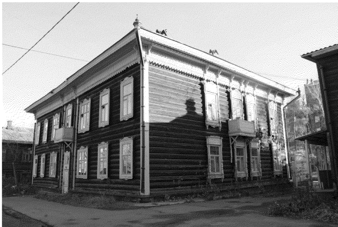
Видовая точка № 2. Общий вид здания с юго-западной стороны (с территории двора).
