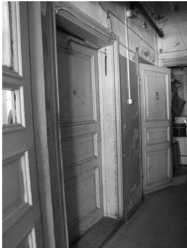
Видовая точка № 24. Деревянные филленчатые двери (фото: Леонтьевой Н.М., 21.08.2014)
