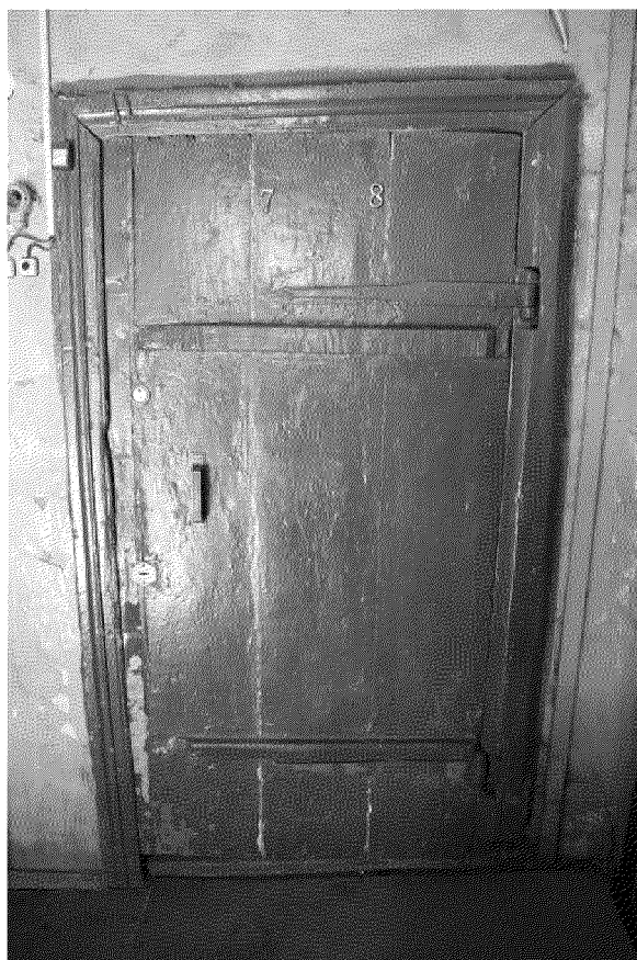
Видовая точка № 20. Дошатая на шпонках дверь 1-го этажа (фото: Яблонской М.А., 02.04.2015)
