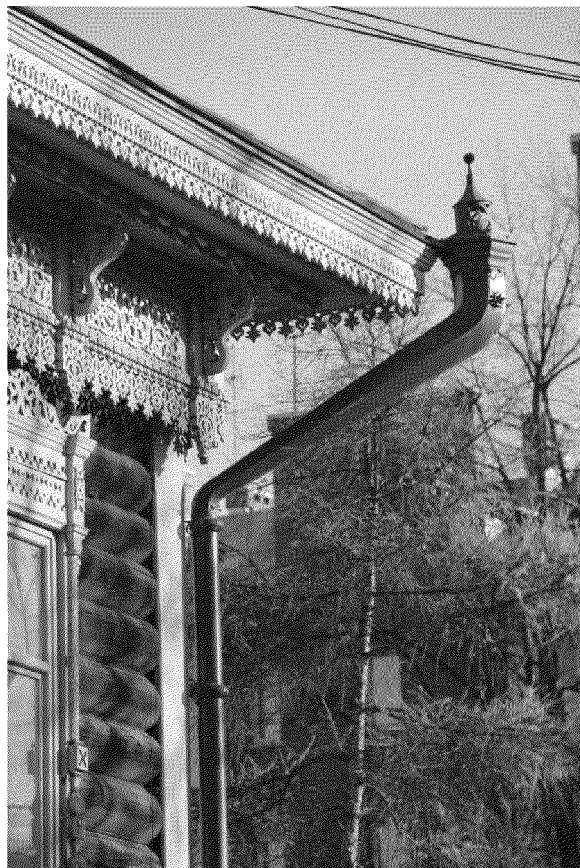
Видовая точка № 6. Фрагмент карниза. Кронштейны.
