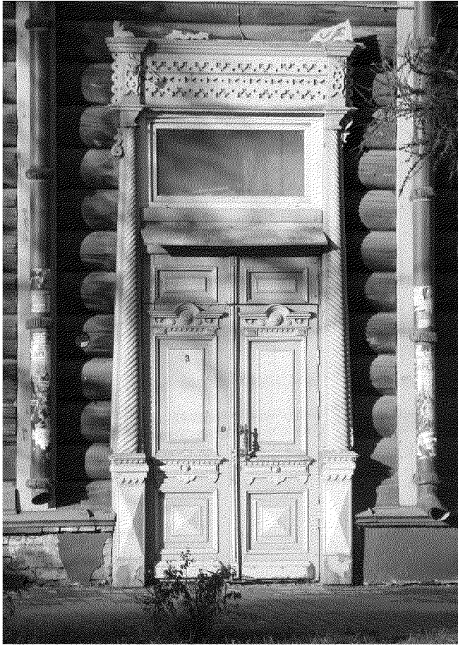
Видовая точка № 9. Парадный вход.
