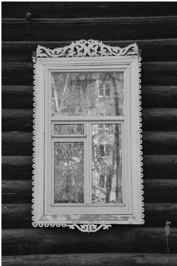
Видовая точка № 11. Окно 1-го этажа дворового фасада.
