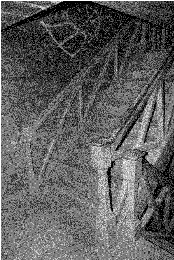
Видовая точка № 15. Деревянная лестница (вход со двора)
