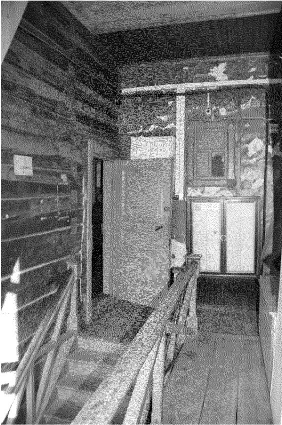
Видовая точка № 13. Деревянная лестница (вход со двора) (фото: Яблонской М.А., 02.04.2015)
