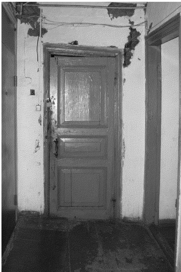
Видовая точка № 21. Деревянная филленчатая дверь в квартиру (фото: Ларовой Е.В., 26.10.2018)
