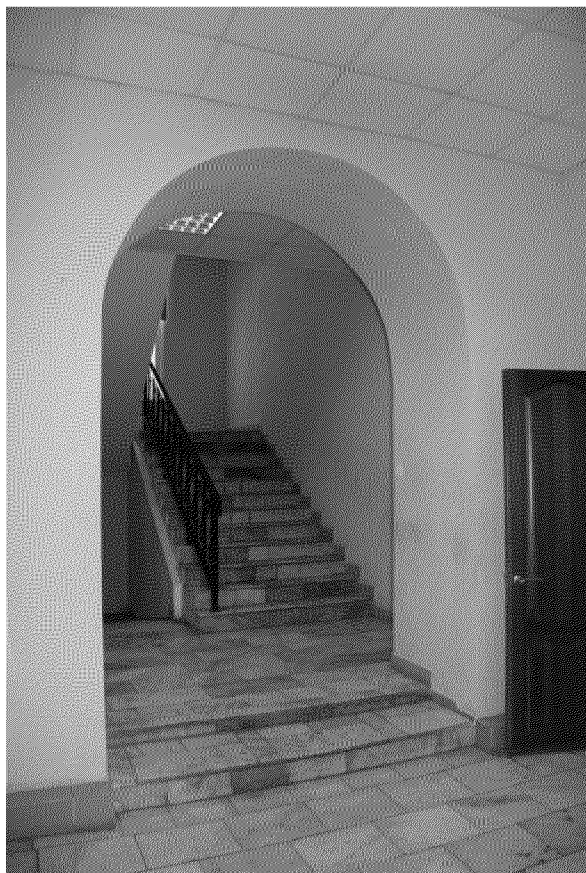
Видовая точка № 10 Арочный проем парадного входа на лестницу (28.01.2019).
