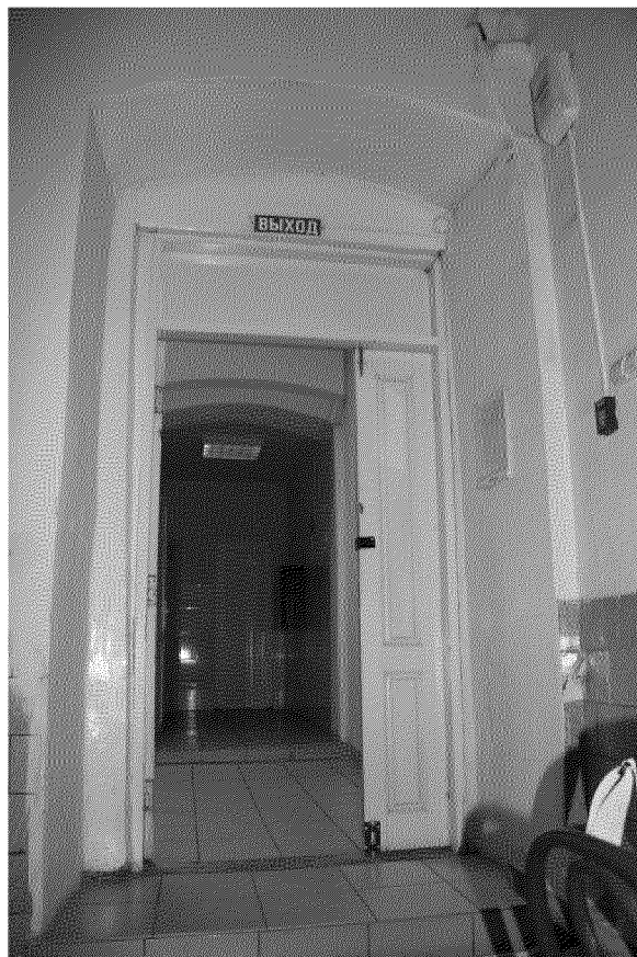
Видовая точка № 11 Лучковые дверные проемы (28.01.2019).
