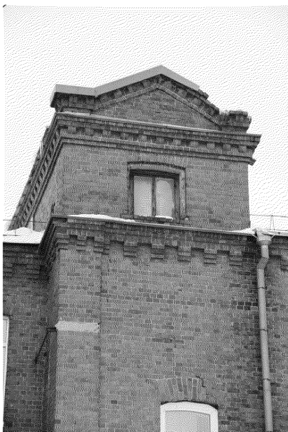
Видовая точка № 8 Фрагмент южного фасада (28.01.2019).
