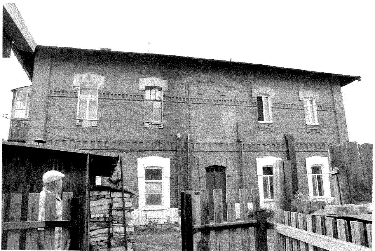
Видовая точка № 4. Восточный (дворовый) фасад здания.
