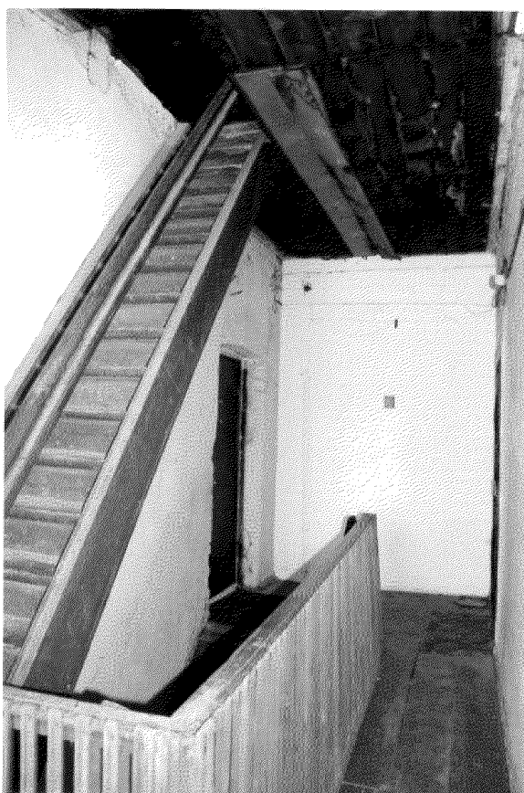
Видовая точка № 9. Деревянная лестница на чердак.
