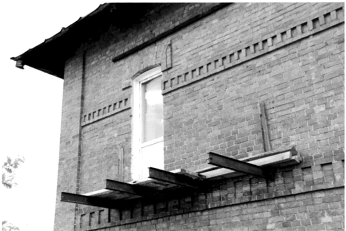
Видовая точка № 6. Местоположение балкона 2-го этажа бокового (северного) фасада. Сохранившиеся металлические конструкции балкона.
