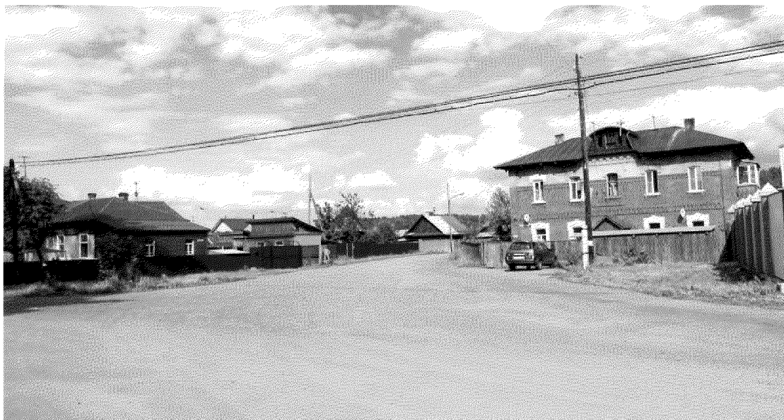
Видовая точка № 1. Общий вид здания с ул. Алеутской.
