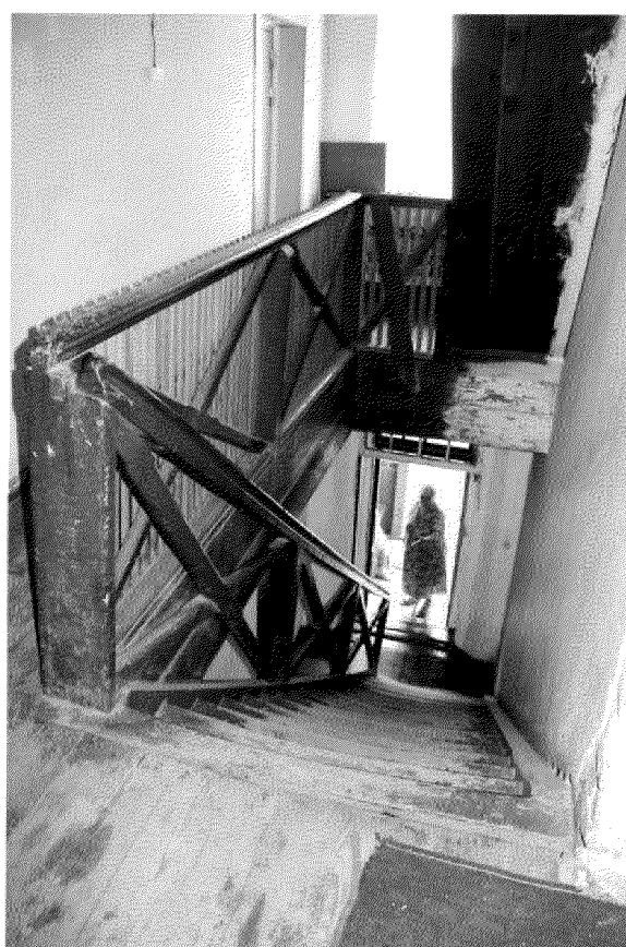
Видовая точка № 10. Деревянная лестница на 2-й этаж.
