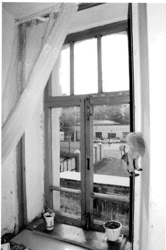
Видовая точка № 7. Окно помещения лестницы (2-й этаж).
