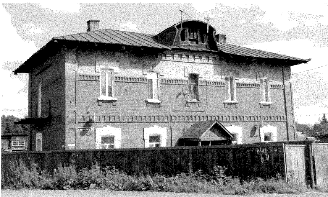
Видовая точка № 2. Главный (западный) фасад здания.
