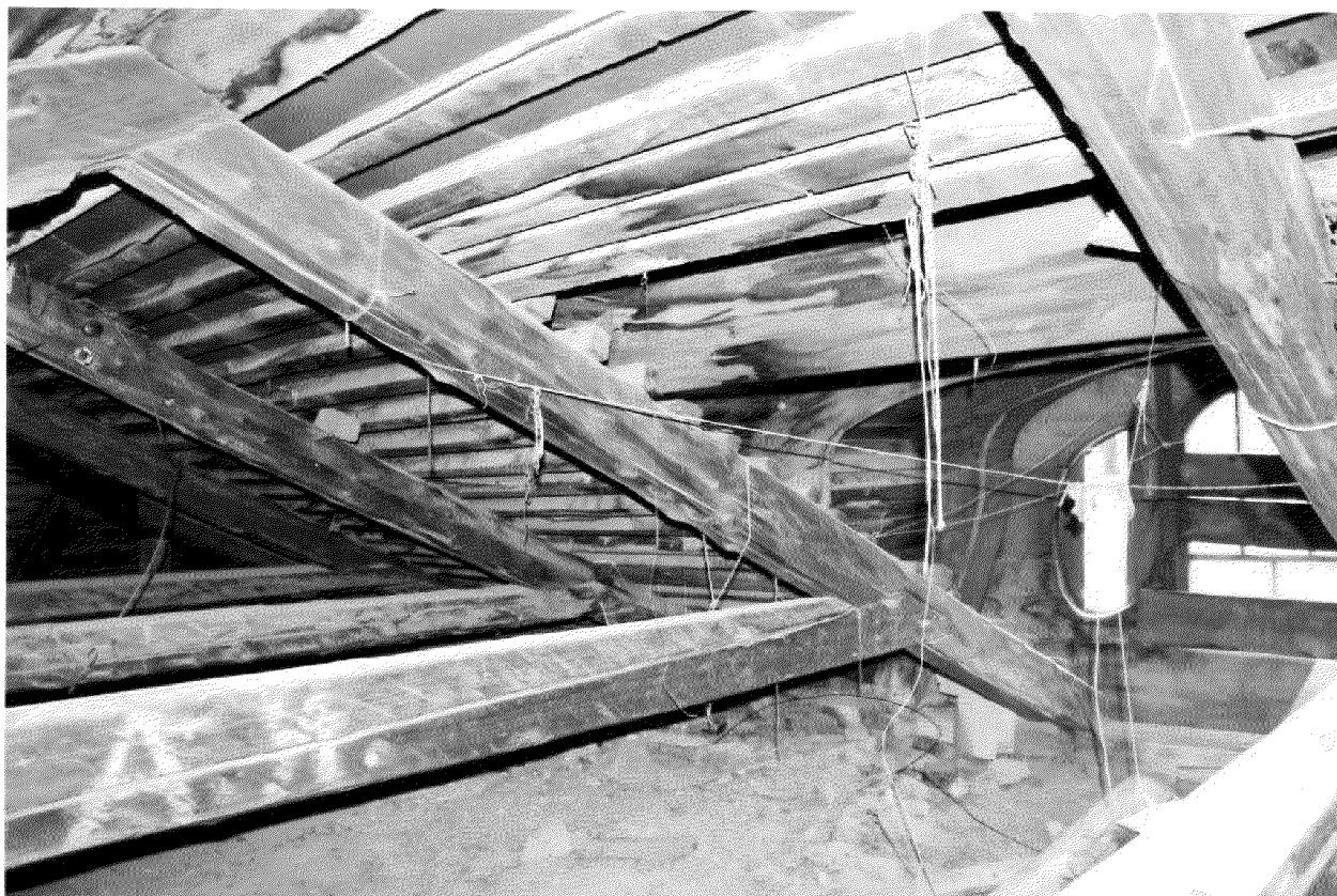
Видовая точка № 11. Фрагмент стропильной системы здания в месте расположения слухового окна.
