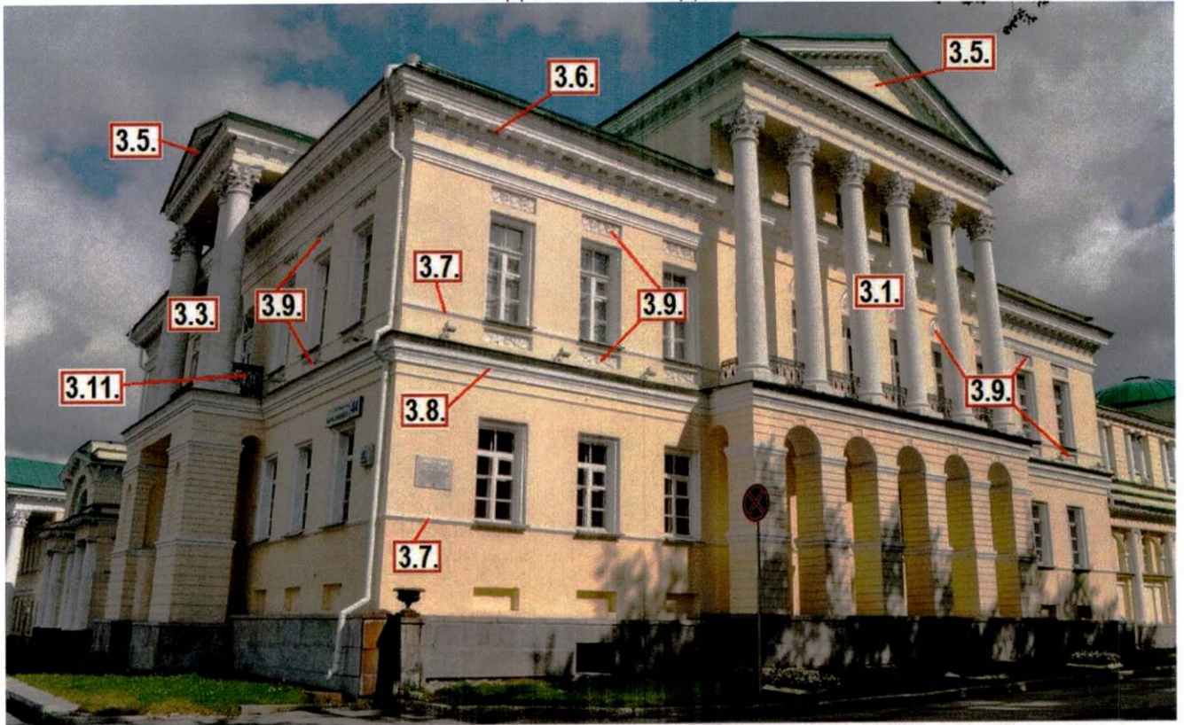
Вид с юго-запада
