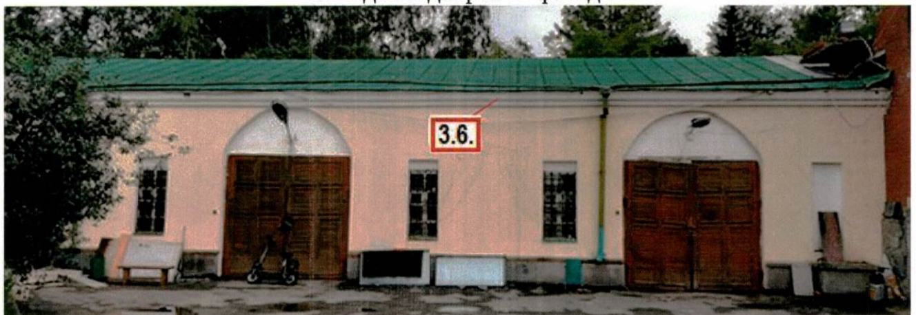
Западный дворовой фасад
