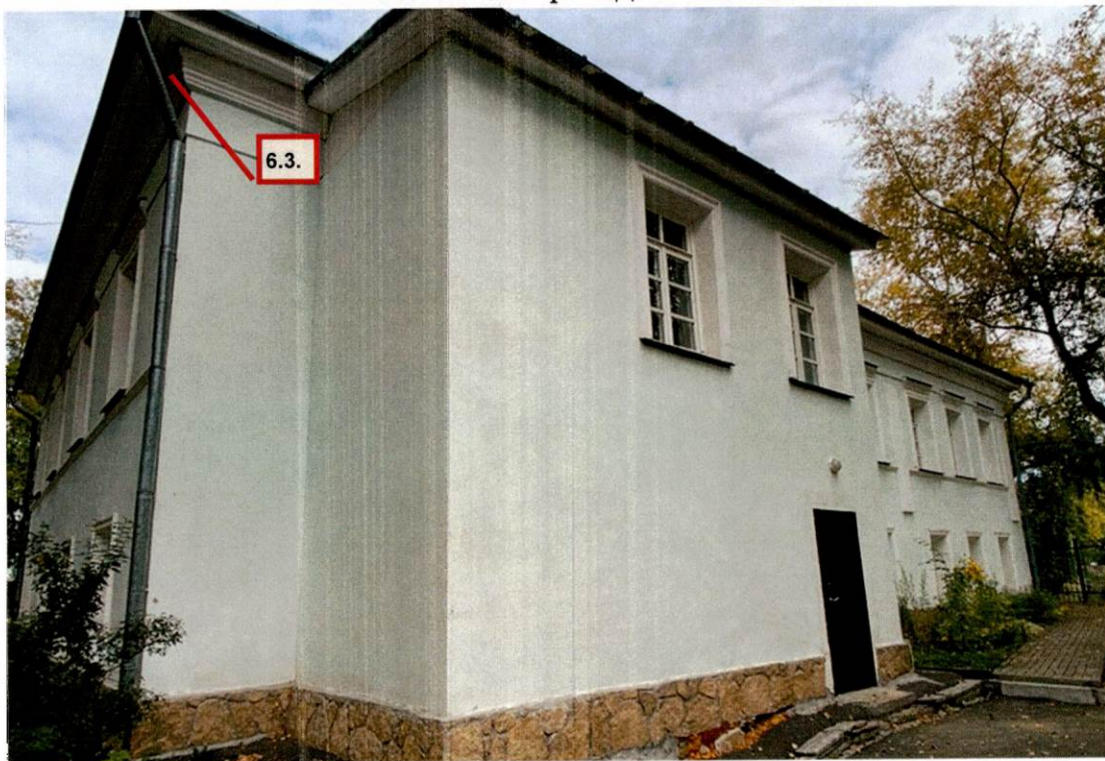
Юго-восточный фасад. Левая часть
