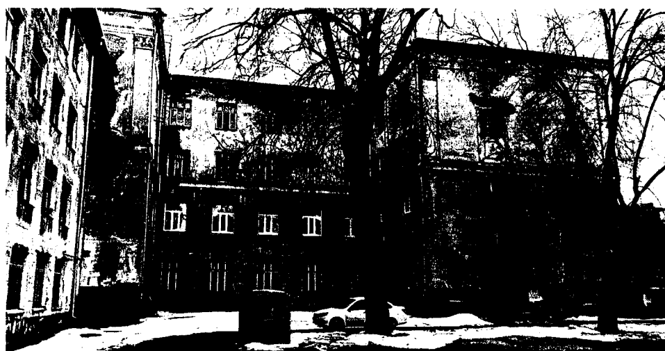
Фото 10. Северный фасад (дворовой)
