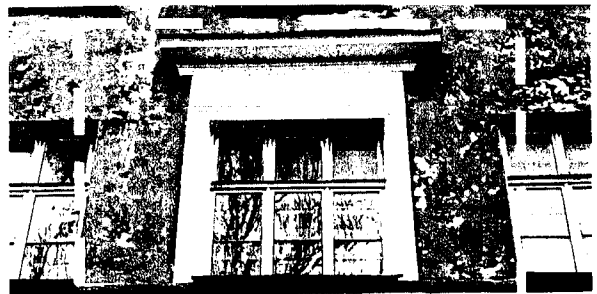
Фото 4. Венчающий карниз, профилированный межэтажный карниз, выступающий цоколь
