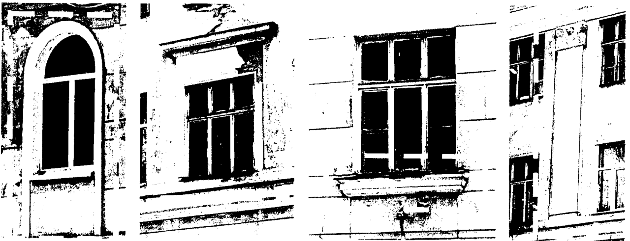
Фото 16. Обрамление арочного оконного проема, сандрик, подоконная полочка, пилястра
