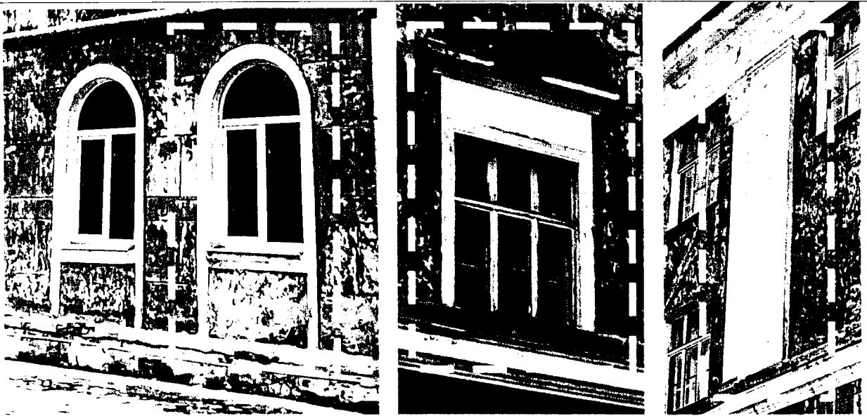
Фото 8. Обрамление арочного оконного проема, сандрик, пилястры
