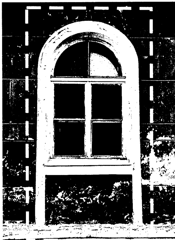
Фото 5. Обрамление арочного оконного проема, сандрик, подоконная полочка
