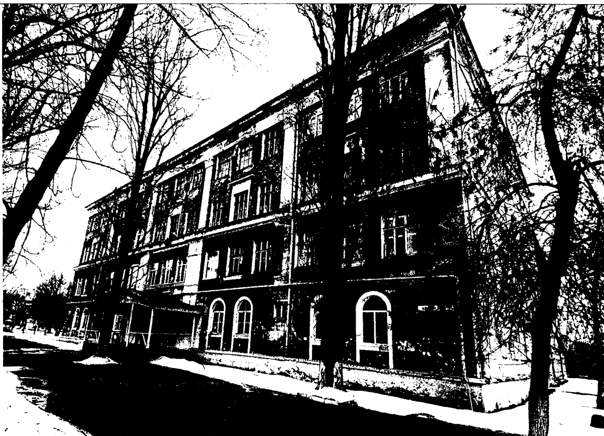
Фото 2. Южный фасад (главный)
