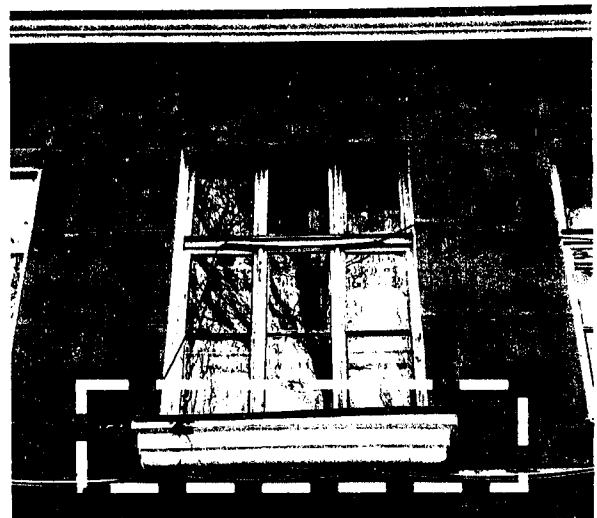
Фото 5. Обрамление арочного оконного проема, сандрик, подоконная полочка
