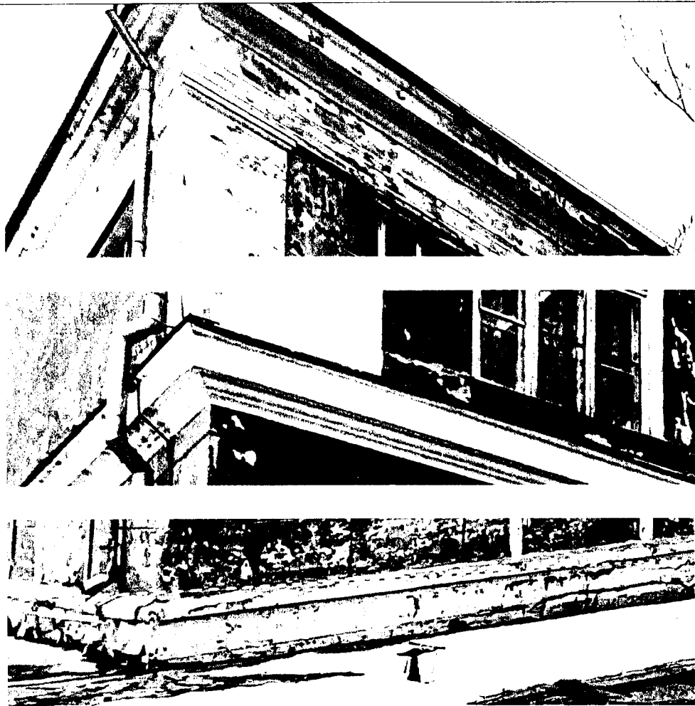
Фото 4. Венчающий карниз, профилированный межэтажный карниз, выступающий цоколь
