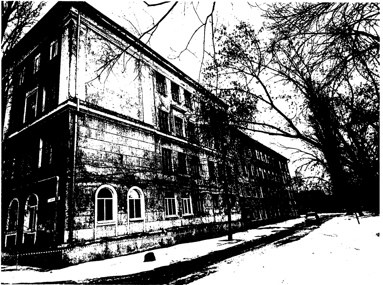
Фото 15. Восточный фасад (боковой)
