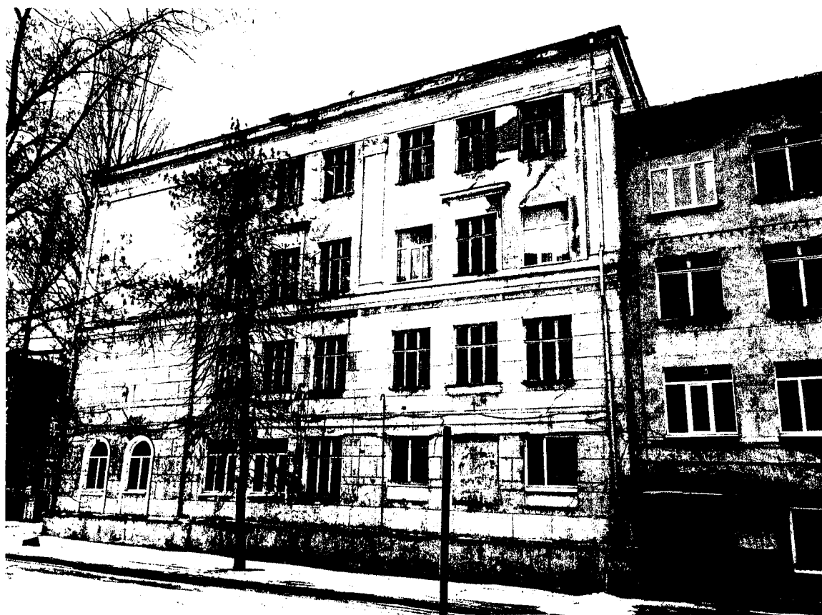
Фото 14. Восточный фасад (боковой)
