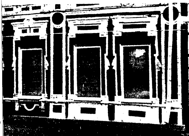
Оконные проемы первого этажа
