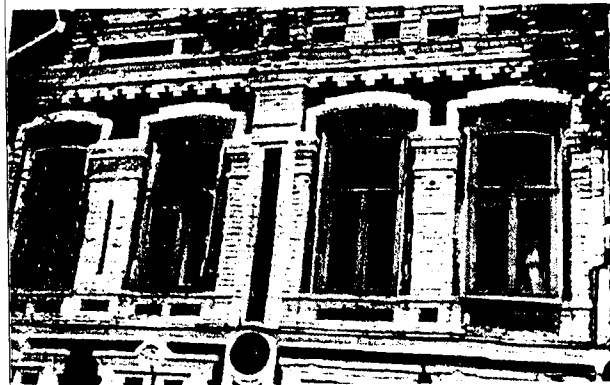
Оконные проемы второго этажа
