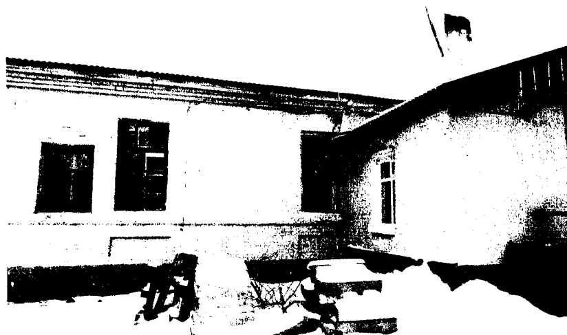
Фото 5. Фрагмент северо-восточного фасада.
