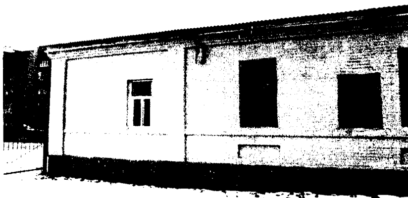
Фото 4. Фрагмент северо-восточного фасада.
