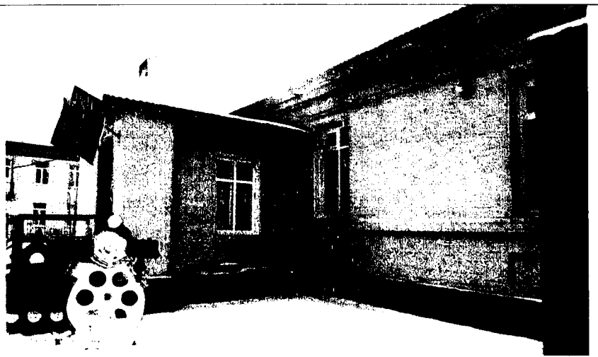
Фото 7. Фрагмент северо-восточного фасада.
