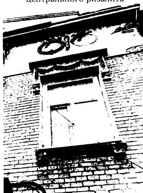
Оконный проем второго этажа центрального ризалита
