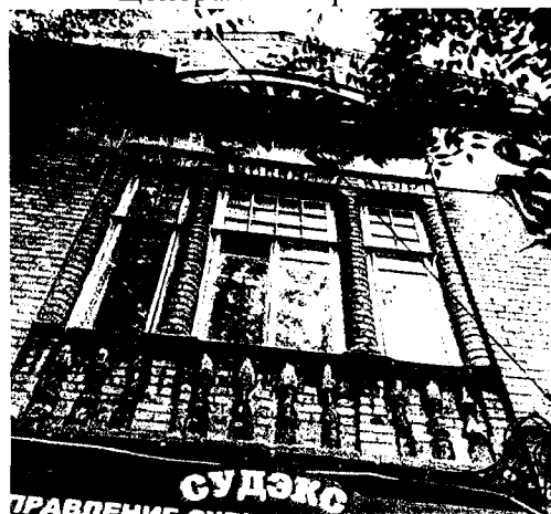
Оконные проемы второго этажа центрального ризалита
