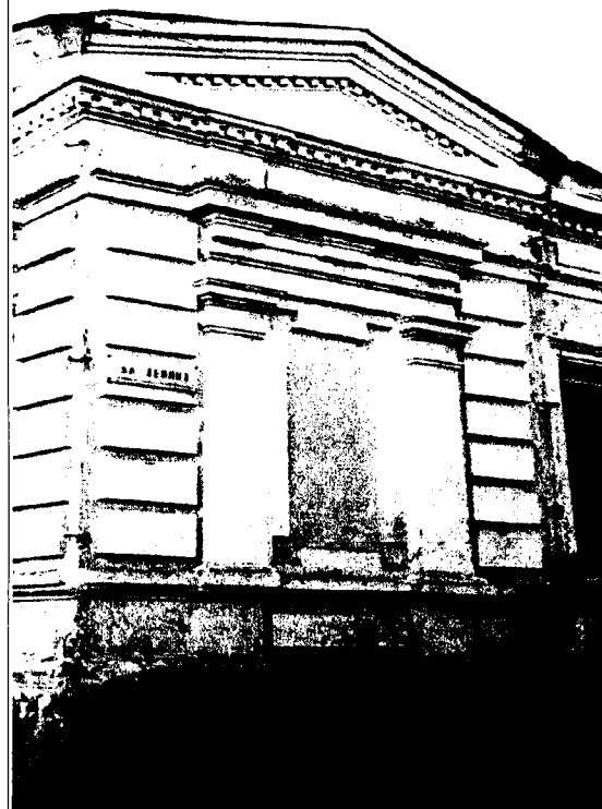
Боковой ризалит восточного фасада
