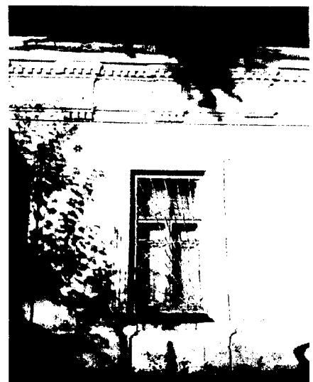
Оконный проем западного фасада
