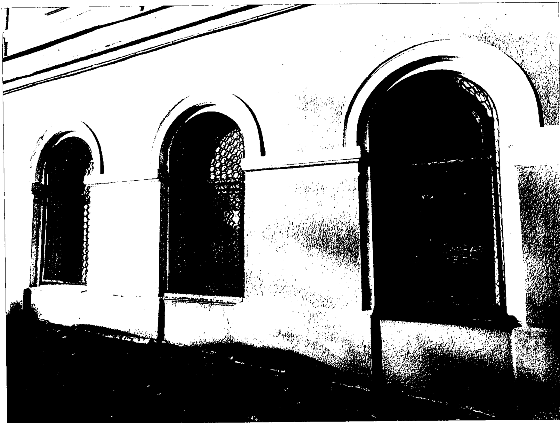
13. Юго-восточный фасад по ул. Октябрьской. Фото 29.11.2022 г.
