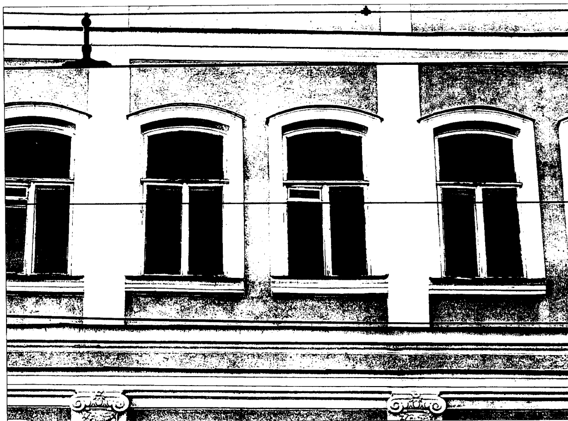
9. Северо-восточный (главный) фасад по ул. Московской. Фото 29.11.2022 г. Прямоугольные проемы с лучковым завершением в уровне третьего этажа. Профилированные наличники и подоконные карнизы. Двойной межэтажный карниз в уровне третьего этажа.
