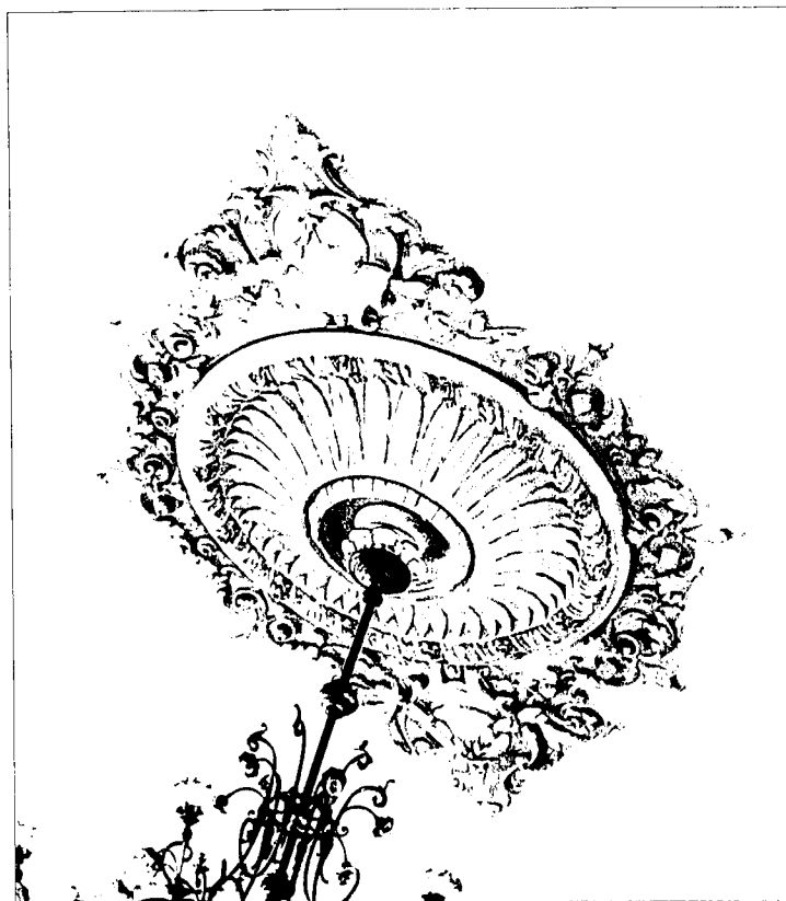
43. Интерьер. Помещение П2. Фото 29.11.2022 г. Архитектурный лепной декор. Центральная потолочная розетка.
