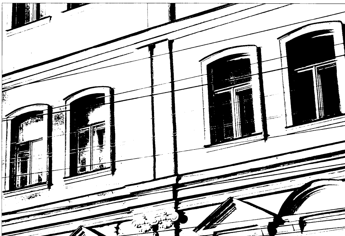
22. Юго-восточный фасад по ул. Октябрьской. Фото 29.11.2022 г. Сдвоенные лопатки третьего этажа. Двойной межэтажный карниз в уровне третьего этажа с раскреповкой по пилястрам. Оформление проемов третьего этажа.
