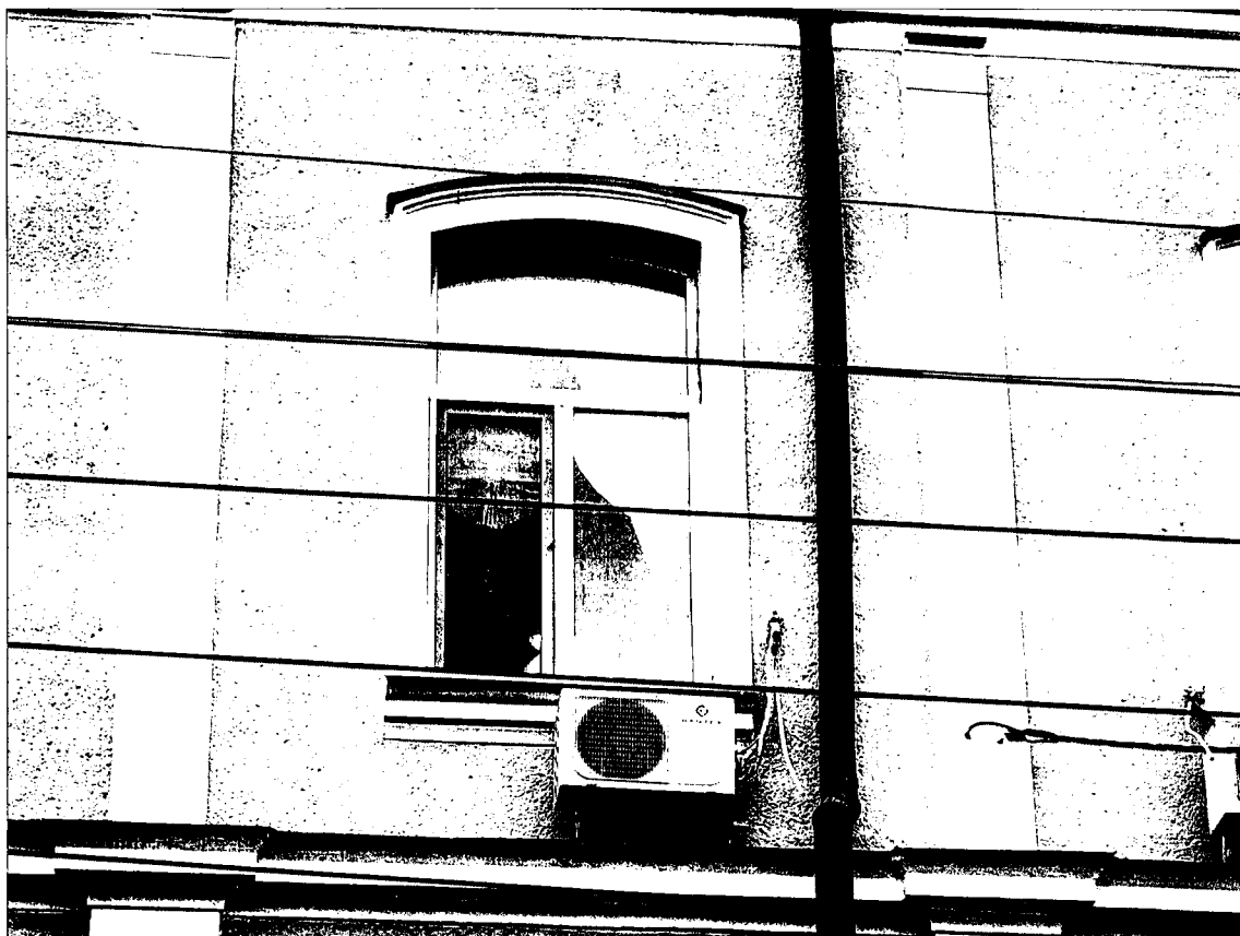
21. Юго-восточный фасад по ул. Октябрьской. Фото 29.11.2022 г. Лопатки третьего этажа. Оформление проемов третьего этажа.
