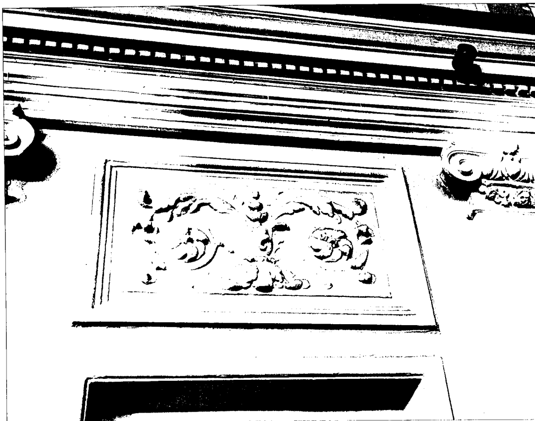
37. Интерьер. Помещение П2. Фото 29.11.2022 г. Архитектурный лепной декор. Декоративные филенки с барельефами над проемами нижнего уровня. Межэтажный карниз с сухариками
