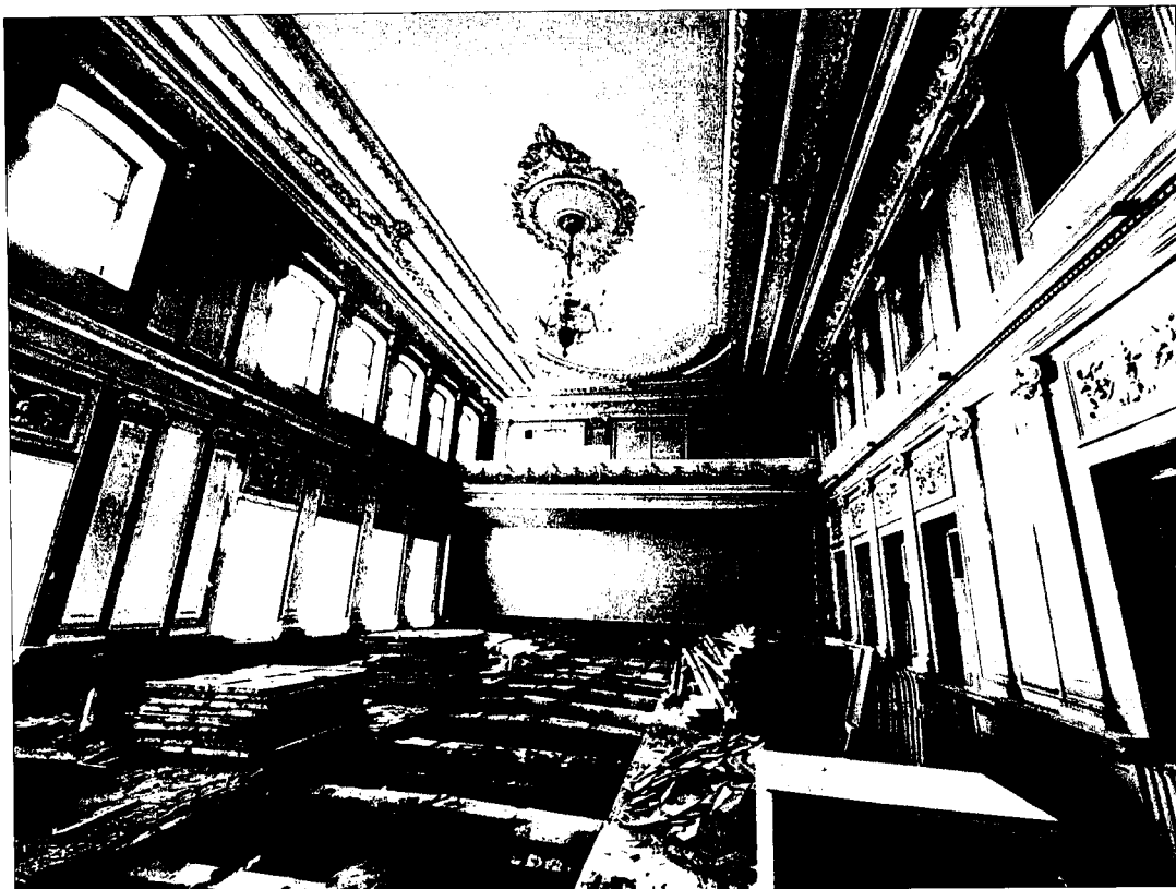
32. Интерьер. Помещение И2. Фото 29.11.2022 г. Двусветный зал. Пространственно-планировочная структура зала: прямоугольный двусветный, с разделением на уровни межэтажным карнизом, с балконом в верхнем уровне вдоль южной торцевой стены.
