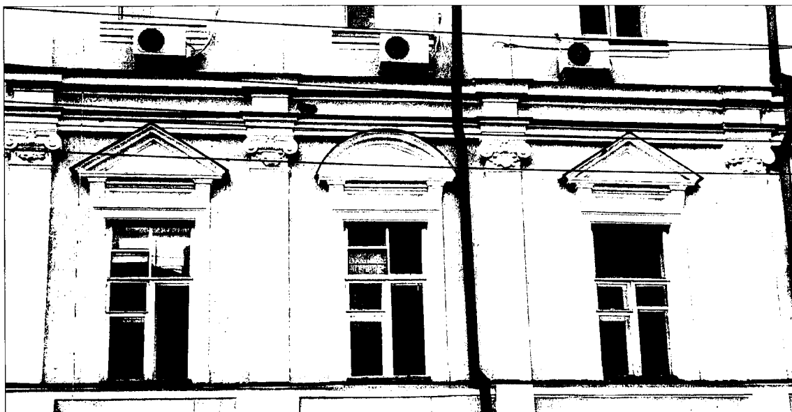
17. Юго-восточный фасад по ул. Октябрьской. Фото 29.11.2022 г.
