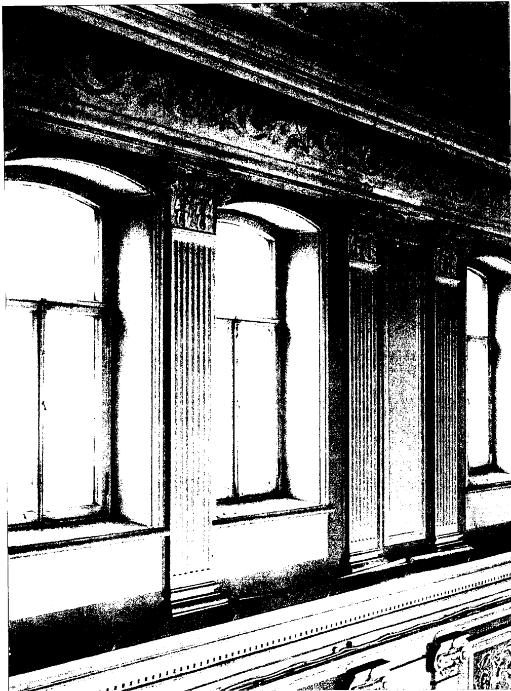
36. Интерьер. Помещение 112. Фото 29.11.2022 г. Архитектурный лепной декор.
