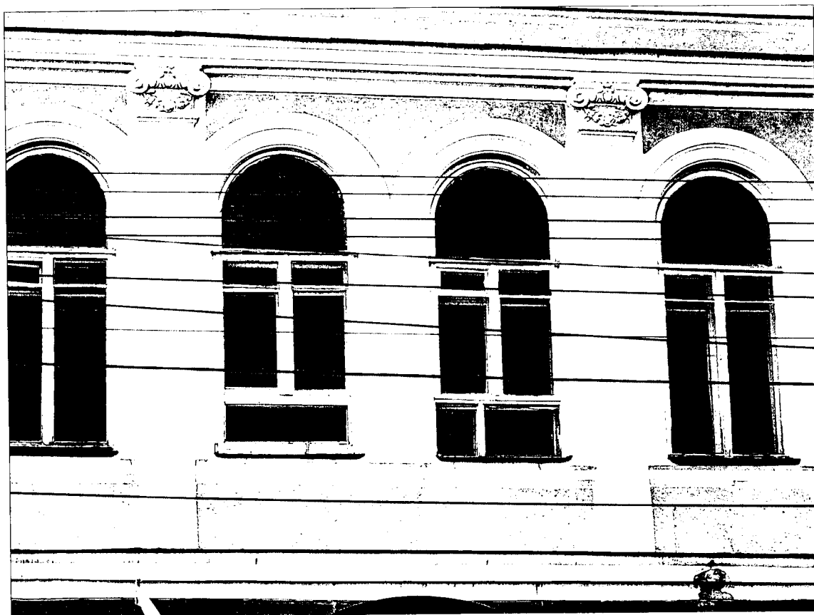
6. Северо-восточный (главный) фасад по ул. Московской. Фото 29.11.2022 г. Вытянутые арочные проемы центральной части фасада в уровне второго этажа. Профилированное декоративное оформление проемов. Филенчатые пилястры центральной части второго этажа. Межэтажные и подоконный карнизы.
