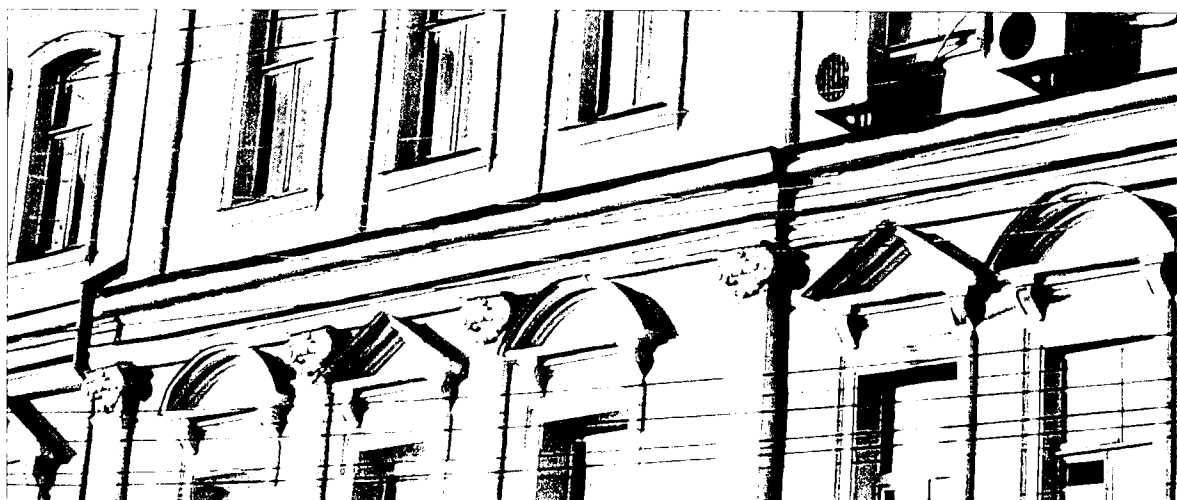
24. Юго-восточный фасад по ул. Октябрьской. Фото 29.11.2022 г.
