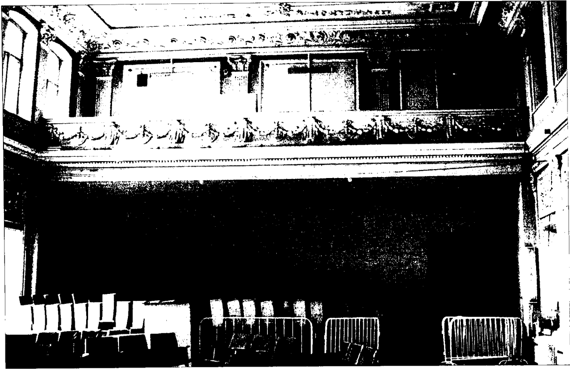
39. Интерьер. Помещение 112. Фото 04.10.2022 г. Архитектурный лепной декор. Южная торцевая стена с балконом. Оформление ограждения балкона. Декоративные элементы верхнего уровня: пилястры, филенчатые обрамления простенков.
