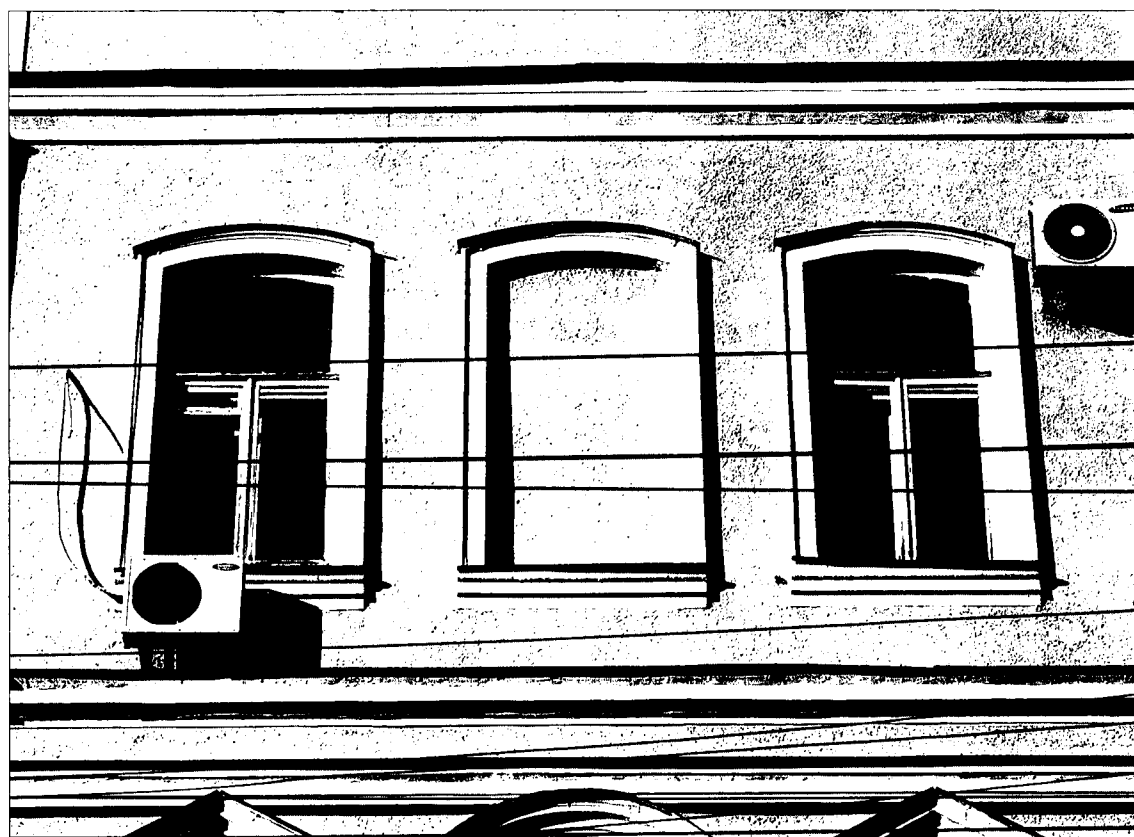
18. Юго-восточный фасад по ул. Октябрьской. Фото 29.11.2022 г.
