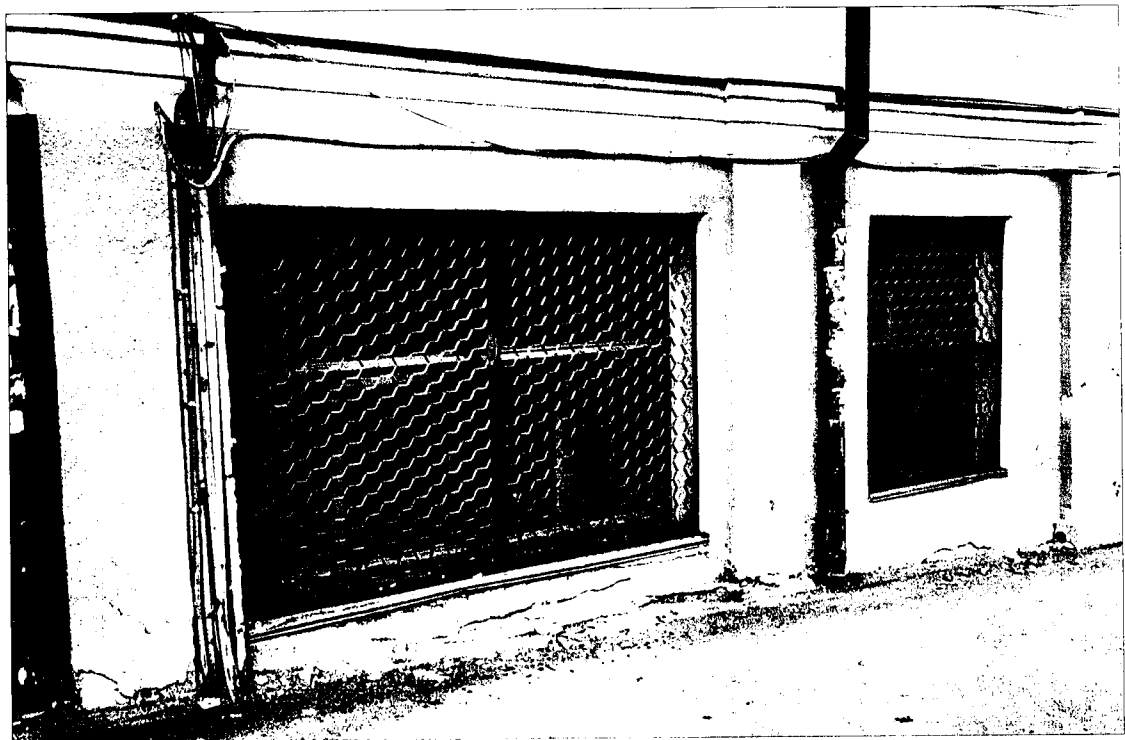
16. Юго-восточный фасад по ул. Октябрьской. Фото 29.11.2022 г.
