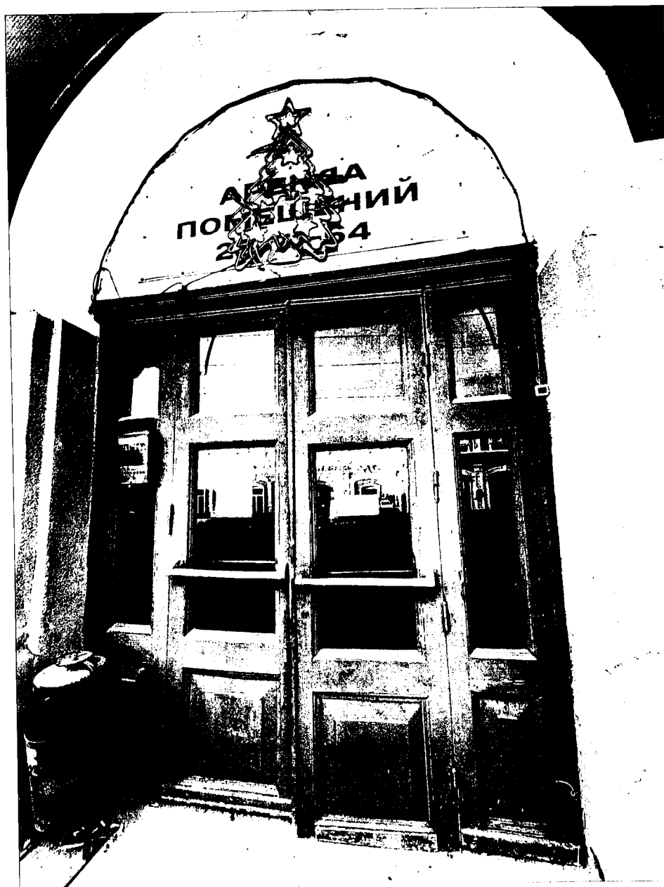
5. Северо-восточный (главный) фасад по ул. Московской. Фото 29.11.2022 г. Проем главного входа по центральной композиционной оси.
