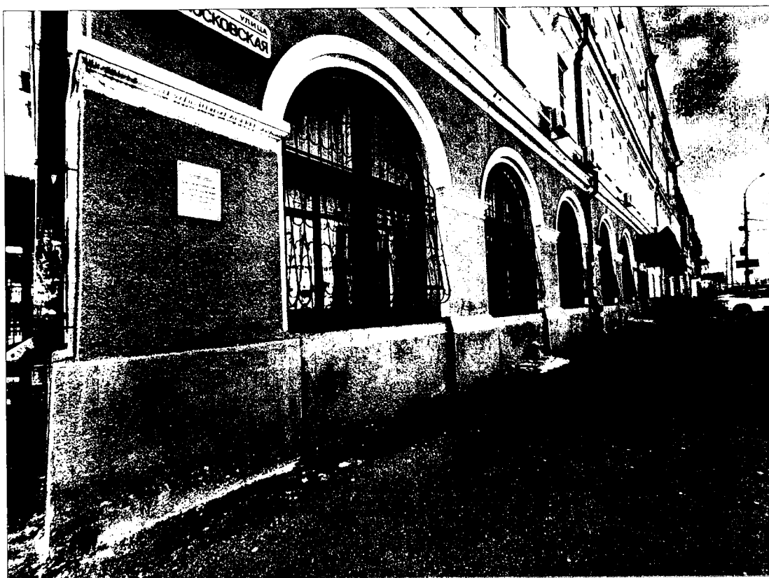
4. Северо-восточный (главный) фасад по ул. Московской. Фото 29.11.2022 г. Крупные арочные проемы с полуциркульным завершением в уровне первого этажа. Декоративное оформление световых проемов профилированными архивольтами, опирающимися на импосты. Цоколь с раскреповкой по простенкам
