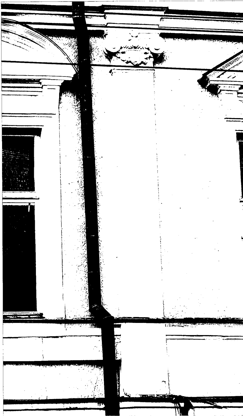
19. Юго-восточный фасад по ул. Октябрьской. Фото 29.11.2022 г. Пилястры второго этажа. Подоконный карниз проемов второго этажа.
