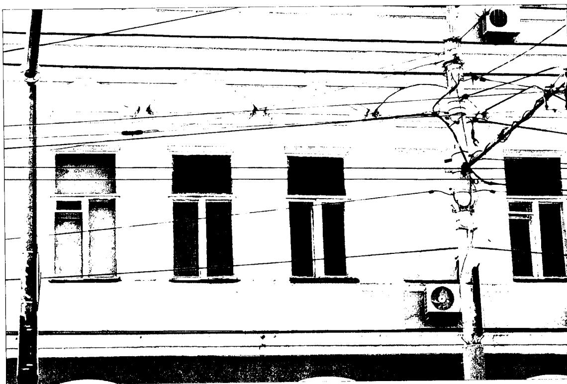
7. Северо-восточный (главный) фасад по ул. Московской. Фото 29.11.2022 г. Прямоугольные проемы боковых частей фасада в уровне второго этажа. Декоративное оформление проемов. Межэтажный и подоконный карнизы.
