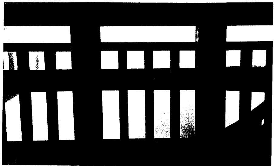
Фрагмент лестницы (ограждение)
