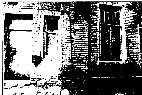
Фрагмент главного фасада (первый этаж)
