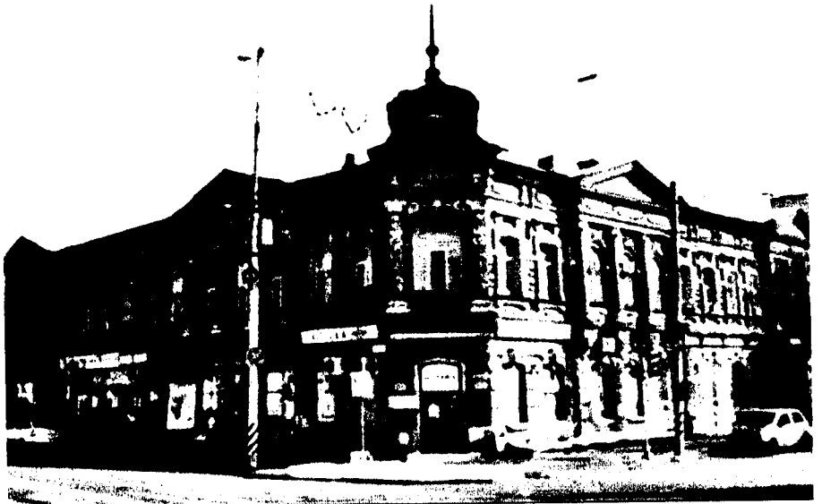
Общий вид. Фасады по ул. Чапаева и Сакко и Ванцетти
