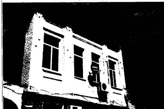
Оконные проемы второго этажа
