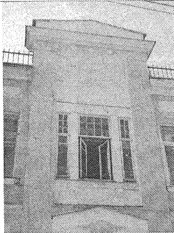
Фрагмент центрального ризалита в уровне 2-го этажа
