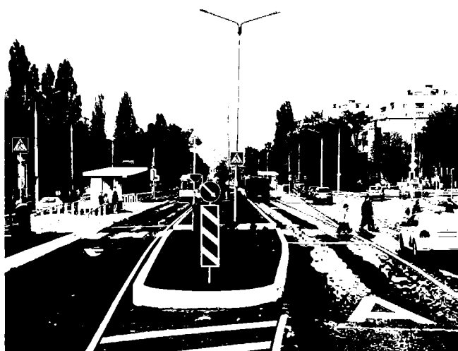
Рис. 114. Организация выделенной полосы по оси проезжей части на ул. Щорса в г. Белгороде
