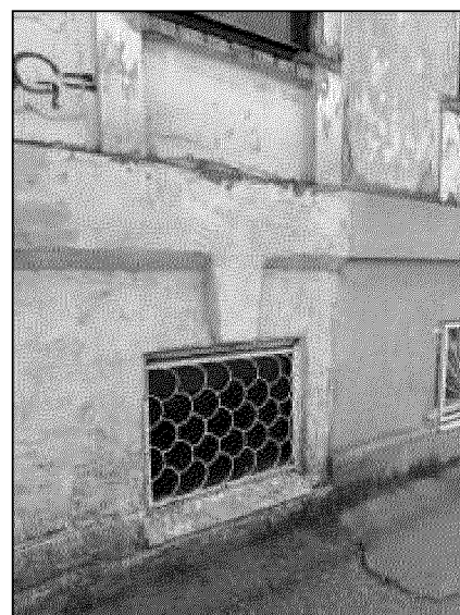
окно в уровне цокольного этажа на парадном северо-западном фасаде
