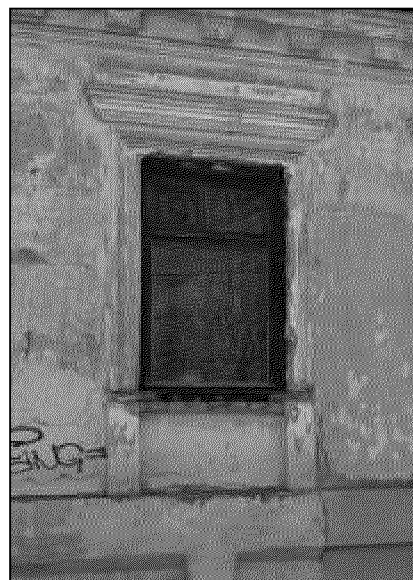
оконный проем в уровне 1-го этажа
