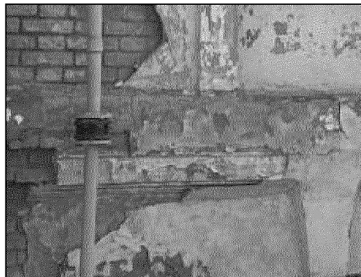
сохранившийся фрагмент парадного северо-западного фасада
