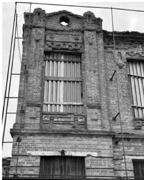
северная раскреповка западного парадного фасада;
