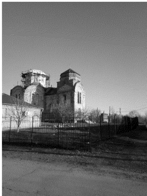
общий вид объекта культурного наследия с северо-запада;
