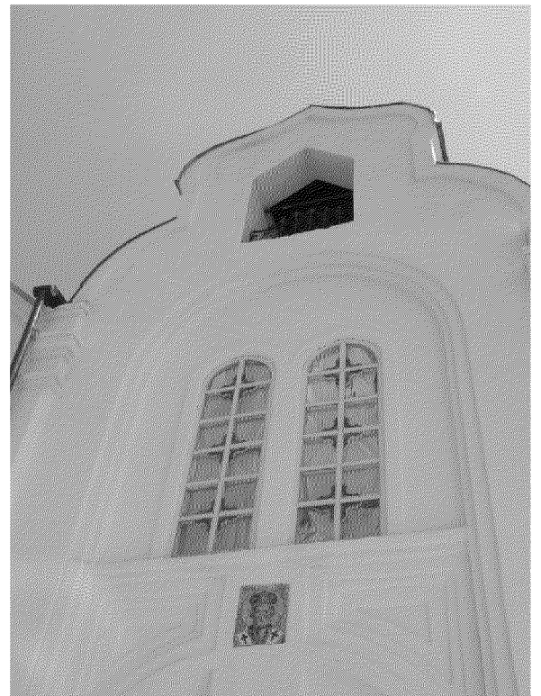
фрагмент западного фасада объекта культурного наследия;
