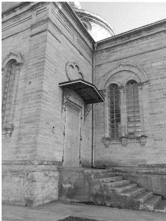
фрагмент северного фасада объекта культурного наследия (северный вход);
