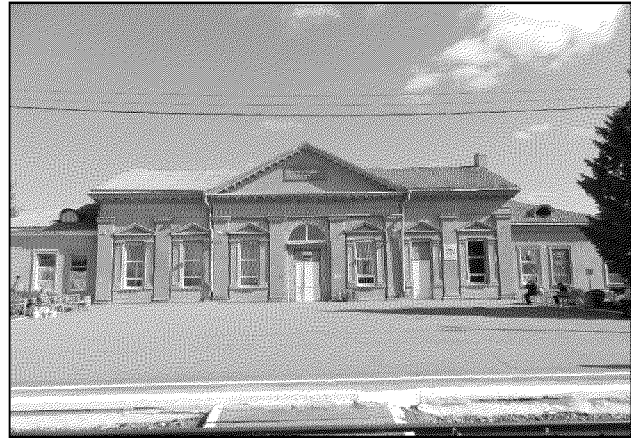
западный фасад объекта культурного наследия;
