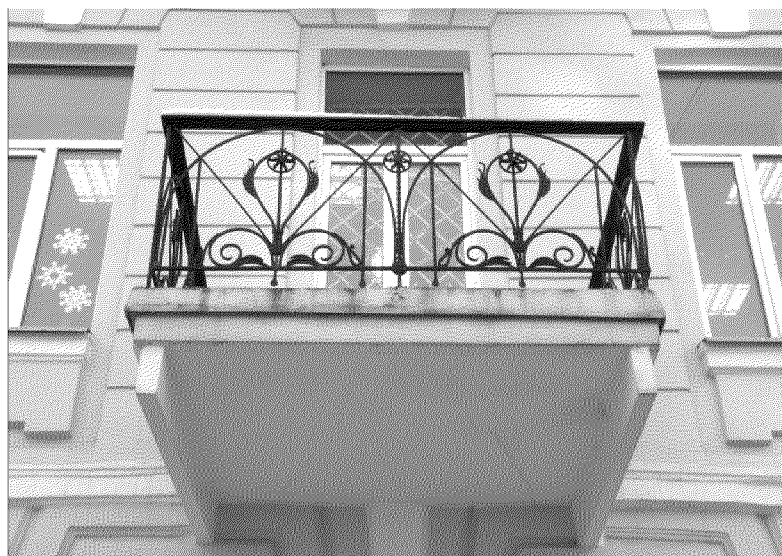
балкон 2-го этажа;
